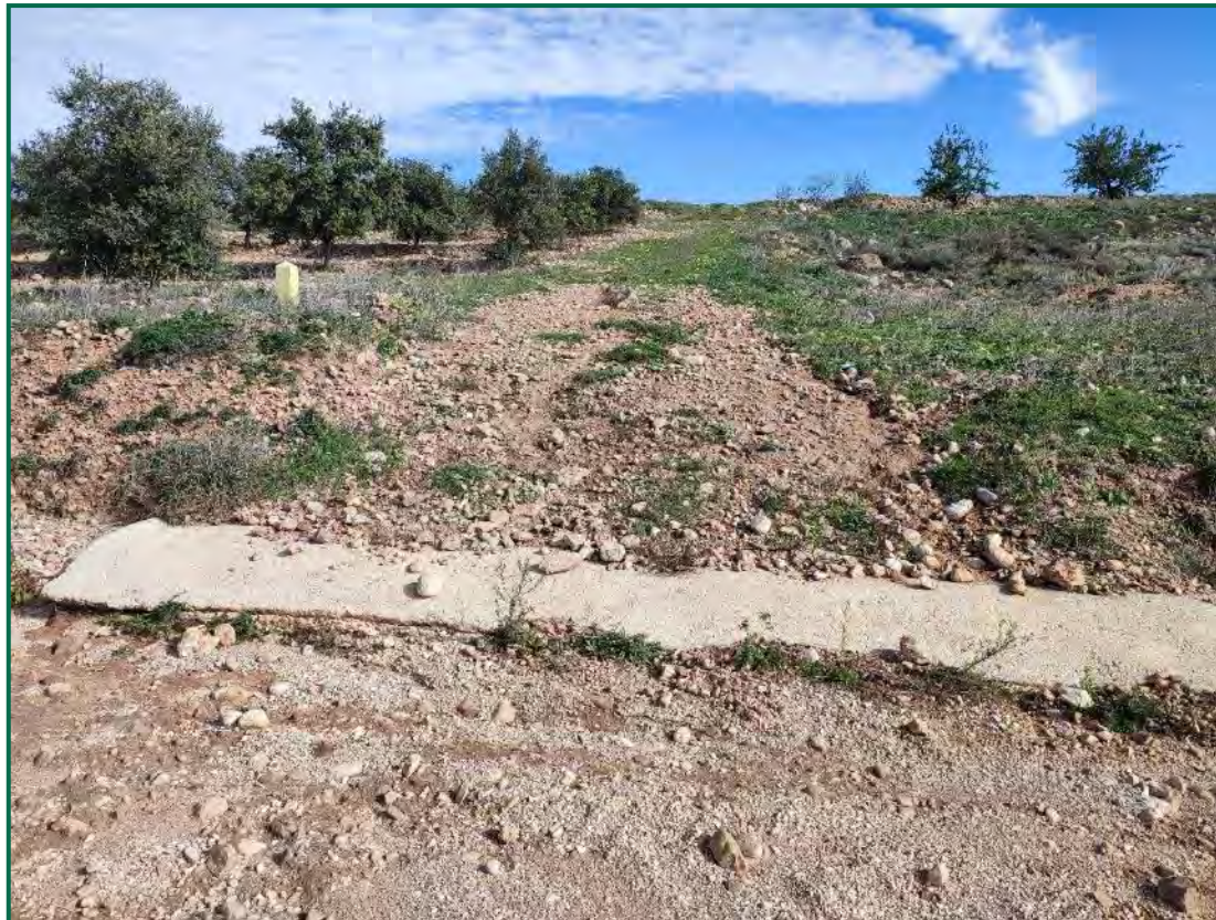
Fotografía 15. Estado zona de salida del arrastre de material por la escorrentía sobre la pista.
