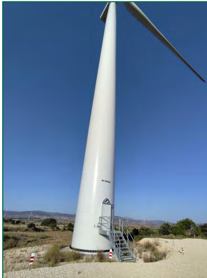
Fotografía 7. Base plataforma A1.4
