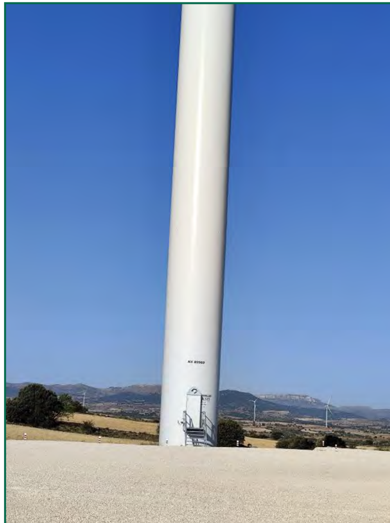
Fotografía 6. Base plataforma A1.3
