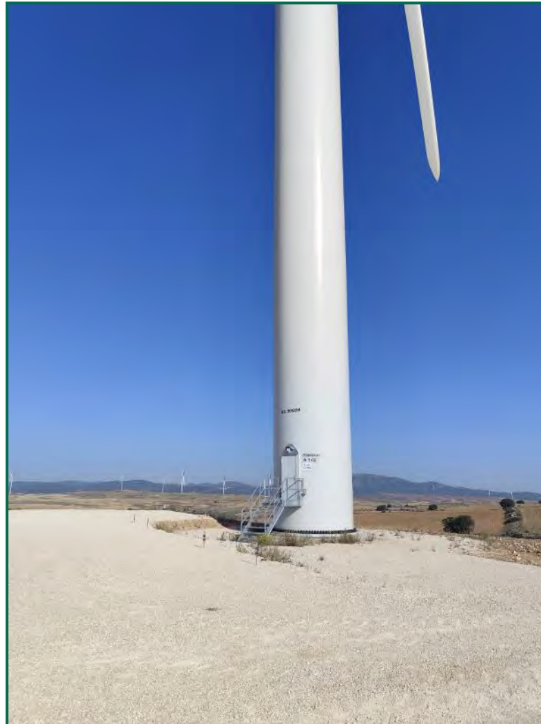
Fotografía 5. Base plataforma A1.2
