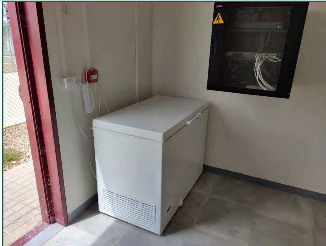
Fotografía 30. Arcón para almacenamiento de aves siniestradas, dentro de la SET.
