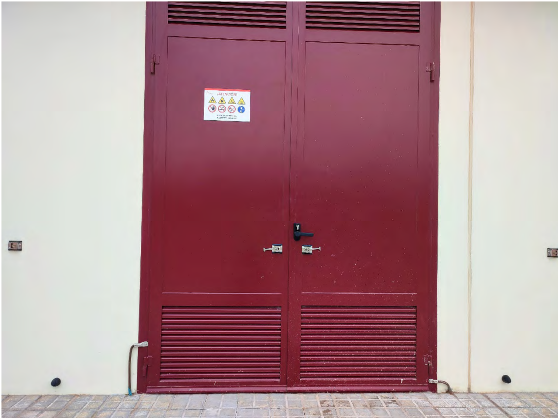
Imagen 7. Cartel de aviso de peligro por residuos contaminantes.
