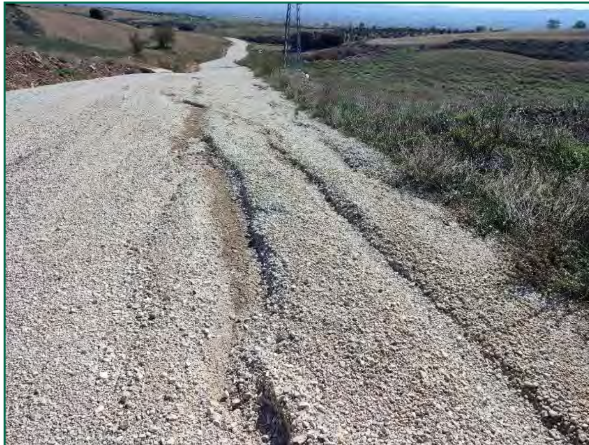
Fotografía 13. Pista entre la SET y A1.01
