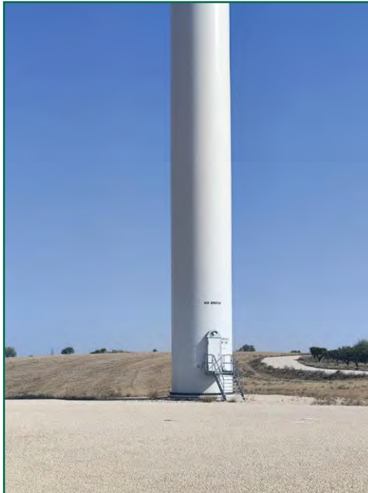
Fotografía 4. Base plataforma A1.1
