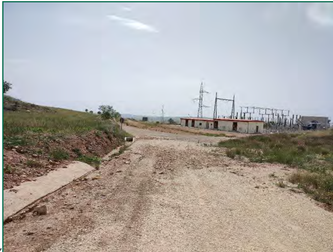
Fotografía 14. Pista a la SET.
