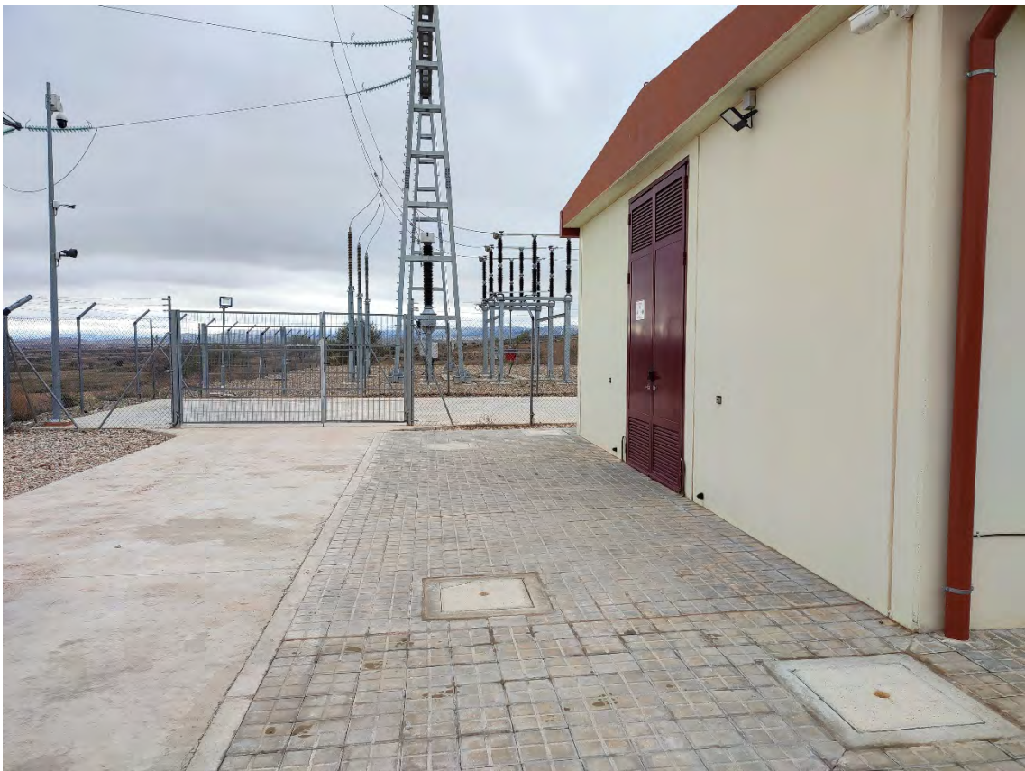
Imagen 4. Pista acceso a las puertas de los almacenes de productos peligrosos.
