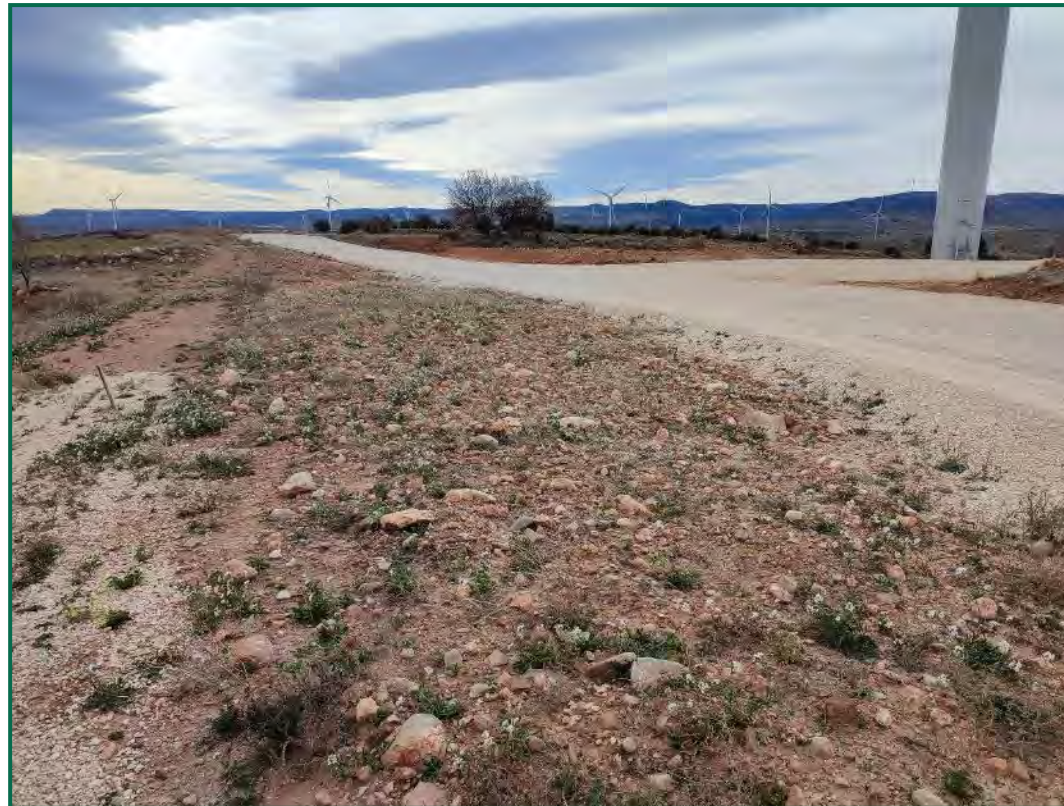
Fotografía 12. Estado de los taludes y vegetación.
