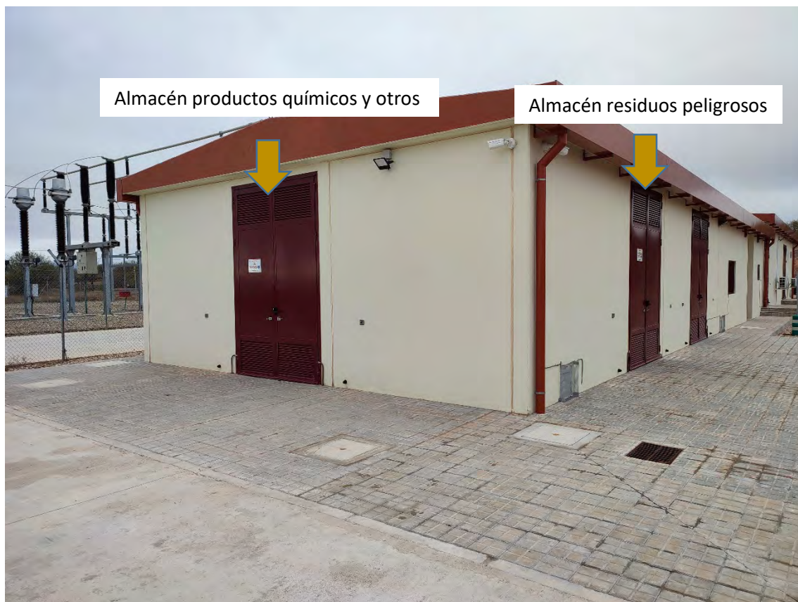
Imagen 5. Puertas de acceso rápido desde vehículo para la retirada de residuos por el gestor autorizado.
