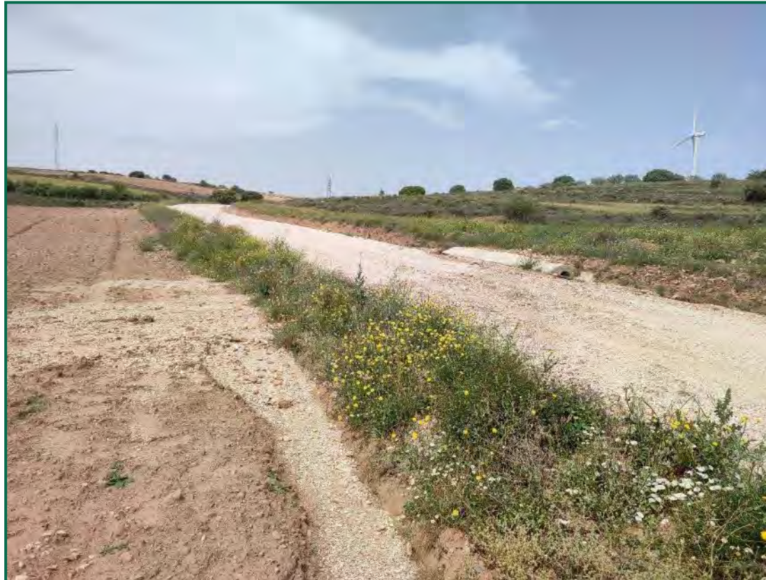
Fotografía 10. Estado pista de acceso a la SET.
