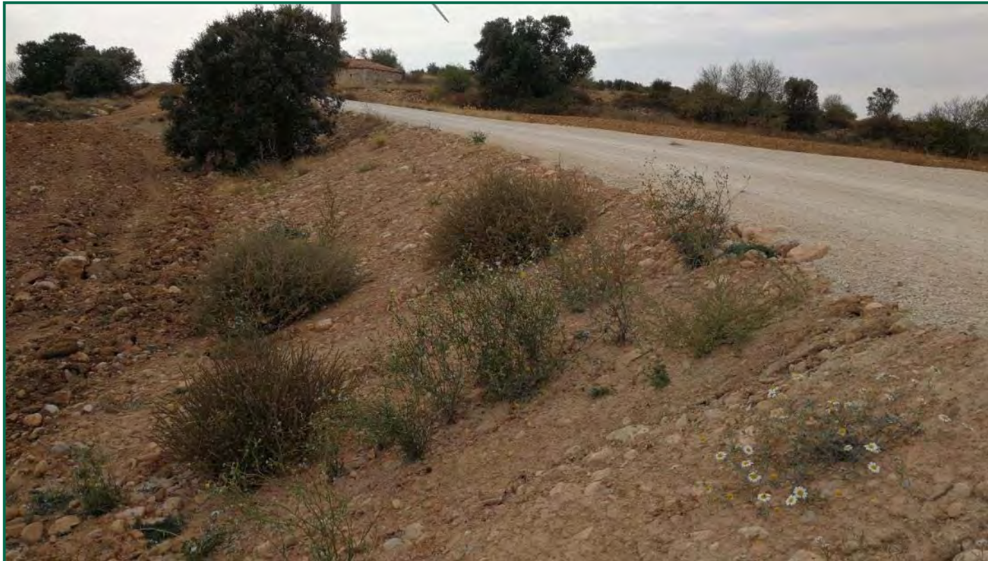
Fotografía 6. Estado de los taludes y vegetación.
