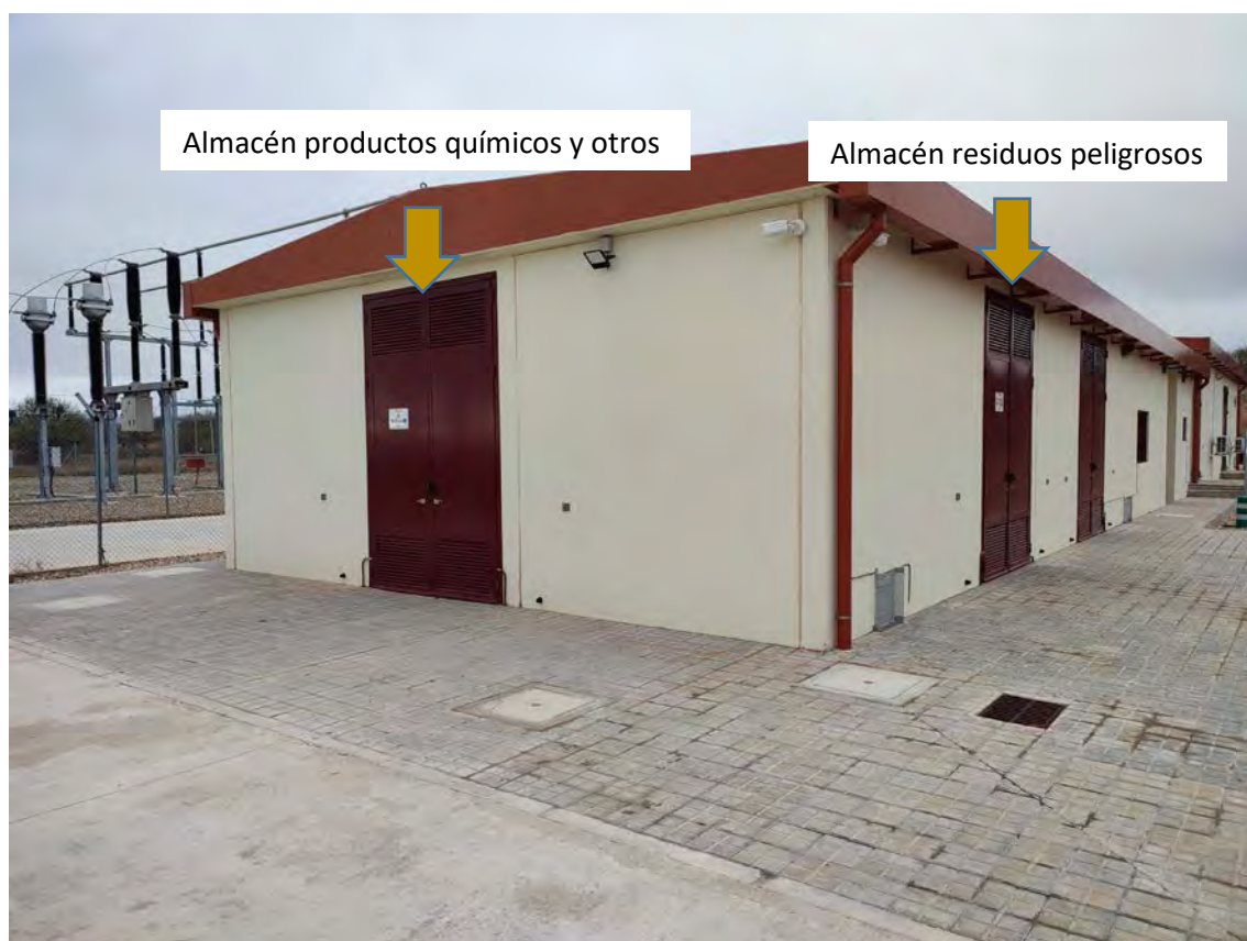
Imagen 16. Puertas de acceso rápido desde vehículo para la retirada de residuos por el gestor autorizado.
