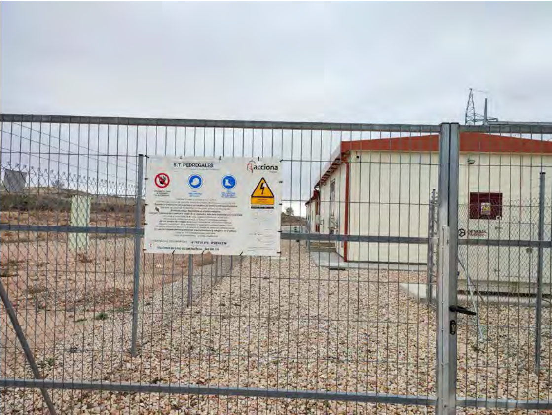
Imagen 1. Entrada subestación Pedregales.
