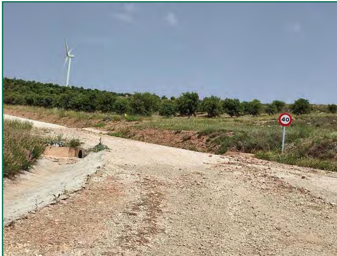
Fotografía 7. Estado pista de acceso a la SET.
