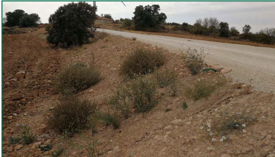
Fotografía 8. Estado de los taludes y vegetación.
