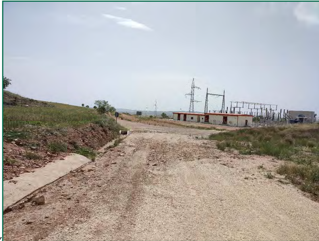
Fotografía 11. Pista a la SET.
