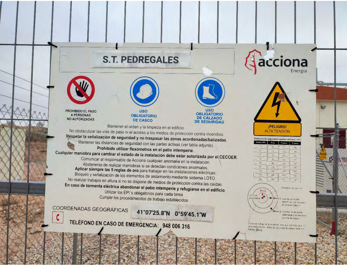
Imagen 2. Cartel de avisos de peligro, uso obligatorio EPIS, y emergencia
