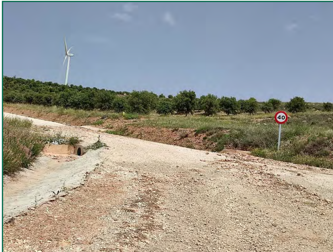
Fotografía 9. Estado pista de acceso a la SET.
