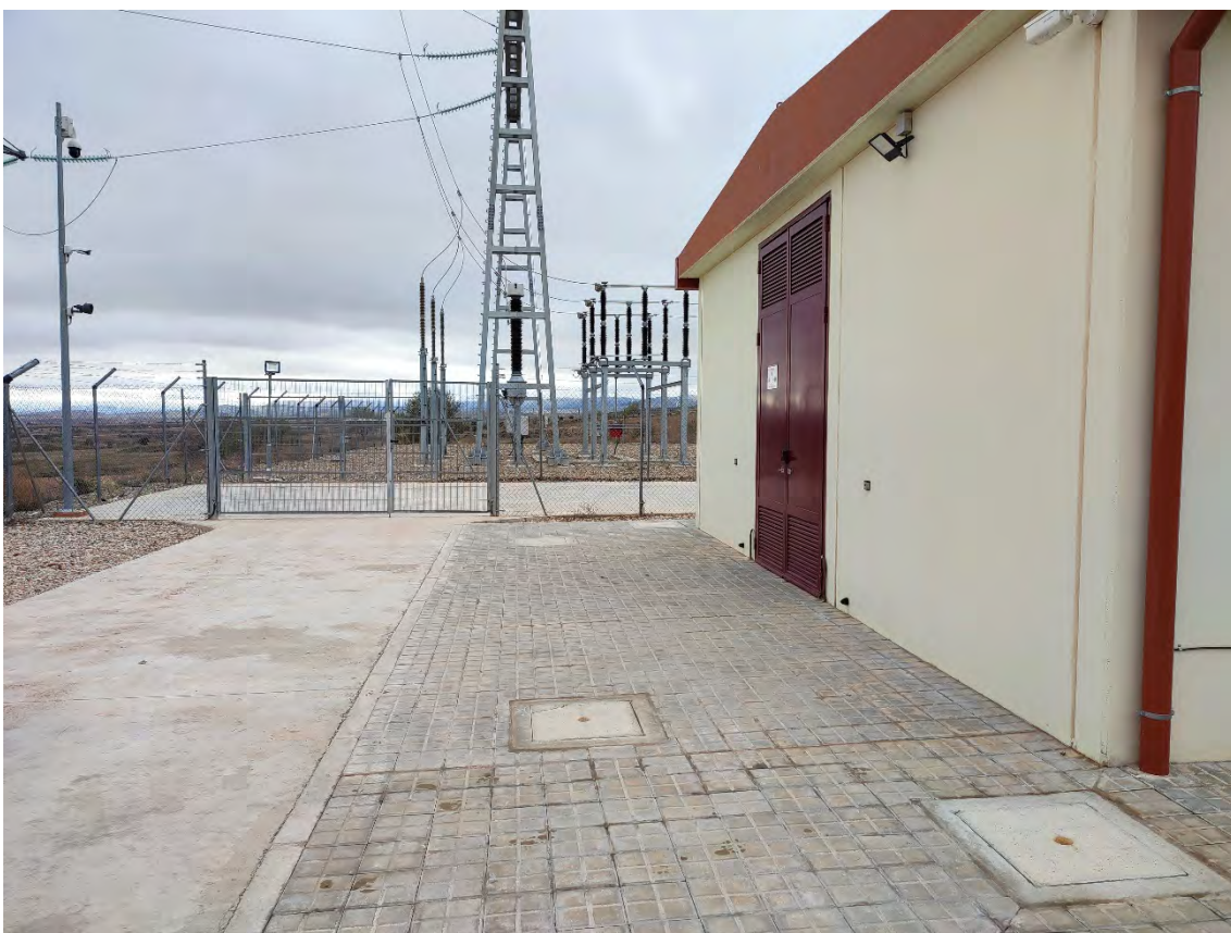
Imagen 15. Pista acceso a las puertas de los almacenes.
