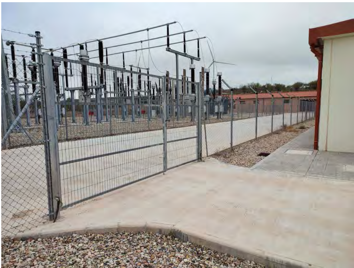
Imagen 14. Entrada de vehículos para el acceso a los almacenes.
