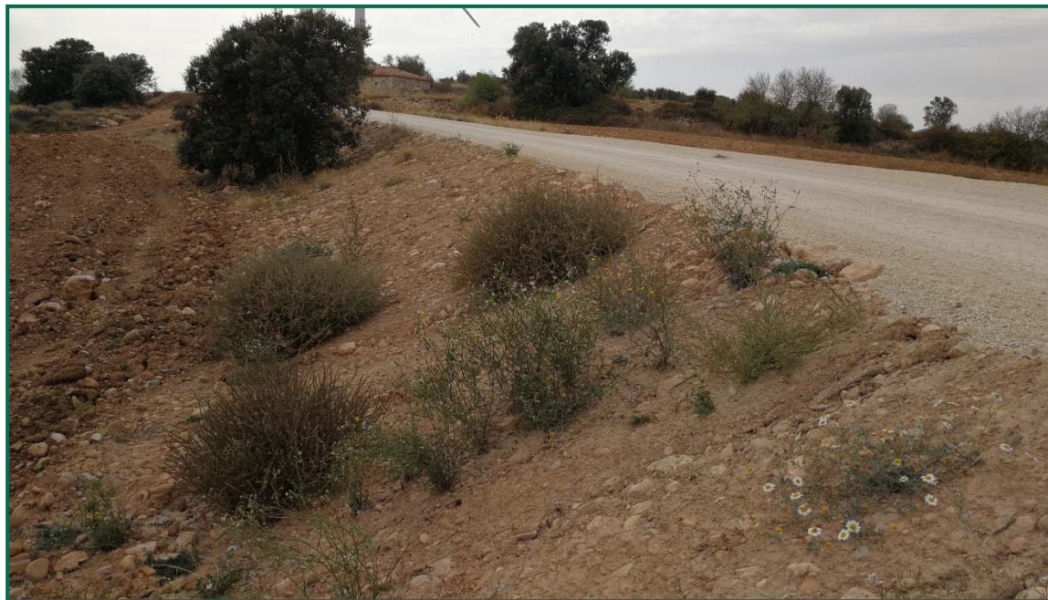
Fotografía 7. Estado de los taludes y vegetación.
