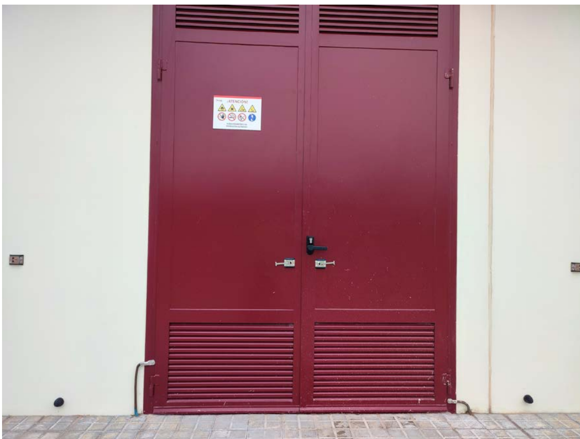
Imagen 4. Cartel de aviso de peligro por residuos contaminantes.
