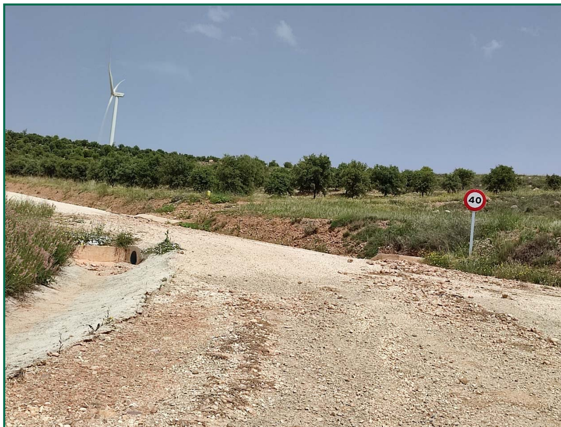
Fotografía 8. Estado pista de acceso a la SET.
