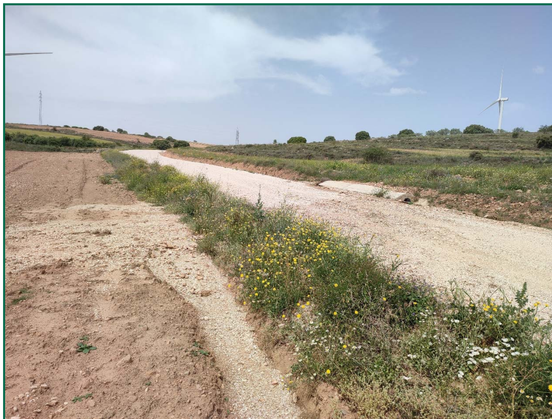
Fotografía 11. Estado pista de acceso a la SET.
