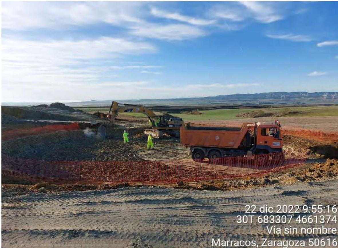
*Imagen 2. Maquinaria trabajando en la excavación de OBIII-1*
