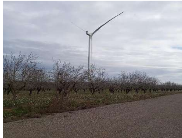
Fotografías 7 a 9: Estado de los caminos y viales
