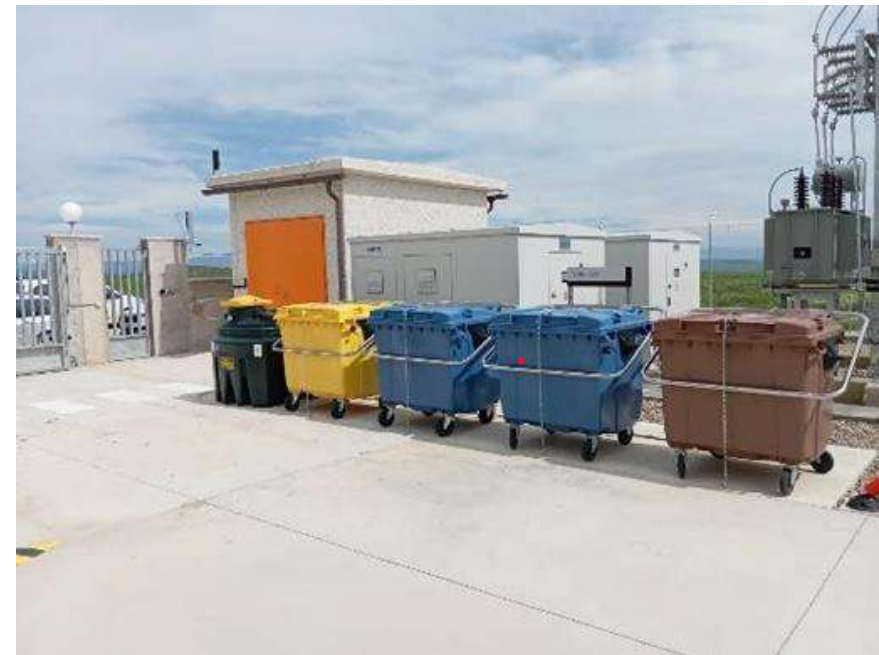
Fotografías 23 a 24: Almacenamiento de residuos
