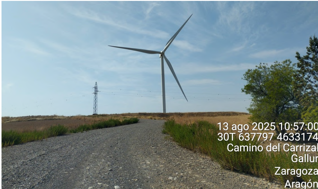
Figura 37: Vial de acceso de aerogenerador MU-09.
