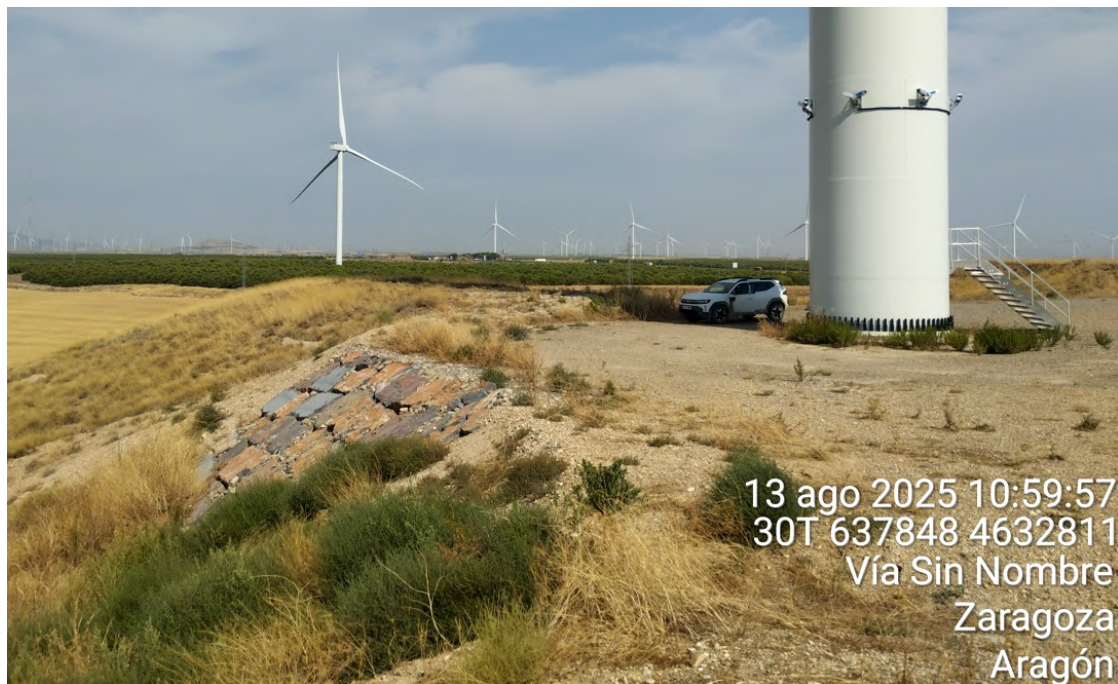
Figura 34: Fotografía del estado del talud restaurado al sur de la plataforma del aerogenerador MU-09 durante el presente cuatrimestre.
