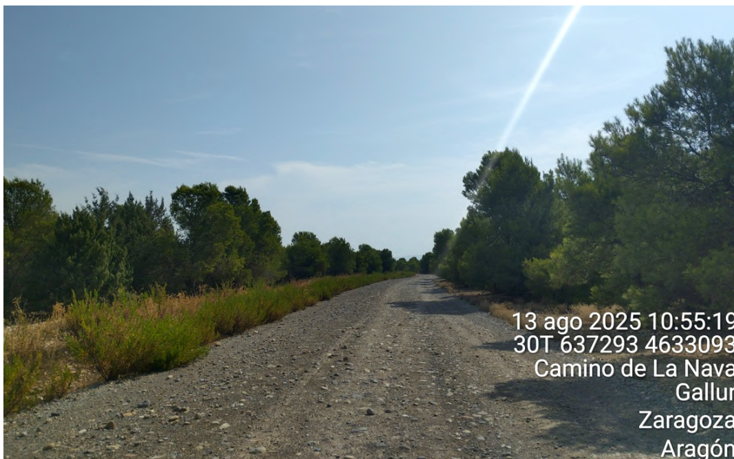
Figura 38: Vial de acceso a la altura de aerogenerador MU-08, cruzando pinar de repoblación.
