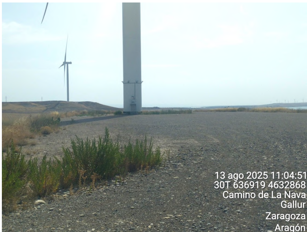
Figura 42: Plataforma de MU-07 localizada sobre una colina, en correcto estado de conservación.
