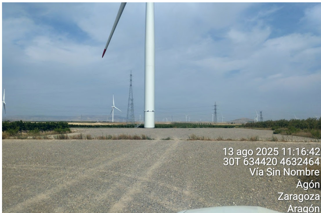
Figura 46: Plataforma del aerogenerador MA-01.
