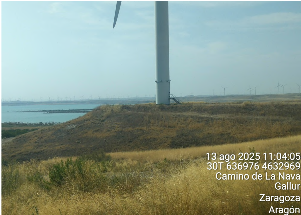
Figura 41: Talud de la colina de la plataforma de MU-07, en correcto estado de conservación y restauración.
