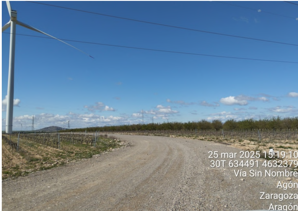
Figura 45: Vial de acceso al aerogenerador MA-01, anteriormente del PE “Multitecnología Extensión”, que en 2024 ha sido integrado dentro del PE “Multitecnología”.
