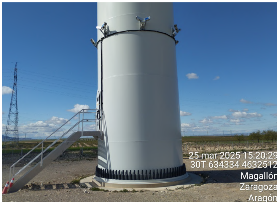
Figura 16: Fotografía de uno de los Sistemas “3D Observer”, concretamente el ubicado en el aerogenerador MA-01.
