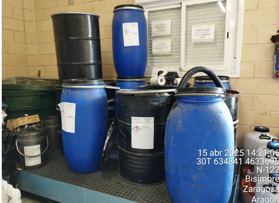
Figura 50: Interior del almacén de residuos de la SET “Valcardera”, con los recipientes de residuos peligrosos aislados de la intemperie y ubicados sobre una tarima aislante para evitar posibles filtraciones al suelo.
