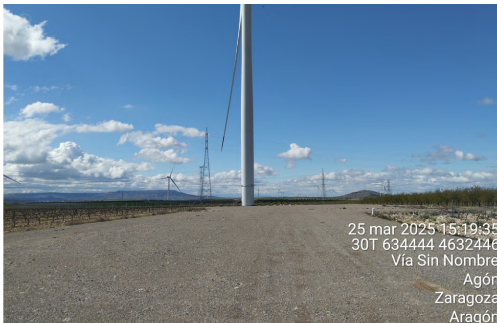
Figura 46: Plataforma del aerogenerador MA-01, anteriormente del PE “Multitecnología Extensión”, que en 2024 ha sido integrado dentro del PE “Multitecnología”.
