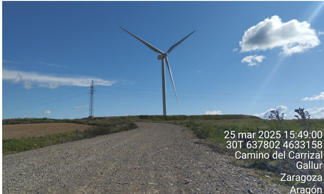
Figura 37: Vial de acceso de aerogenerador MU-09.
