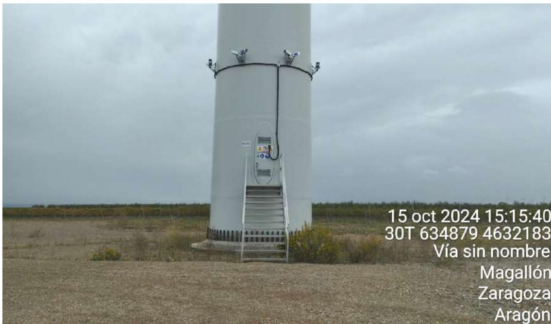
Figura 16: Fotografía de uno de los Sistemas “3D Observer”, concretamente el ubicado en el aerogenerador MU-1.
