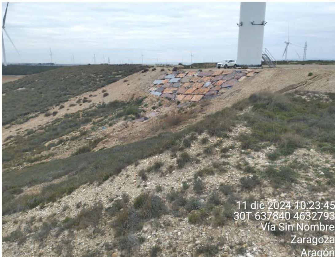
Figura 36: Fotografía del estado de la restauración del talud erosionado al sur de la plataforma del aerogenerador MU-09 durante el segundo cuatrimestre de 2024.
