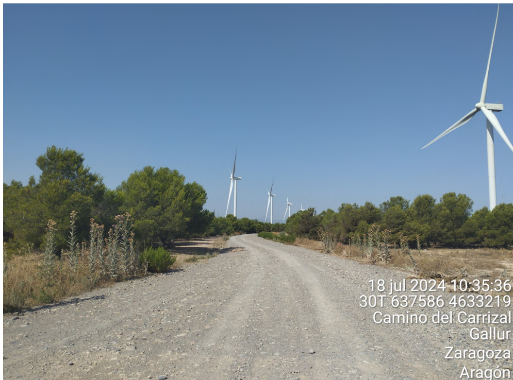
Figura 35: Vial de acceso a la altura de aerogenerador MU-08, cruzando pinar de repoblación.
