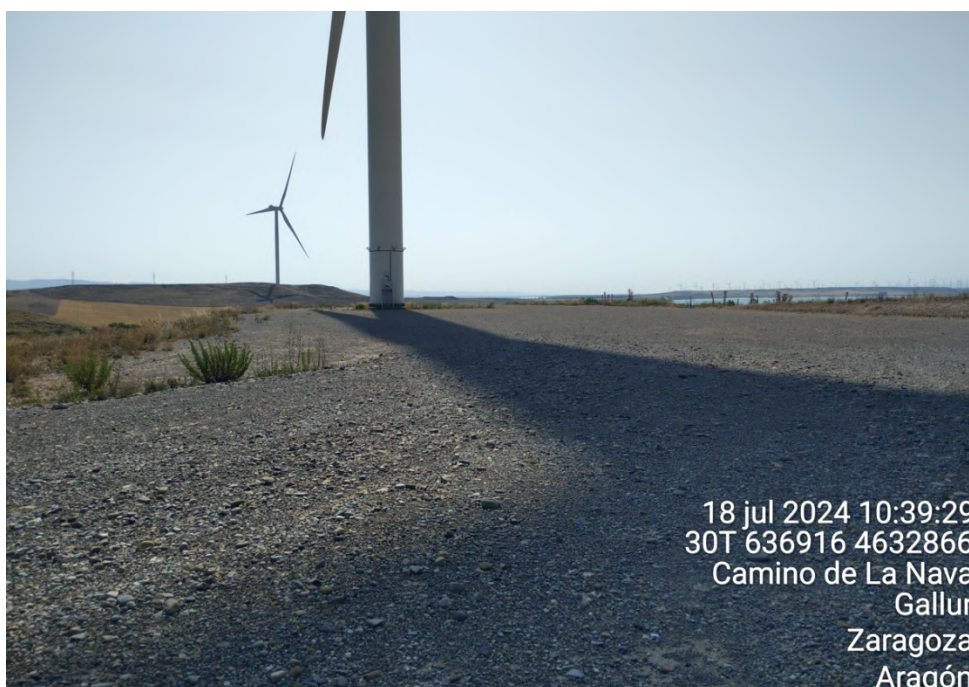
Figura 39: Plataforma de MU-07 localizada sobre una colina, en correcto estado de conservación.
