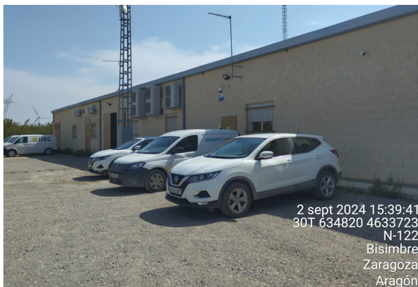
Figura 44: Subestación eléctrica Valcardera, SET asociada al parque eólico, en la que se realiza la gestión de residuos del PE, así como la ubicación del arcón refrigerador para la conservación de siniestros asociados al PE.
