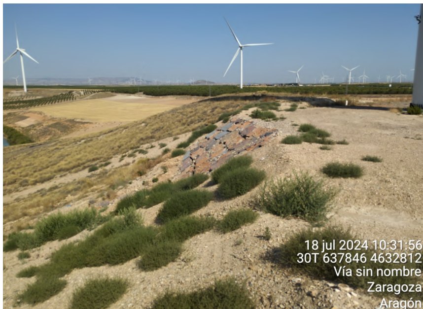
Figura 31: Fotografía del estado de la restauración del talud erosionado al sur de la plataforma del aerogenerador MU-09 durante el segundo cuatrimestre de 2024.
