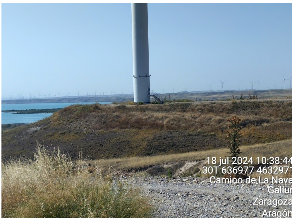
Figura 38: Talud de la colina de la plataforma de MU-07, en correcto estado de conservación y restauración.
