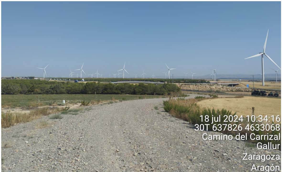
Figura 34: Vial de acceso de aerogenerador MU-09.
