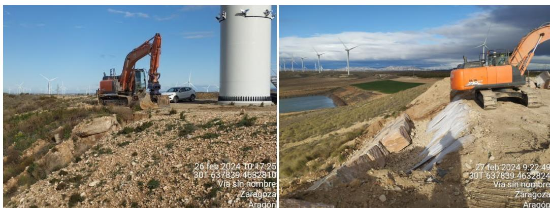
Figura 34: Labores de restauración del proceso erosivo en el aerogenerador MU-9 durante la última semana de febrero de 2024.
