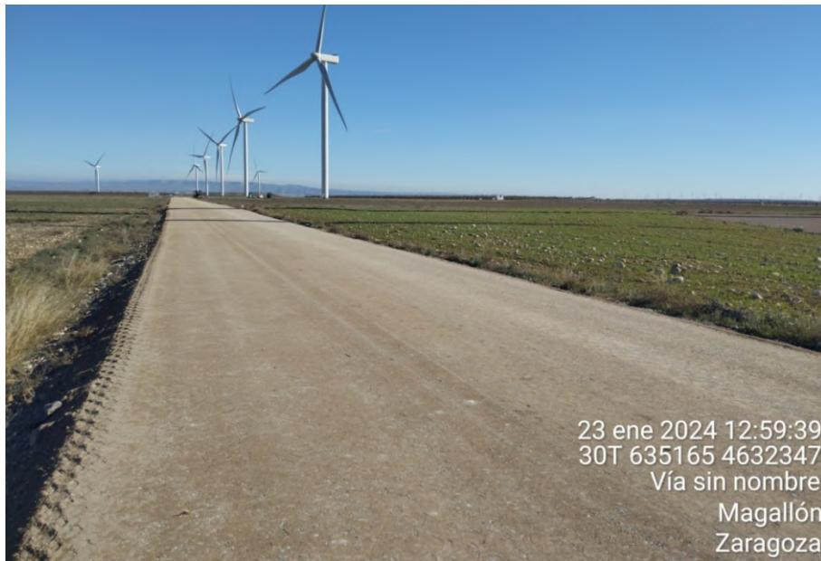
Figura 32: Fotografía del vial principal de PE Multitecnología justo después de ser restaurado, fotografía del 23 de enero de 2024.
