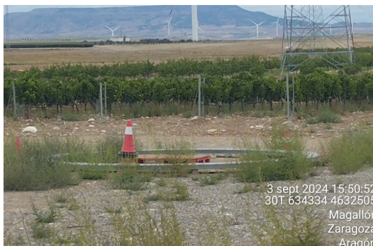
Piezas de construcción sobrantes aún almacenadas en la plataforma.
