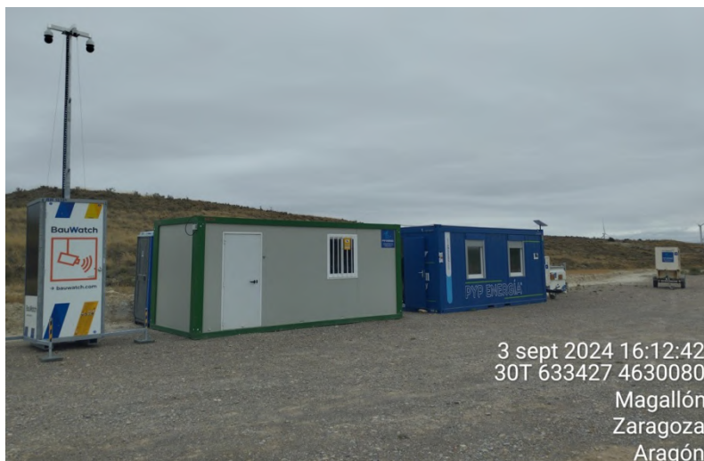
Site Camp a septiembre de 2024. Una serie de casetas de contratas, así como generadores, un baño portátil y una torre de cámaras de seguridad han sido instaladas.
