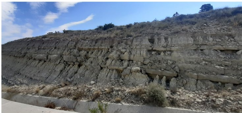
Erosión hídrica en materiales margosos del talud de desmonte del vial de acceso al aero ML5.04
