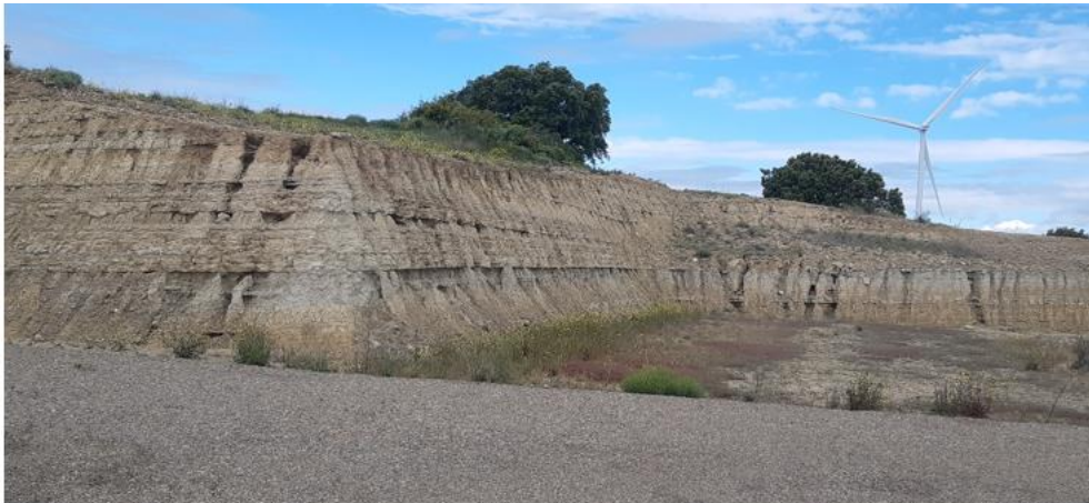
Erosión hídrica en materiales margosos del talud de desmonte de la plataforma del aero ML5.07
