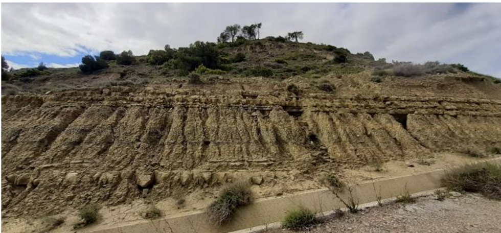
Erosión hídrica en materiales margo-lutíticos del talud de desmonte del vial de acceso al aero ML5.05
