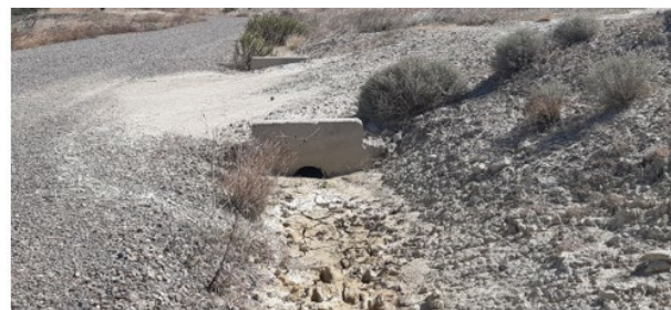
Tubo de drenaje obstruido con sedimentos en vial de acceso al aero ML4.07.
