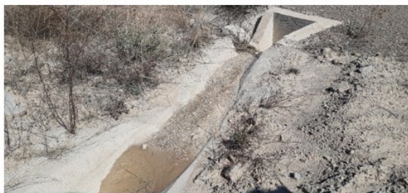
Cuneta llena de sedimentos en vial de acceso al aero ML4.03.
