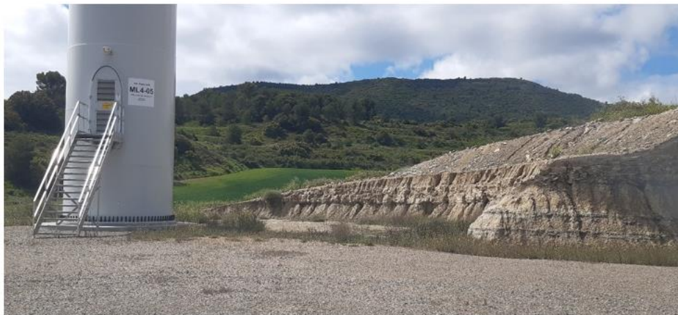
Erosión hídrica en materiales margo-lutíticos del talud de desmonte de plataforma del aere ML4.05
