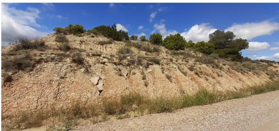
Erosión hídrica en materiales lutíticos y margosos del talud de desmonte del vial de acceso al PE ML4
