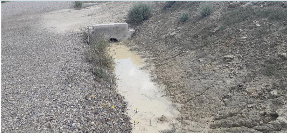
Tubo de drenaje encharcado y semitaponado con sedimentos en vial de acceso al aero ML4.07.
