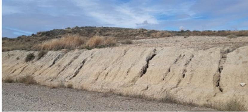
*Erosión hídrica en materiales margo-lutíticos del talud de desmonte del vial de acceso al PE ML3.*
