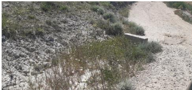
Tubo de drenaje taponado con vegetación arbustiva y sedimentos en vial de acceso al aereo ML3.03.
