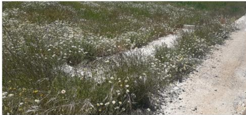
Tubo de drenaje taponado por vegetación arbustiva y sedimentos en vial de acceso al PE ML3.
