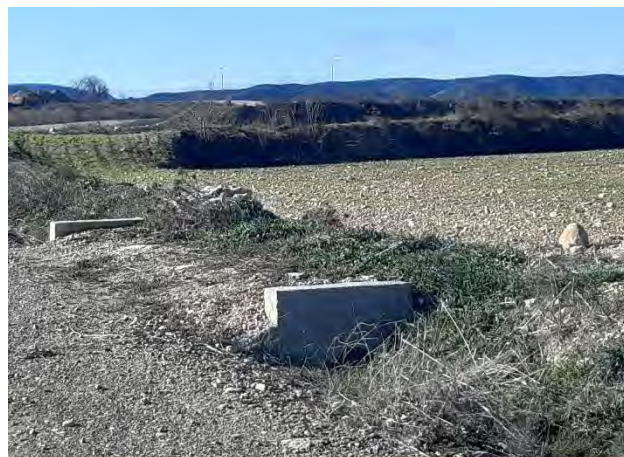
Fig. 2 Tubo de drenaje semitaponado con vegetación arbustiva y sedimentos en el vial de acceso a MLA1.15. Fuente: Elaboración propia
