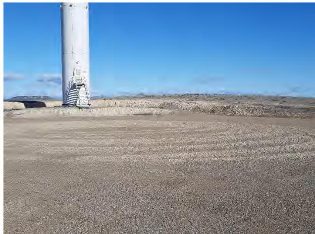
Fig. 2 Rodadas circulares procedentes de vehículo grande en la plataforma del aero MLA3.06. Fuente: Elaboración propia
