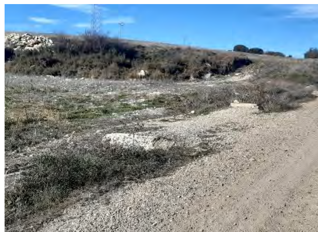
Fig. 6 Tubo de drenaje taponado por vegetación arbustiva en vial de acceso al aero LSA.10. Fuente: Elaboración propia
