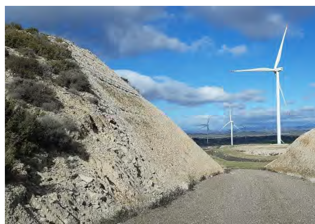
Fig. 4 Talud de desmonte del vial de acceso a MLA1.07. Se recomienda revegetar. Fuente: Elaboración propia
