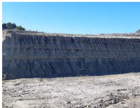
Fig. 6 Erosión hídrica en materiales margo-calizos en el talud de la plataforma de ML5.07. Formación de sistema de cárcavas. Fuente: Elaboración propia
