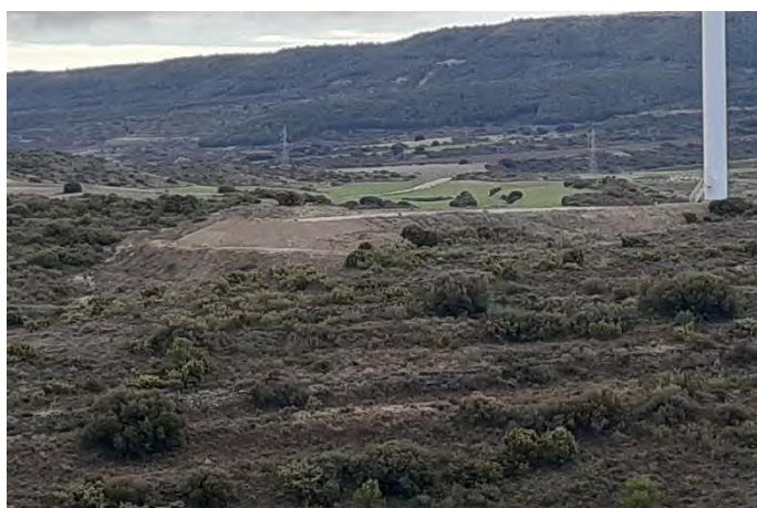
Fig. 3 Talud de desmonte de plataforma de LSA.03 sin revegetar. Fuente: Elaboración propia
