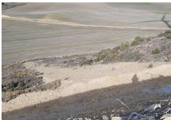
Fig. 5 Zanja media tensión MLA3.08 sin revegetar. Fuente: Elaboración propia
