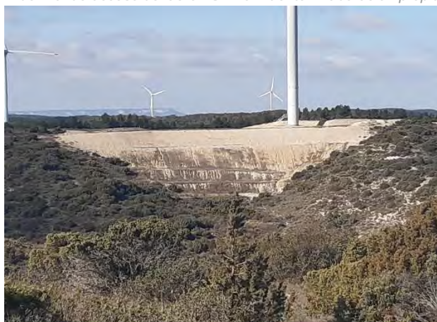
Fig. 3 Erosión hídrica en materiales margo-calizos del talud terraplén de plataforma del aero ML3.07. Fuente: Elaboración propia
