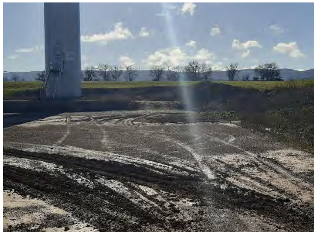
Fig. 1 Rodadas en la plataforma del aero MLA1.15 en material litítico-arenoso. Fuente: Elaboración propia
