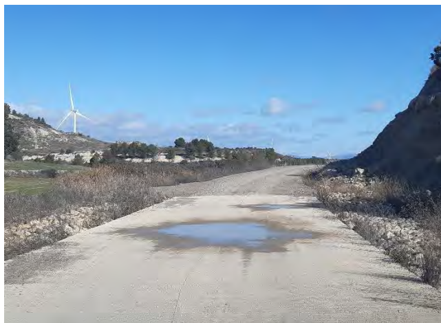
Fig. 1 Encharcamiento en vado en vial de acceso al aero ML4-05.
