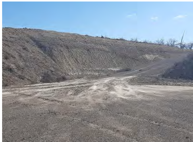
Fig. 2 Rodadas semiprofundas y baches en materiales margosos de
