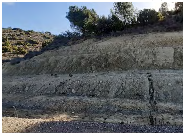
Fig. 5 Talud del vial de acceso al parque MLA4, con erosión hídrica afectando a materiales margo-lutíticos. Fuente: Elaboración propia
