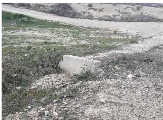
Fig. 3 Tubo de drenaje taponado por vegetación arbustiva y sedimentos en vial de acceso al aero ML3.14. Fuente: Elaboración propia
