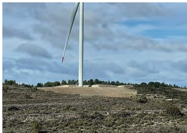
Fig. 2 Talud de desmonte en la plataforma de MLA3.07 sin revegetar. Fuente: Elaboración propia
