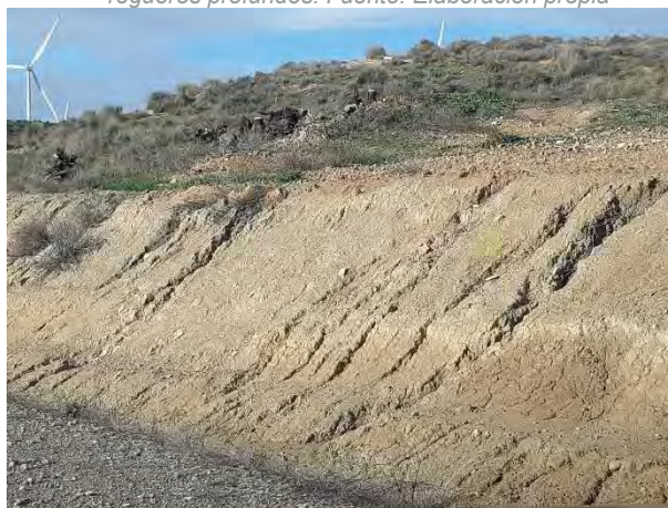
Fig. 3 Talud del vial ppal. de MLA3, frente a la entrada del yacimiento Sierra de Luna, con evidencias de erosión hídrica. Fuente: Elaboración propia
