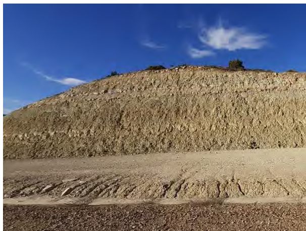
Fig. 1 Erosión hídrica en materiales margosos del talud de desmonte del vial de acceso del aero LSA.10. Fuente: Elaboración propia
