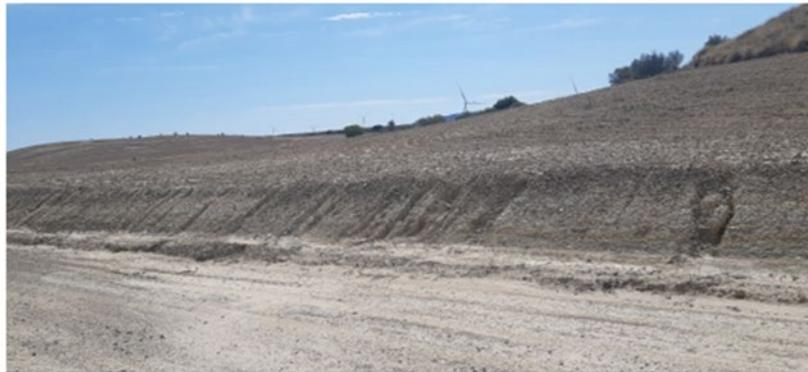
*Erosión hídrica en materiales margo-lutíticos del talud de desmonte del vial de acceso al aere ML2.05*
