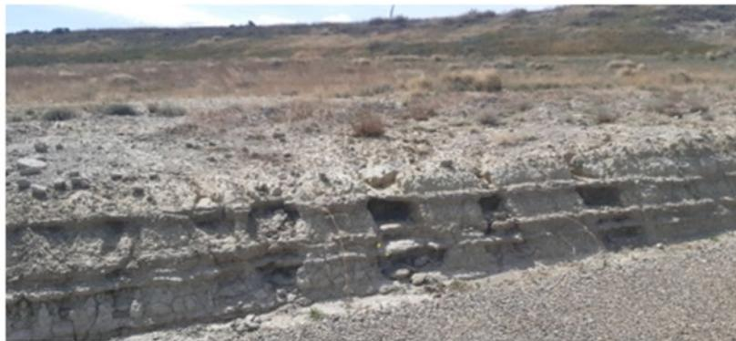
*Erosión hídrica en materiales margosos del talud de desmonte del vial de acceso al aere ML2.09*
