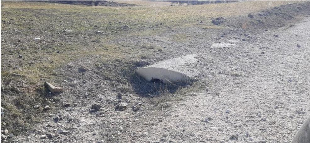
Fig 1. Tubo de drenaje semitaponado con sedimentos en vial de acceso al aero MO2-04
