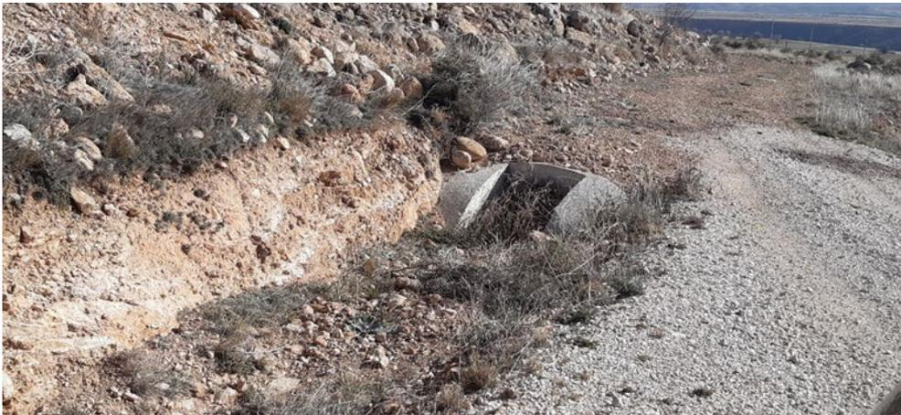
Fig. 2: Tubo de drenaje semitaponado con vegetación arbustiva en vial de acceso al aero MO2.06.
