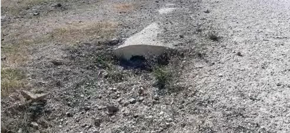
*Fig 1. Tubo de drenaje semitaponado con sedimentos en vial de acceso al aereo MO2-04*
