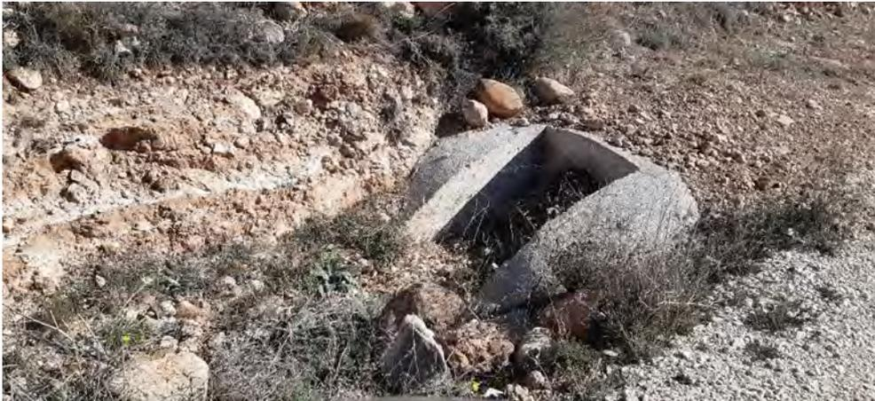
*Fig. 2: Tubo de drenaje semitaponado con vegetación arbustiva en vial de acceso al aereo MO2.06.*
