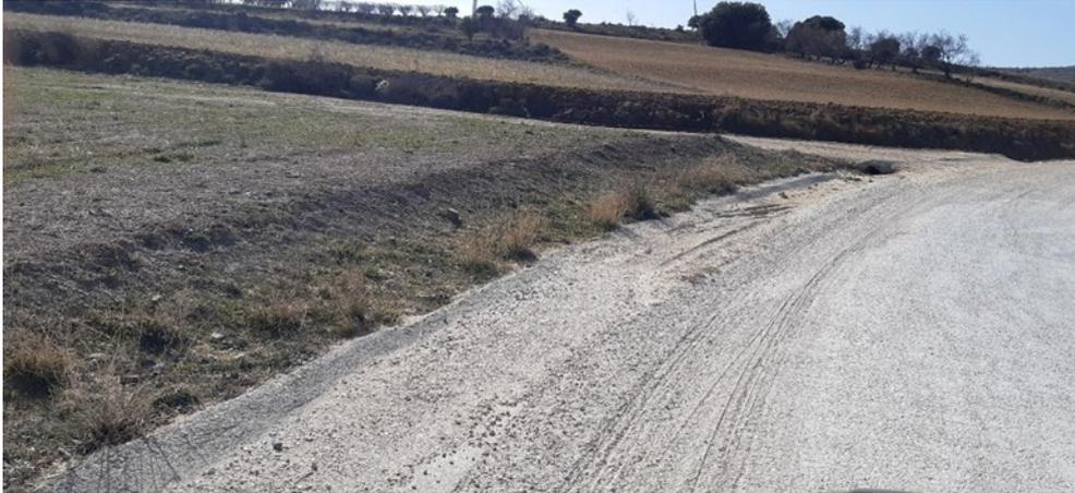
*Fig. 1: Cuneta llena de sedimentos en vial de acceso al PE MO1.*
