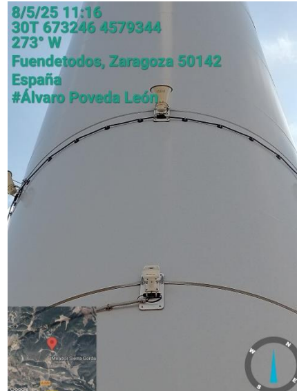
Fotografías 9 y 10: Señalización de los aerogeneradores y sistema DT Bird.
