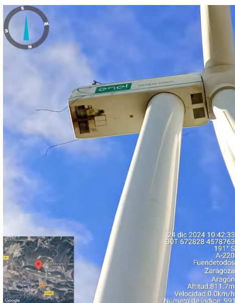
Fotografías 7 y 8. Barquillas sin derrames de aceite.
