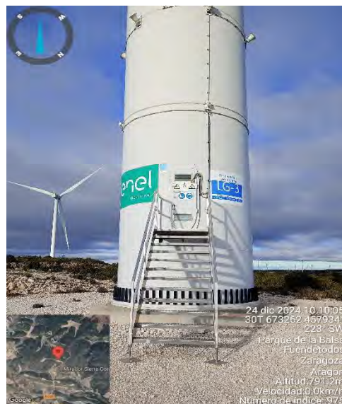
Fotografías 9 y 10: Señalización de los aerogeneradores y sistema DT Bird.
