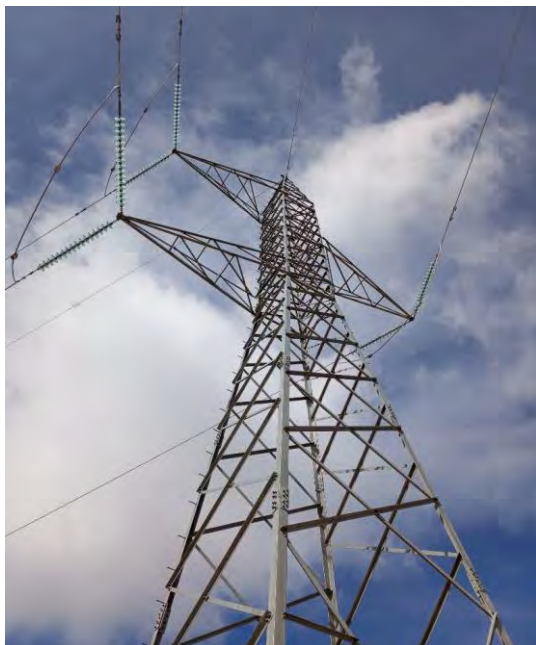
Fotografía 15 y 16. Elementos aislantes.
