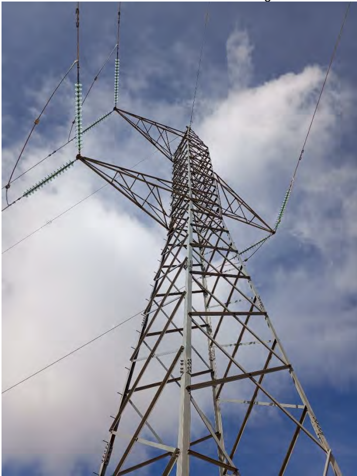
Fotografía 17 y 18. Elementos aislantes.
