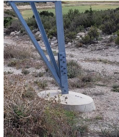
Fotografías 27 y 28: Señalización bases apoyos de la línea de alta tensión
