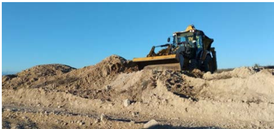
Reperfilando caballones de tierra vegetal.
