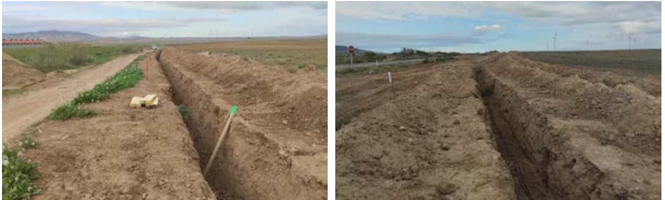
Ejecución de la zanja de conexión PE - SET Virgen de la Peña.
