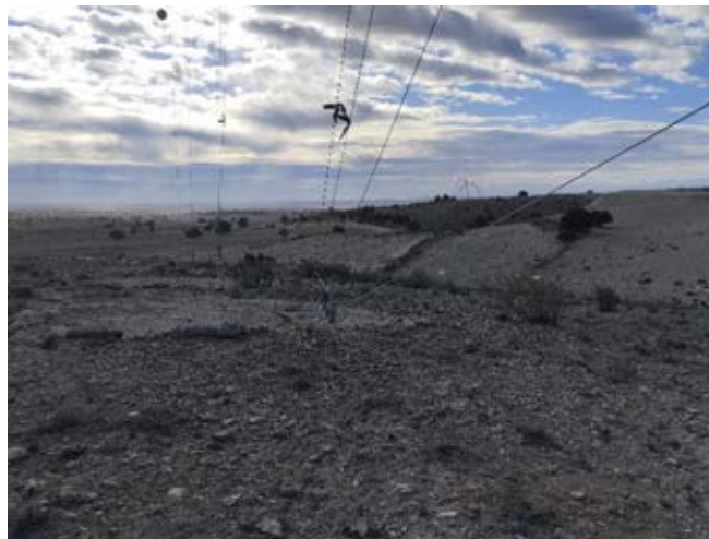
Torre meteorológica provisional y detalle de dispositivos salvapájaros
