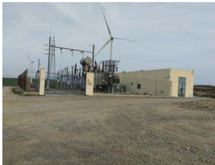
Situación a 19-02-25 (FIN DE OBRAS)
