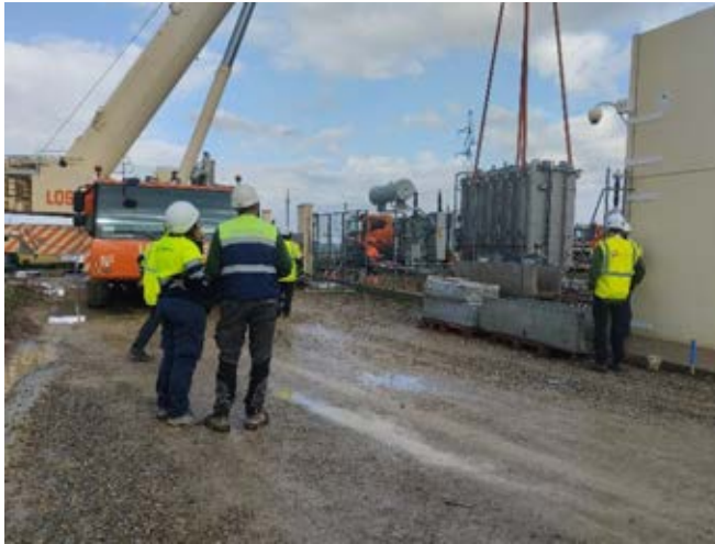
Colocación del nuevo transformador y tendido de cables en el sector de la zanja de conexión con la SET
