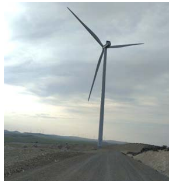
Situación a 19-02-25 (FIN DE OBRAS)
