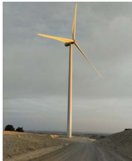
Situación a 19-02-25 (FIN DE OBRAS)
