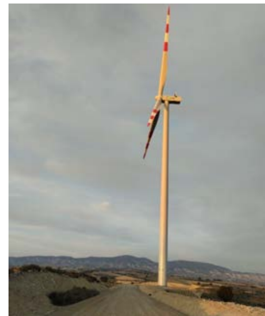
Situación a 19-02-25 (FIN DE OBRAS))
