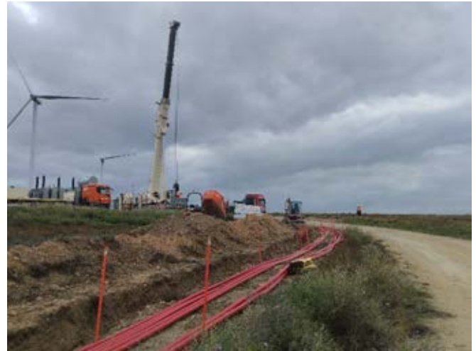
Colocación del nuevo transformador y tendido de cables en el sector de la zanja de conexión con la SET
