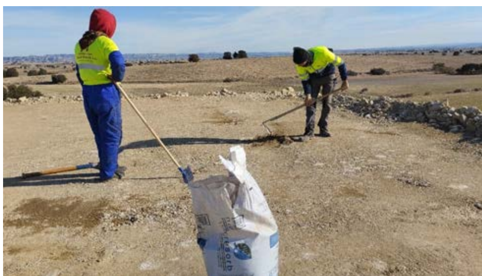
Limpiando un pequeño derrame de aceite.
