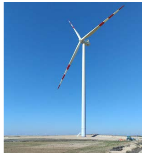
Situación a 19-02-25 (FIN DE OBRAS)
