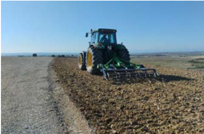
Descompactación, labrado y siembra de plataformas auxiliares
