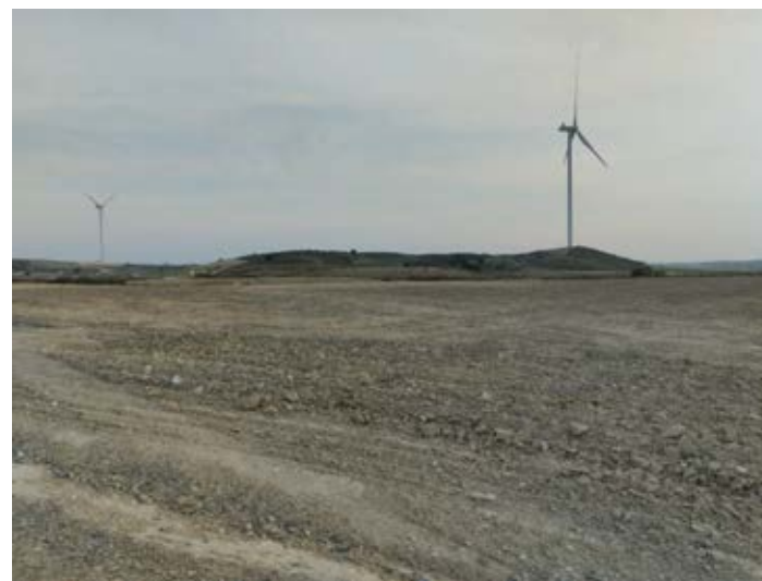
Situación a 19-02-25 (FIN DE OBRAS))
