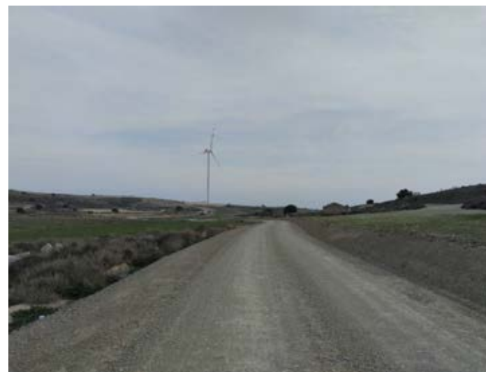
Situación a 19-02-25 (FIN DE OBRAS))
