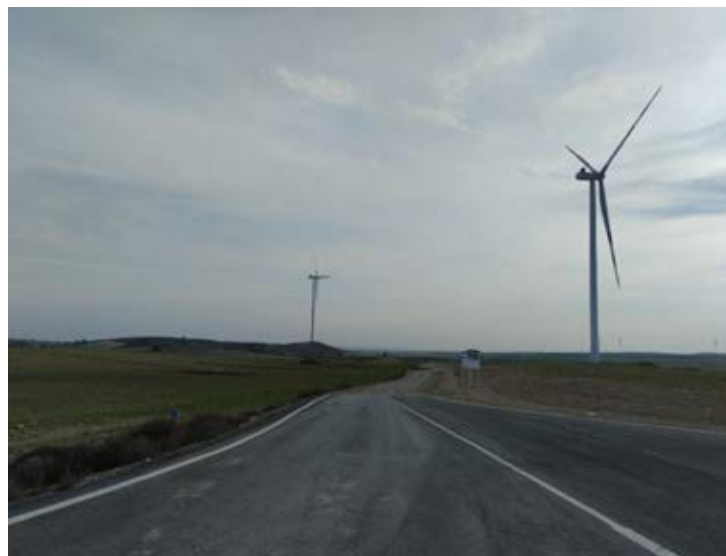
Situación a 19-02-25 (FIN DE OBRAS)
