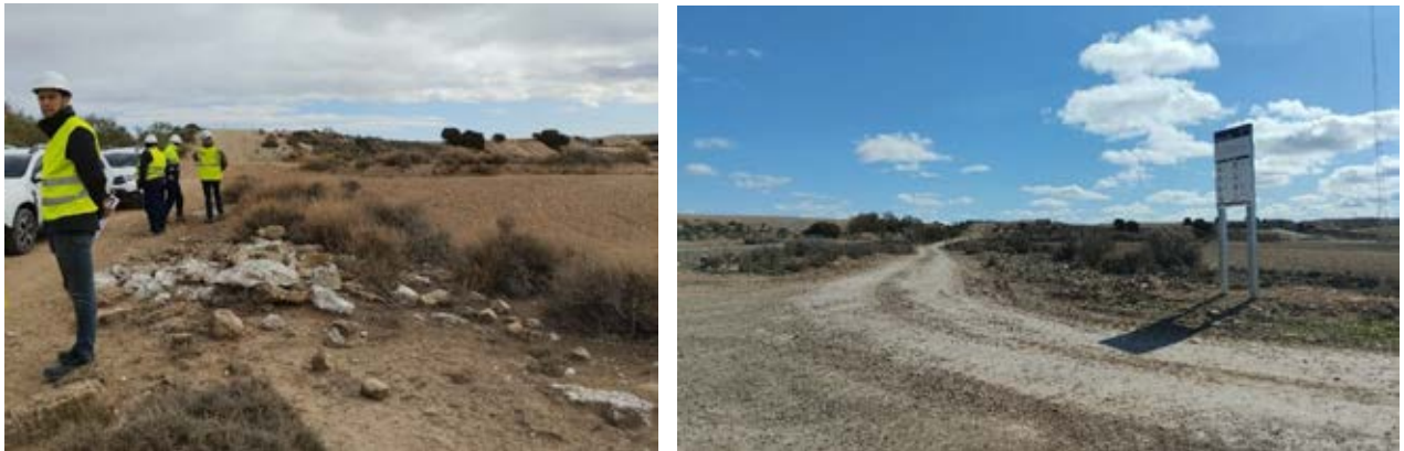
Tramo de la Cañada Real de Perdiguera a Monegrillo coincidente con el acceso a la Torre Meteorológica permanente, antes del inicio de las obras -izda.- y a finales de febrero de 2024 -dcha.-.
