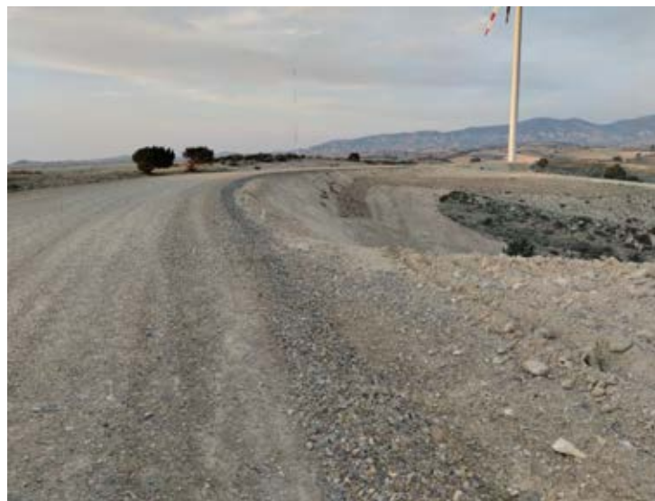
Situación a 19-02-25 (FIN DE OBRAS)
