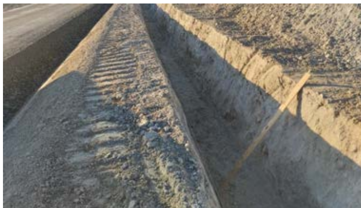
Colocación de tablas en zanjas
