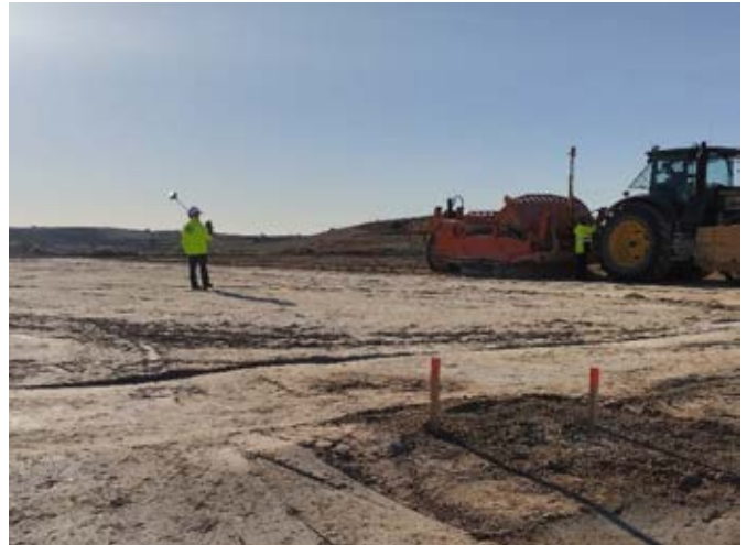
Inicio de los movimientos de tierras en el vial de acceso al PE, y montaje de la campa de obras
