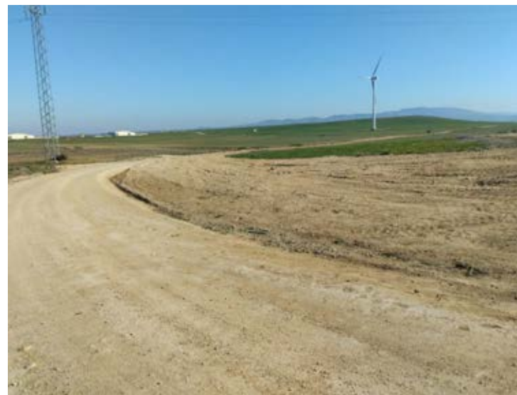
Situación a 19-02-25 (FIN DE OBRAS))
