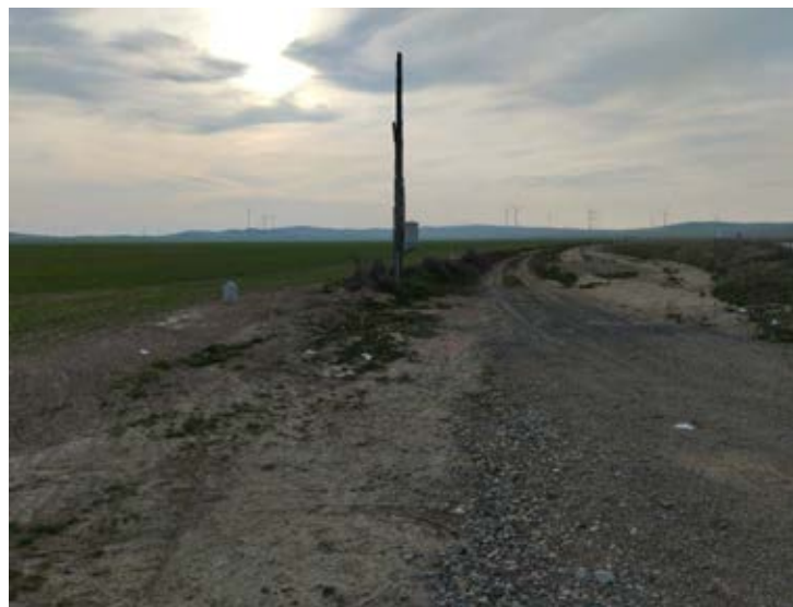
Situación a 19-02-25 (FIN DE OBRAS))
