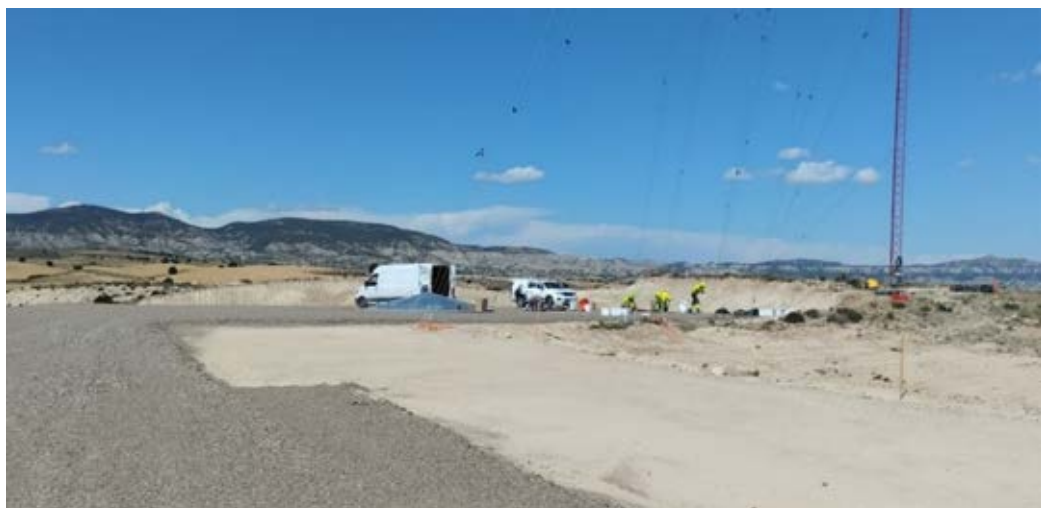
Tareas de desmontaje de la TM provisional, junto a la plataforma del SAR 02, el 03-06-24
