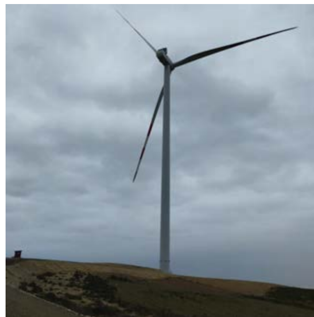
Situación a 19-02-25 (FIN DE OBRAS)
