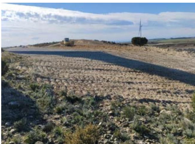
Inicio de los trabajos de restauración morfológica en la plataforma auxiliar del SAR 02.
