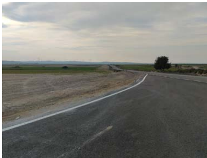
Situación a 19-02-25 (FIN DE OBRAS))
