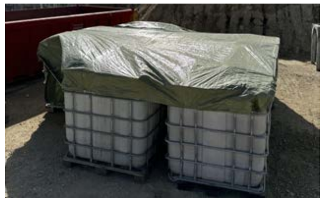
Lugar donde sucedió el derrame, y GRG con las zahoras contaminadas a la espera de su retirada por el gestor
