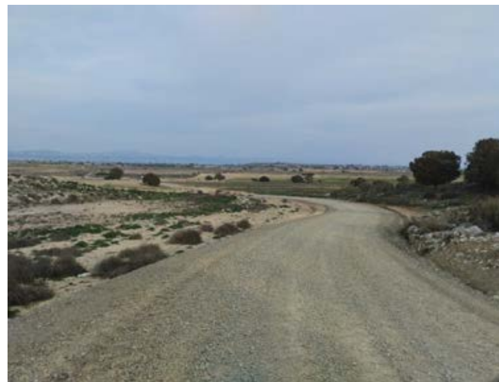
Situación a 19-02-25 (FIN DE OBRAS))
