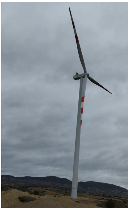
Situación a 31 de enero de 2025 tras el decimoquinto mes de obras
