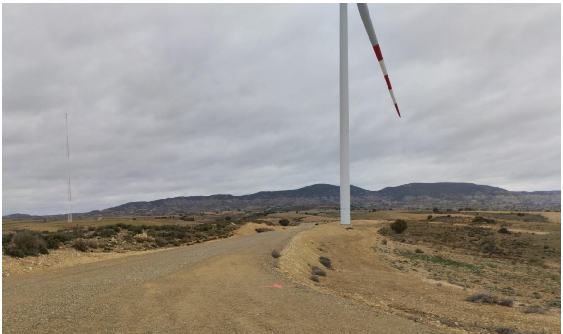
Situación a 31 de enero de 2025 tras el decimoquinto mes de obras
