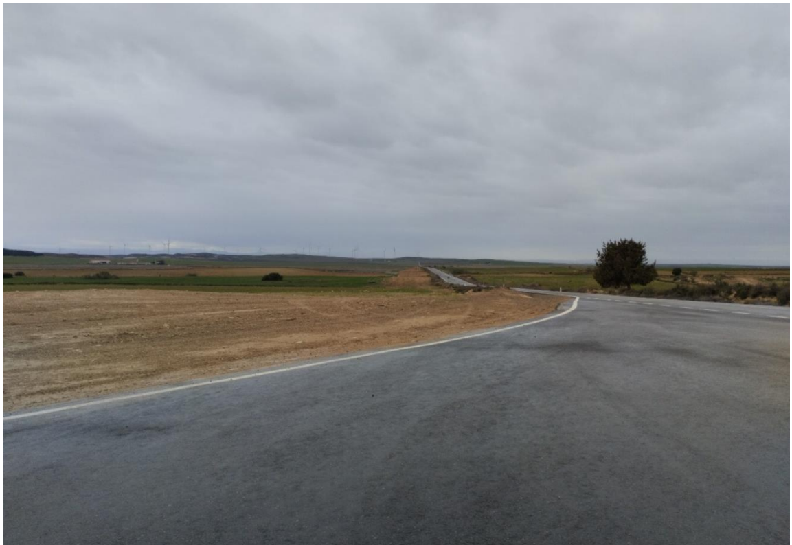
Situación a 31 de enero de 2025 tras el decimoquinto mes de obras
