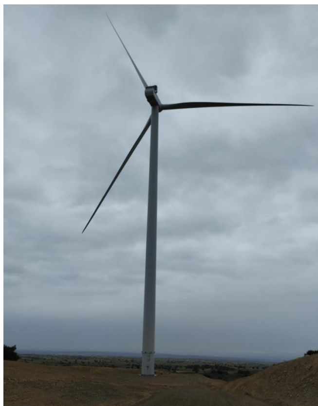
Situación a 31 de enero de 2025 tras el decimoquinto mes de obras
