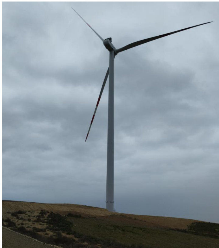
Situación a 31 de enero de 2025 tras el decimoquinto mes de obras
