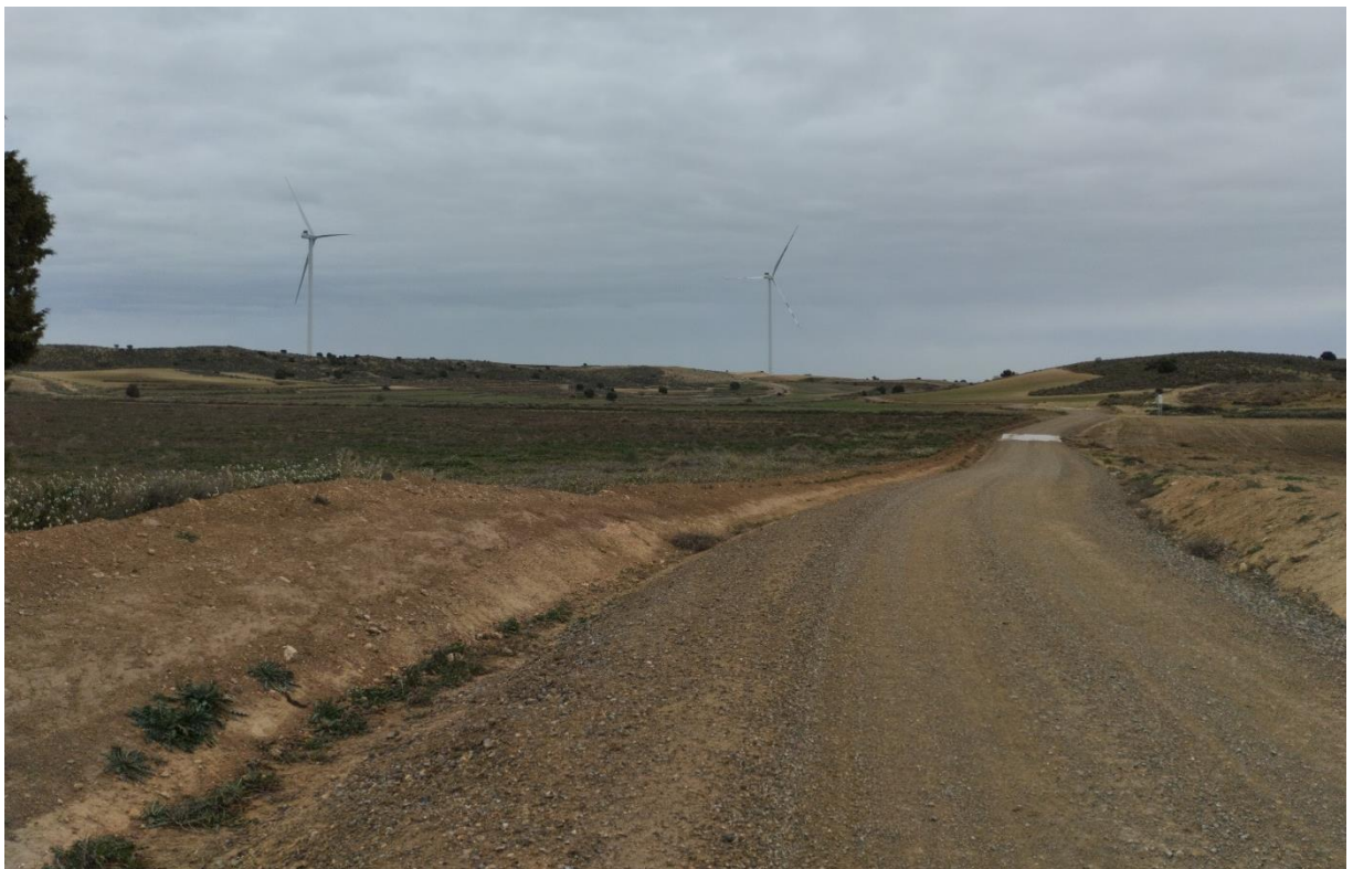
Situación a 31 de enero de 2025 tras el decimoquinto mes de obras
