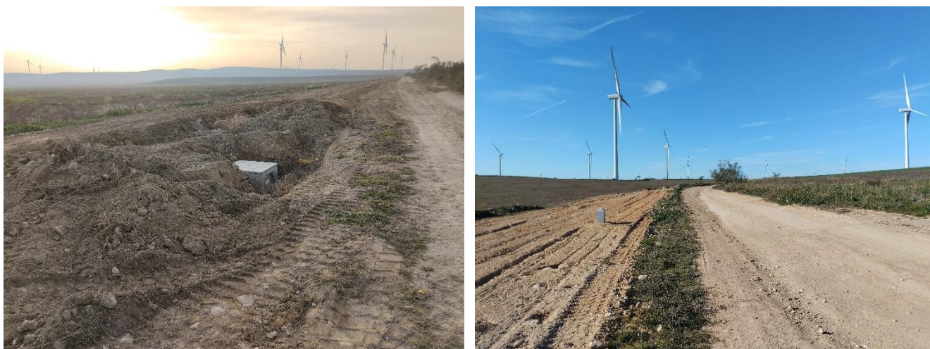
Últimos puntos pendientes de la zanja, antes y después de su restauración final
