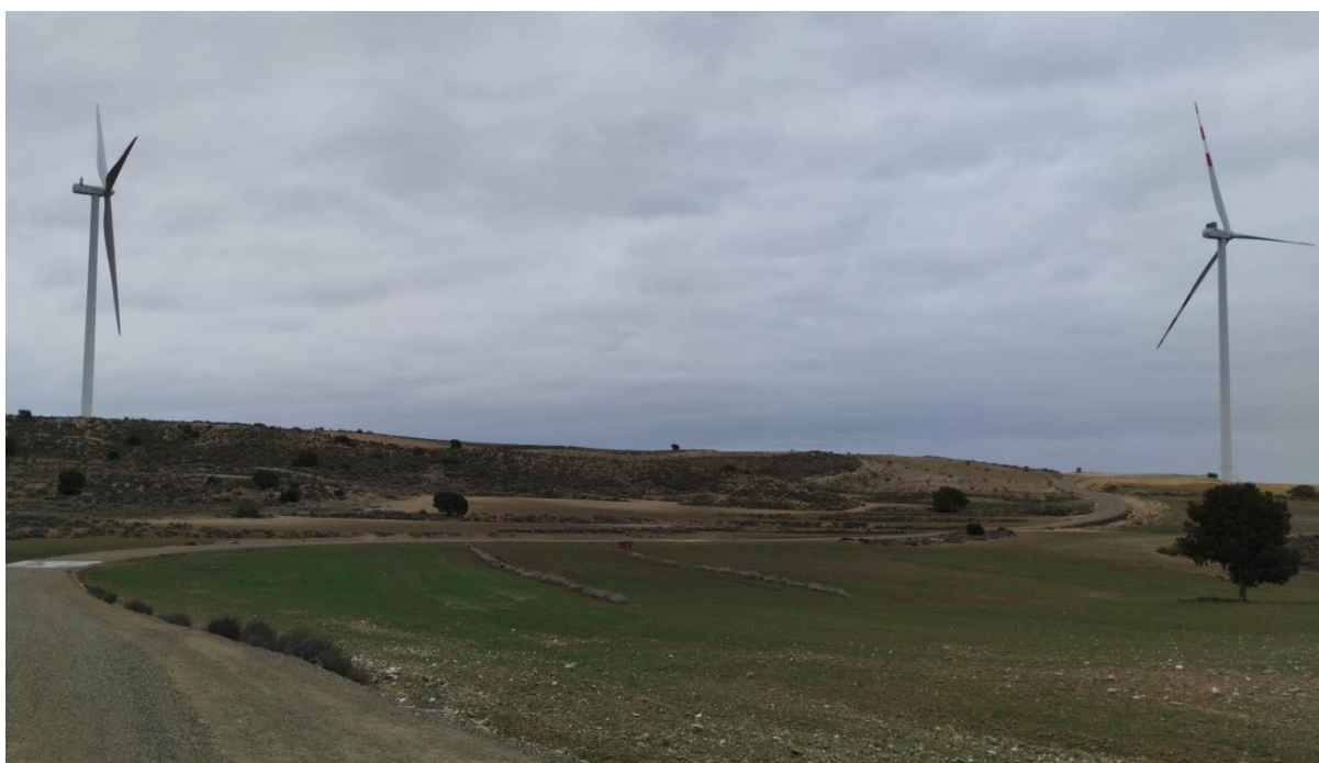
Situación a 31 de enero de 2025 tras el decimoquinto mes de obras
