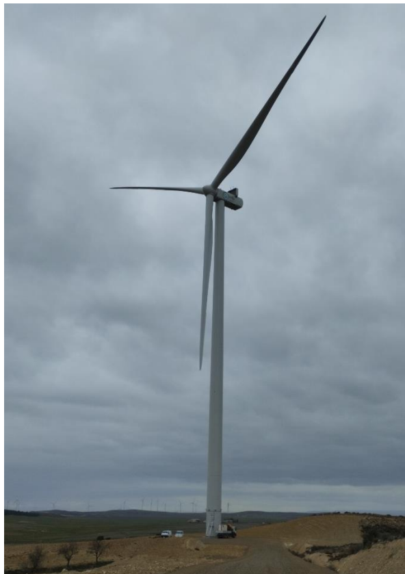
Situación a 31 de enero de 2025 tras el decimoquinto mes de obras
