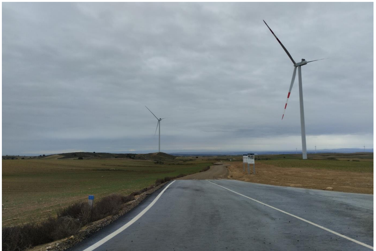
Situación a 31 de enero de 2025 tras el decimoquinto mes de obras
