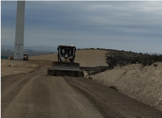
Reextendido de zahorras en viales a la izq, y zanja de conexión PE-SET, pendiente de restaurar a la dcha.
