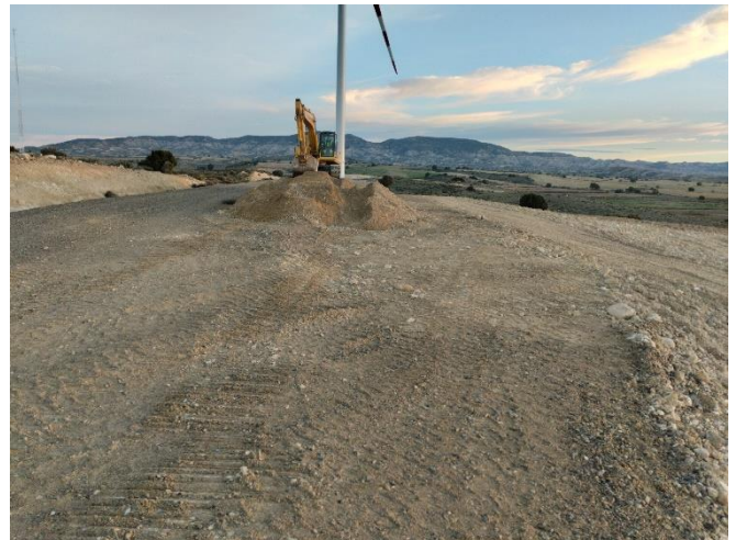
Izda., ejecutando un pequeño badén. Dcha., preparando acopio de zahorra para su extendido por los viales
