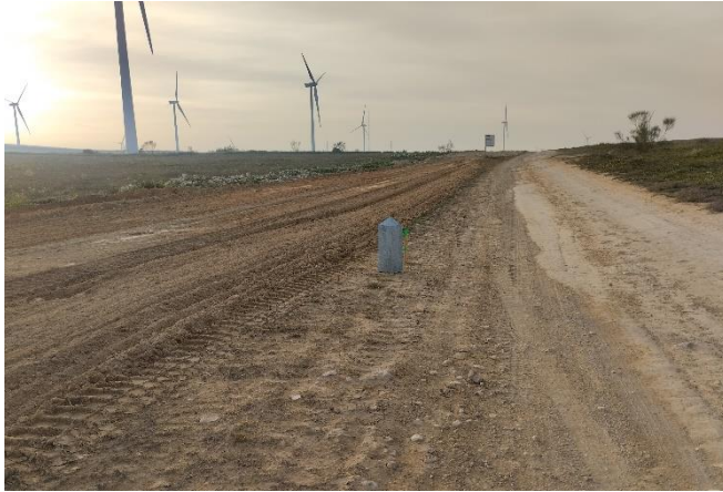
Zanja restaurada y balizada; excepto en los puntos de empalme.
