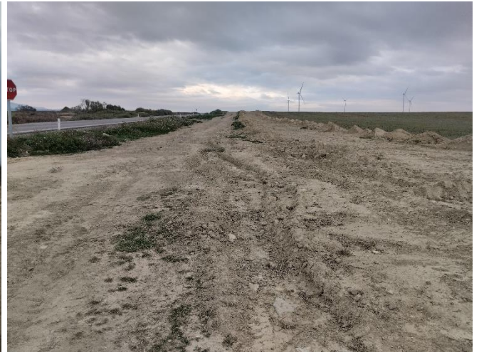
Reextendido de zahorras en viales a la izq, y zanja de conexión PE-SET, pendiente de restaurar a la dcha.
