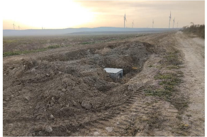
Zanja restaurada y balizada; excepto en los puntos de empalme.
