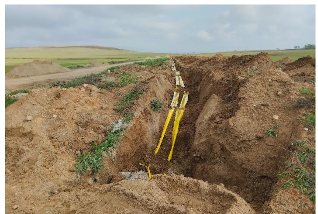
Sector central de la zanja, pendiente sólo de la restauración final; y tramo más cercano a la SET, donde se tienden cables
