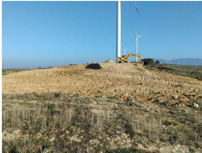
Izda., plataforma auxiliar del SAR 04, en fase de desmantelamiento; dcha., restauración morfológica de la plataforma auxiliar del SAR 05.
