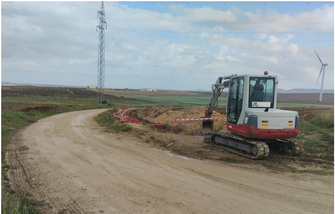
Situación a 31 de octubre de 2024 tras el duodécimo mes de obras
