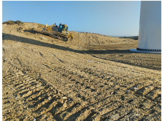
Izda., plataforma auxiliar del SAR 04, en fase de desmantelamiento; dcha., restauración morfológica de la plataforma auxiliar del SAR 05.
