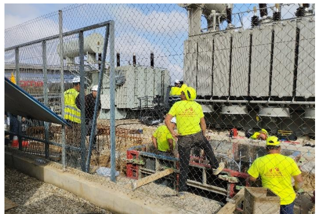
Retirando aceite del trafo viejo y trabajando en la instalación del nuevo
