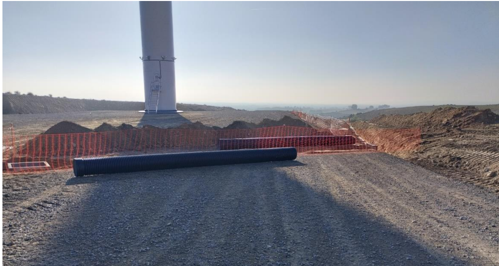
Colocación de una ODT en el extremo norte de la plataforma del SAR 03
