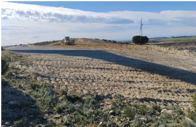
Inicio de los trabajos de restauración morfológica en la plataforma auxiliar del SAR 02.
