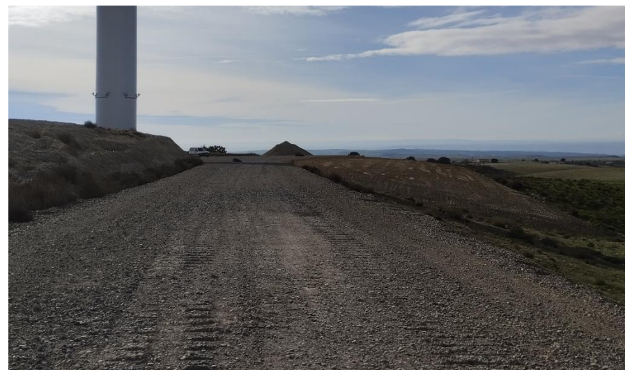
Evolución de las plataformas auxiliares ejecutada para colocar temporalmente las palas de los aerogeneradores: arriba, SAR 03; abajo, SAR 04
