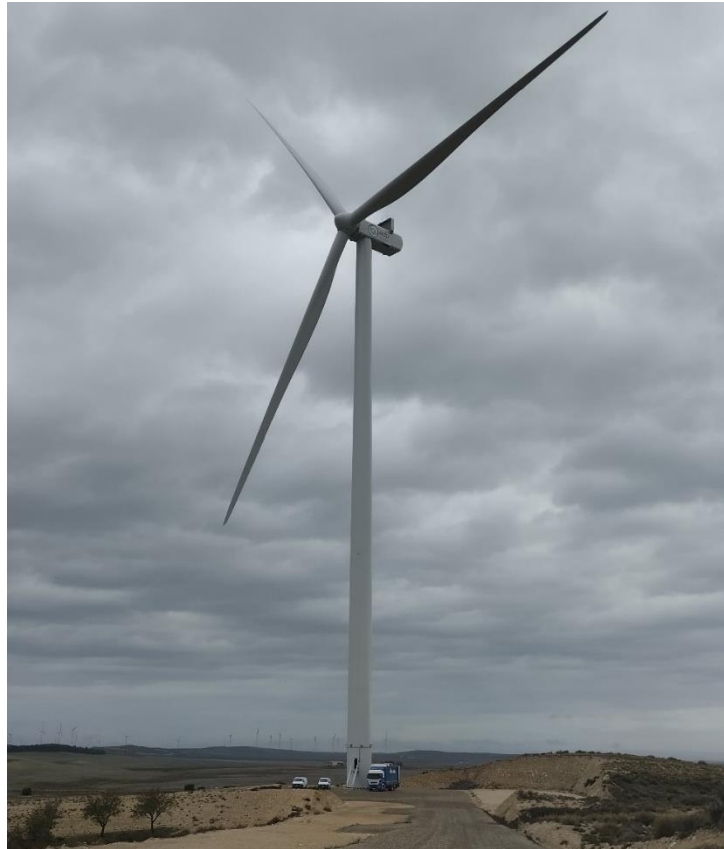
Situación a 31 de octubre de 2024 tras el duodécimo mes de obras
