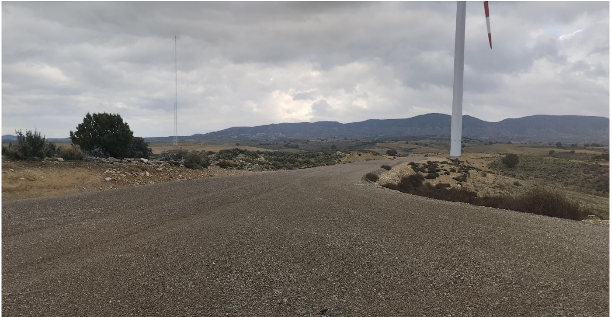
Situación a 31 de octubre de 2024 tras el duodécimo mes de obras
