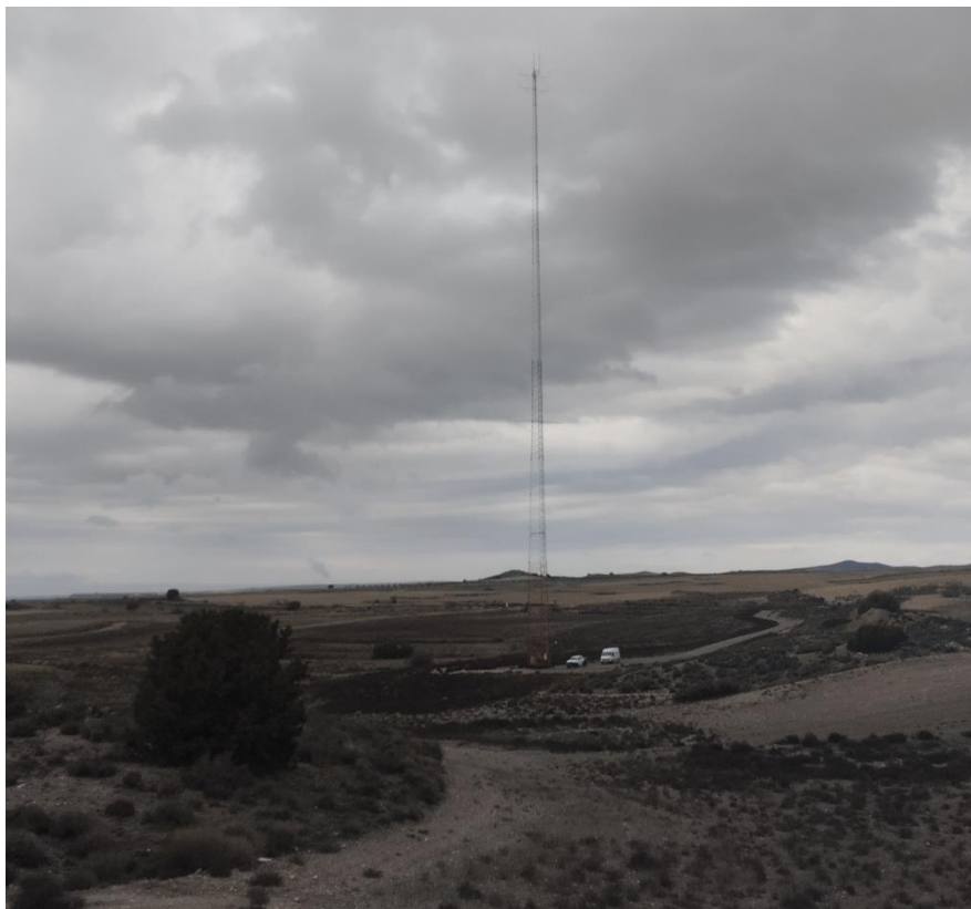
Situación a 31 de octubre de 2024 tras el duodécimo mes de obras
