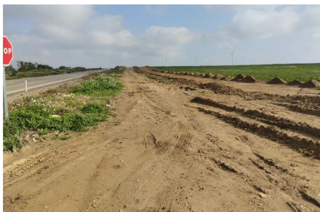
Sector central de la zanja, pendiente sólo de la restauración final; y tramo más cercano a la SET, donde se tienden cables
