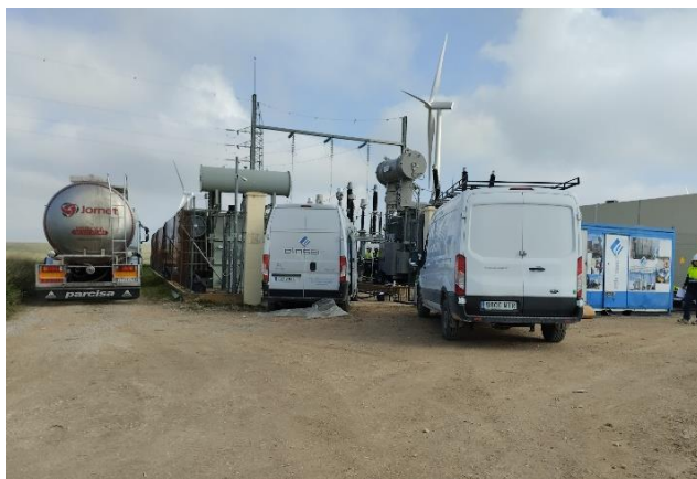
Retirando aceite del trafo viejo y trabajando en la instalación del nuevo
