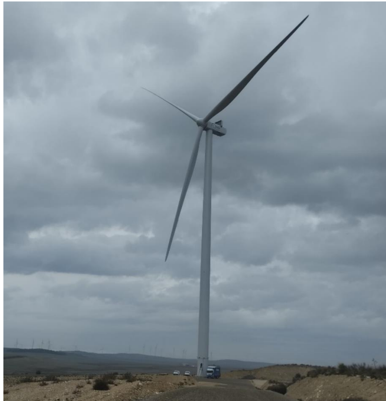
Situación a 31 de octubre de 2024 tras el duodécimo mes de obras
