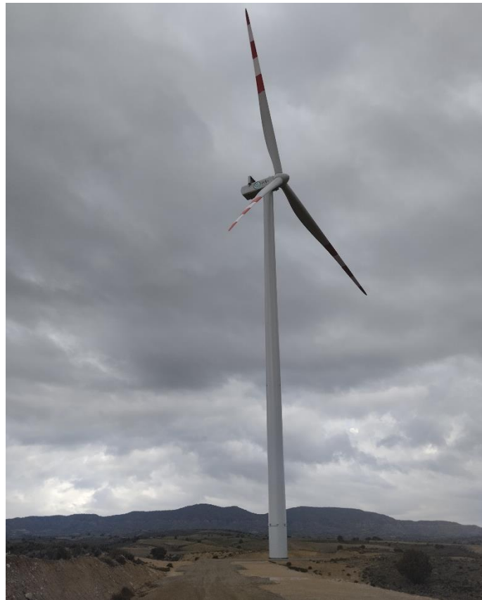
Situación a 31 de octubre de 2024 tras el duodécimo mes de obras
