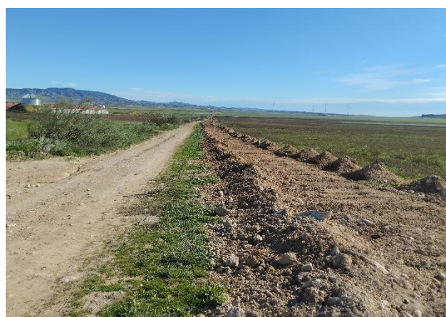
Estado de la zanja en su sector central -izda.- y final -dcha.- a falta ya sólo de la restauración.
