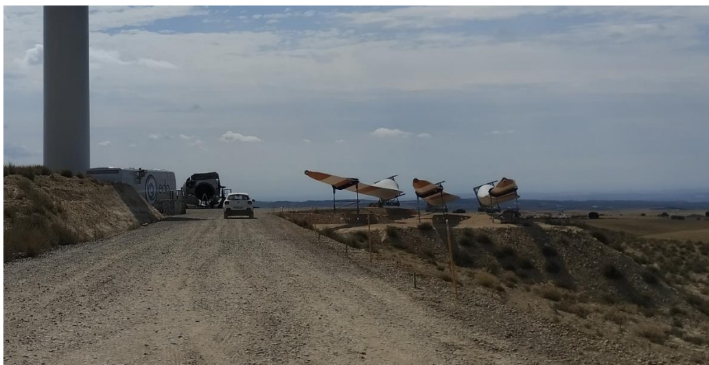
Evolución de las plataformas auxiliares ejecutada para colocar temporalmente las palas de los aerogeneradores: arriba, SAR 03; abajo, SAR 04
