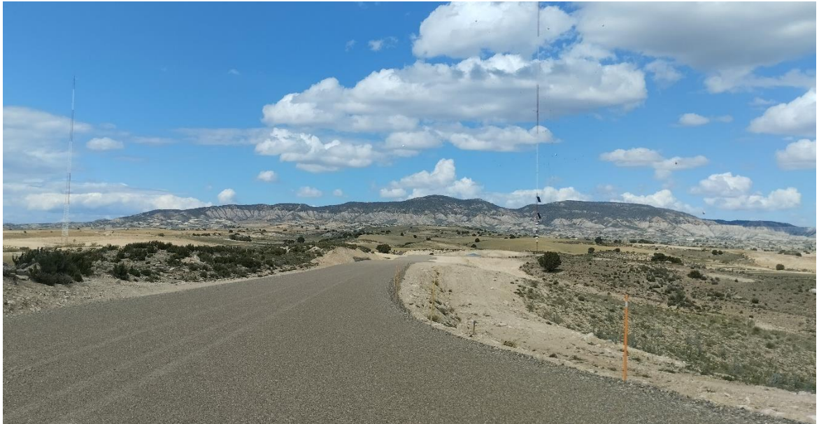
Situación a 21 de mayo de 2024 tras el séptimo mes de obras
