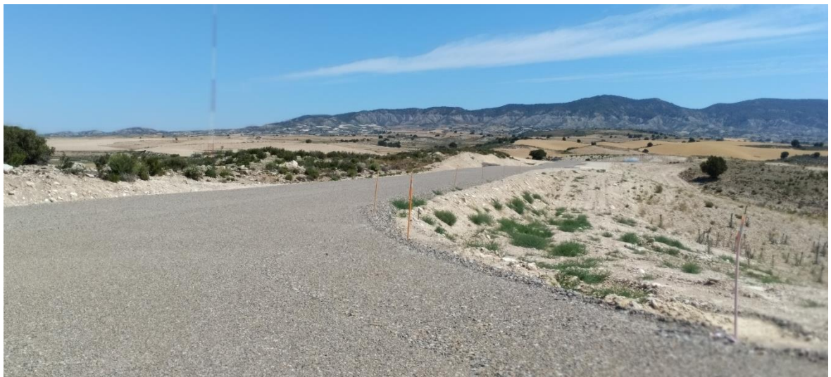
Situación a 25 de junio de 2024 tras el octavo mes de obras
