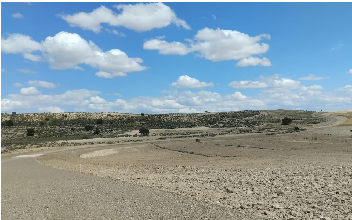
Situación a 21 de mayo de 2024 tras el séptimo mes de obras
