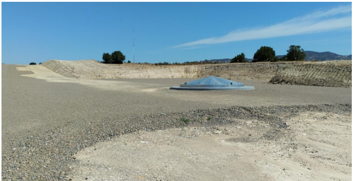
Situación a 25 de junio de 2024 tras el octavo mes de obras
