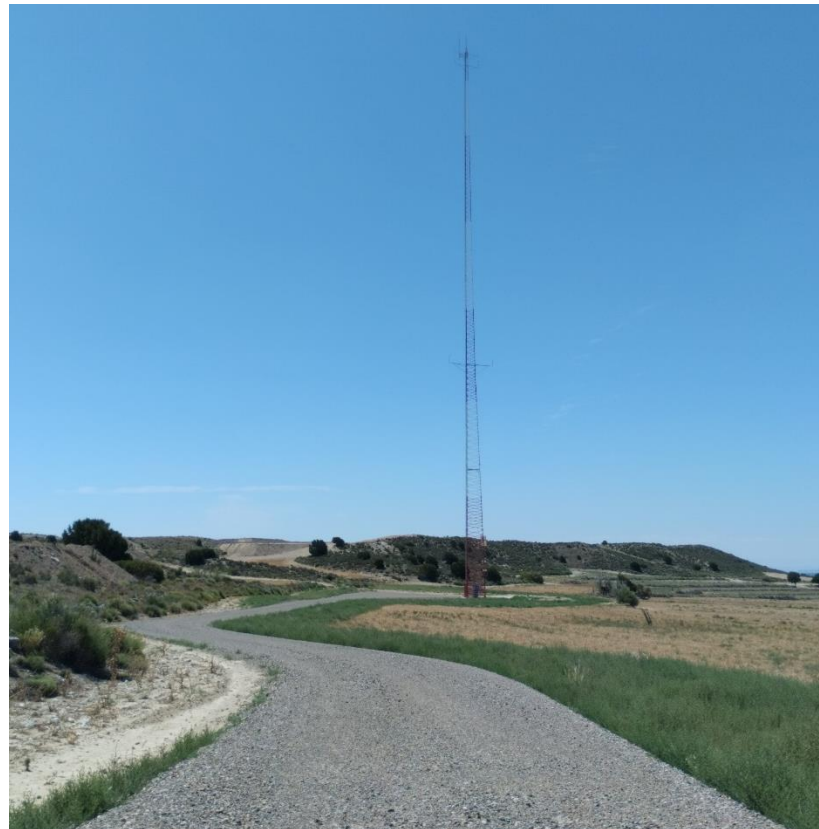
Situación a 25 de junio de 2024 tras el octavo mes de obras
