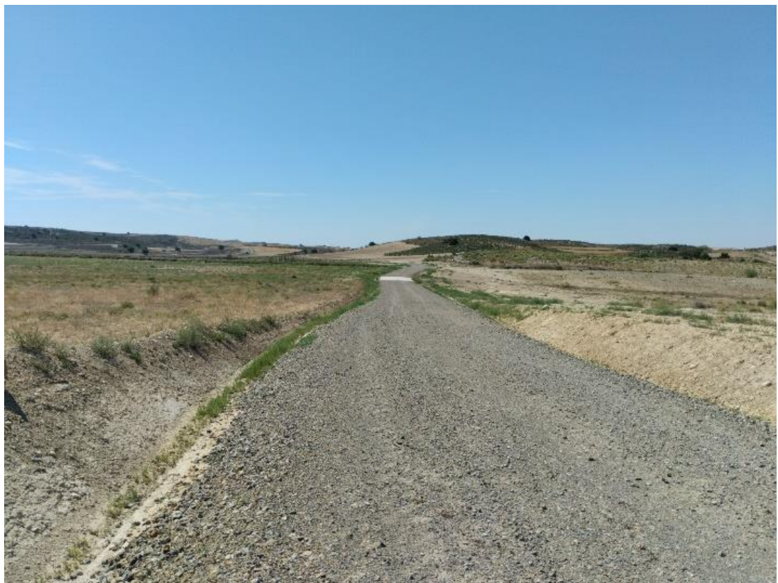
Situación a 25 de junio de 2024 tras el octavo mes de obras
