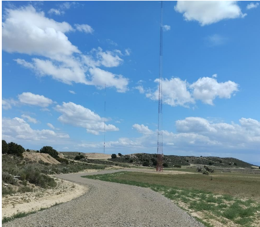
Situación a 21 de mayo de 2024 tras el séptimo mes de obras
