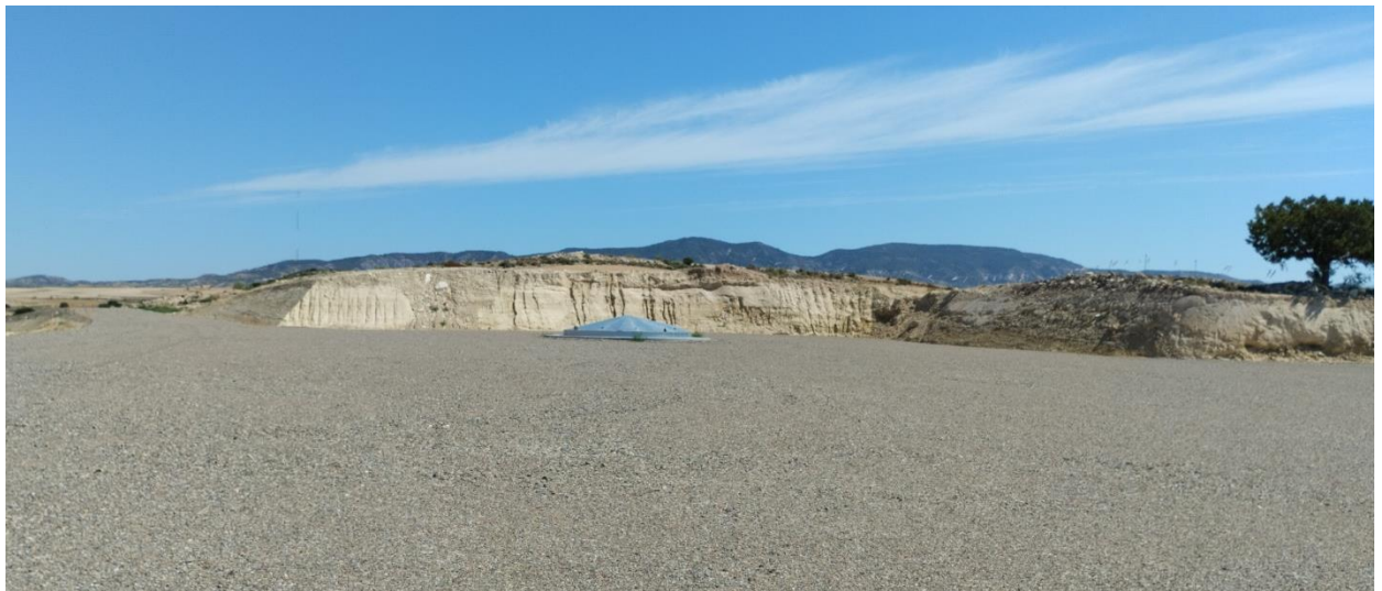
Situación a 25 de junio de 2024 tras el octavo mes de obras
