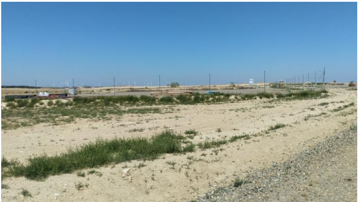
Situación a 25 de junio de 2024 tras el octavo mes de obras
