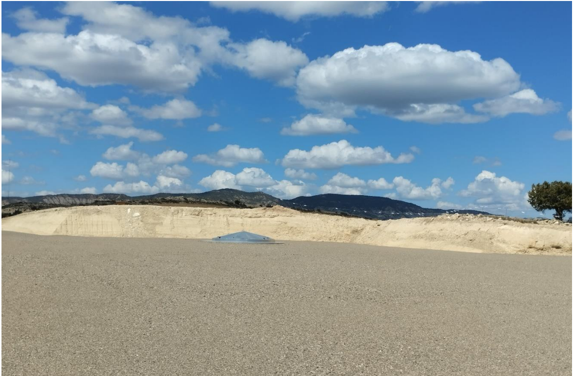
Situación a 21 de mayo de 2024 tras el séptimo mes de obras
