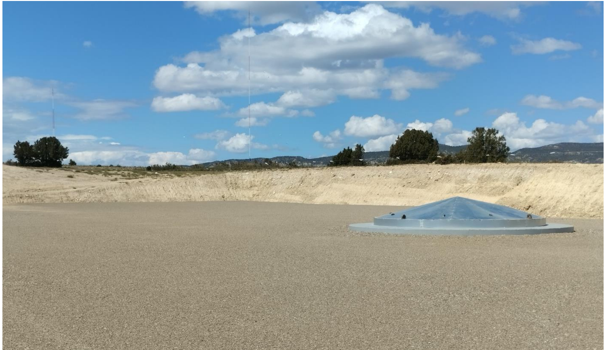
Situación a 21 de mayo de 2024 tras el séptimo mes de obras
