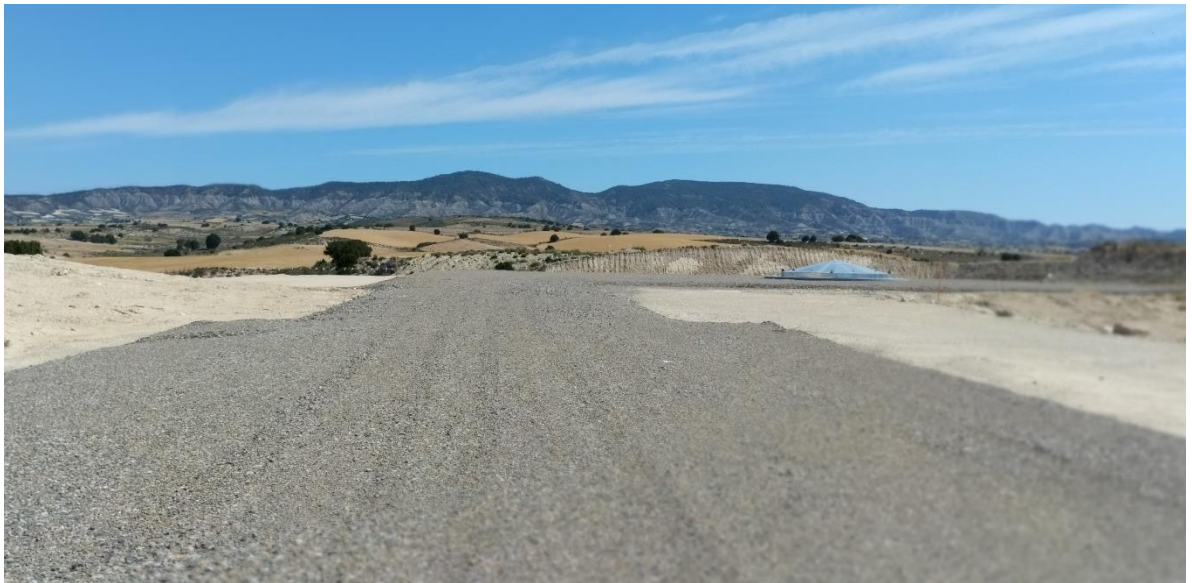
Situación a 25 de junio de 2024 tras el octavo mes de obras
