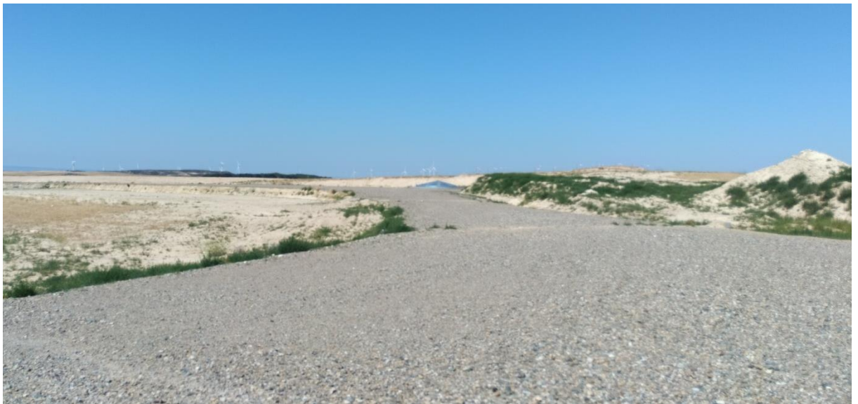
Situación a 25 de junio de 2024 tras el octavo mes de obras
