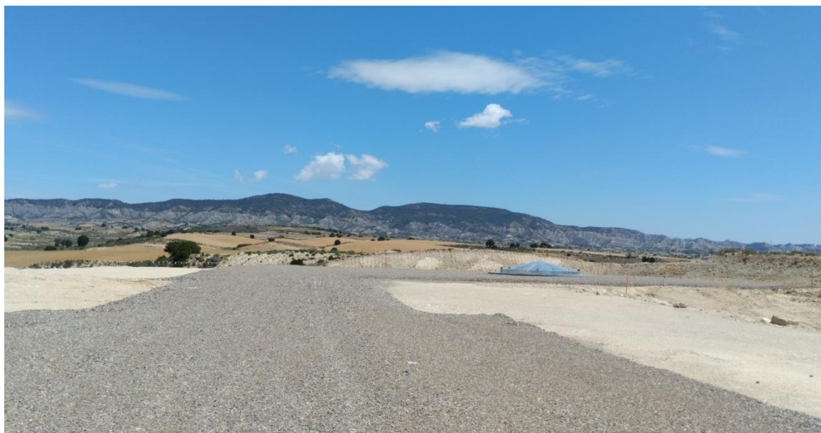
Estado de la plataforma del SAR 02 y su entorno el 14-06-24, tras el desmontaje de la TM provisional
