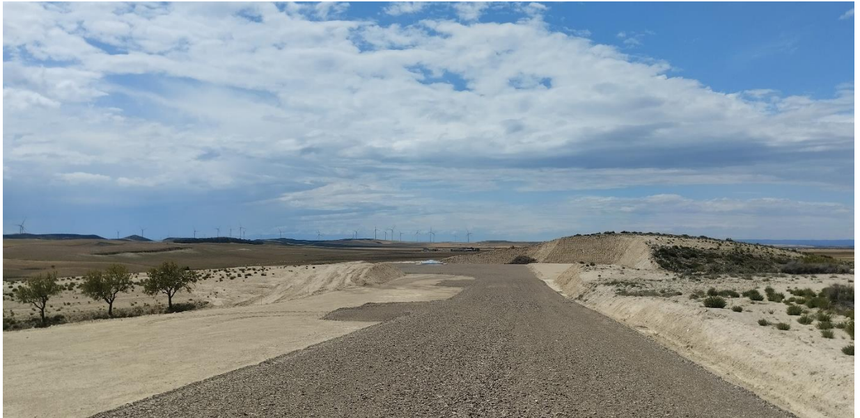
Situación a 21 de mayo de 2024 tras el séptimo mes de obras
