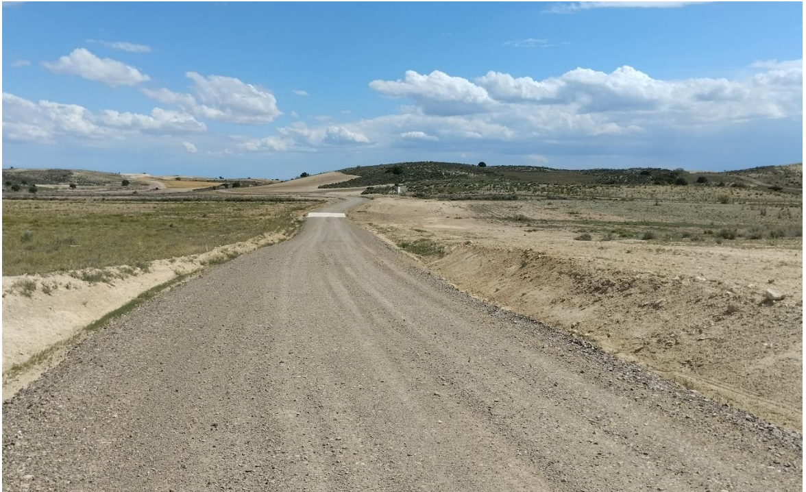
Situación a 21 de mayo de 2024 tras el séptimo mes de obras
