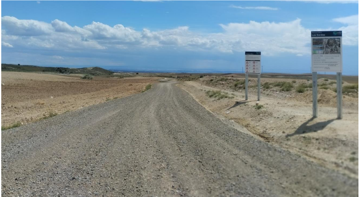
Situación a 21 de mayo de 2024 tras el séptimo mes de obras
