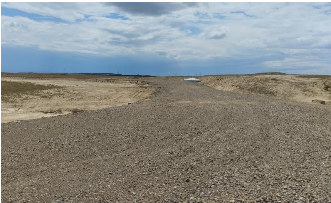
Situación a 21 de mayo de 202 tras el séptimo mes de obras
