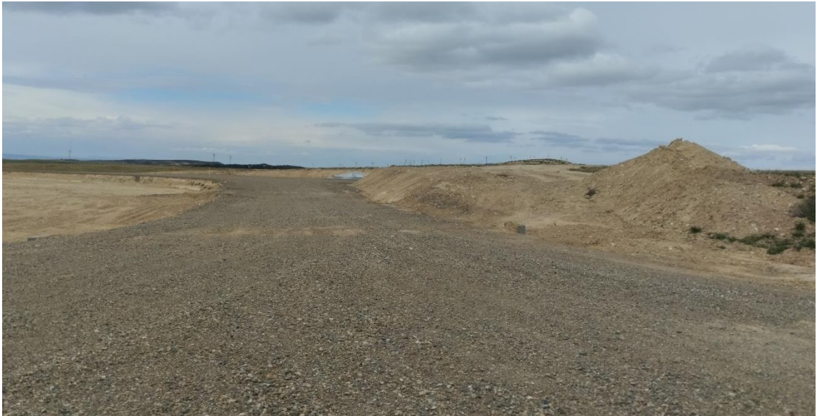
Situación a Situación a 25 de abril de 2024 tras el sexto mes de obras
