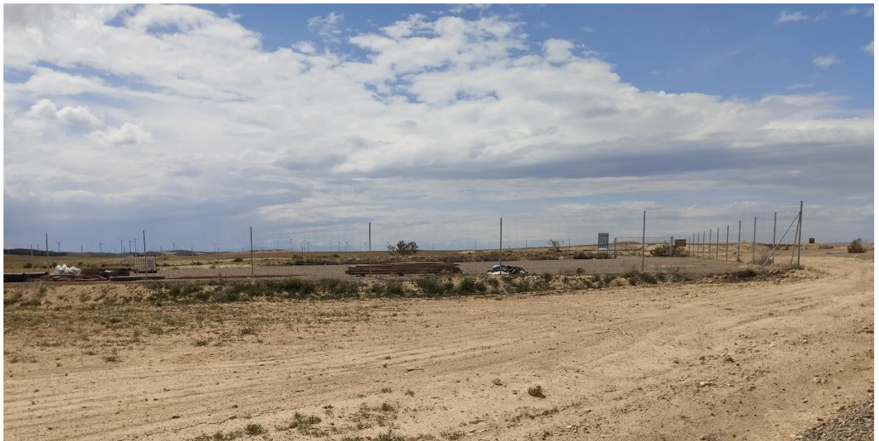
Situación a 21 de mayo de 202 tras el séptimo mes de obras
