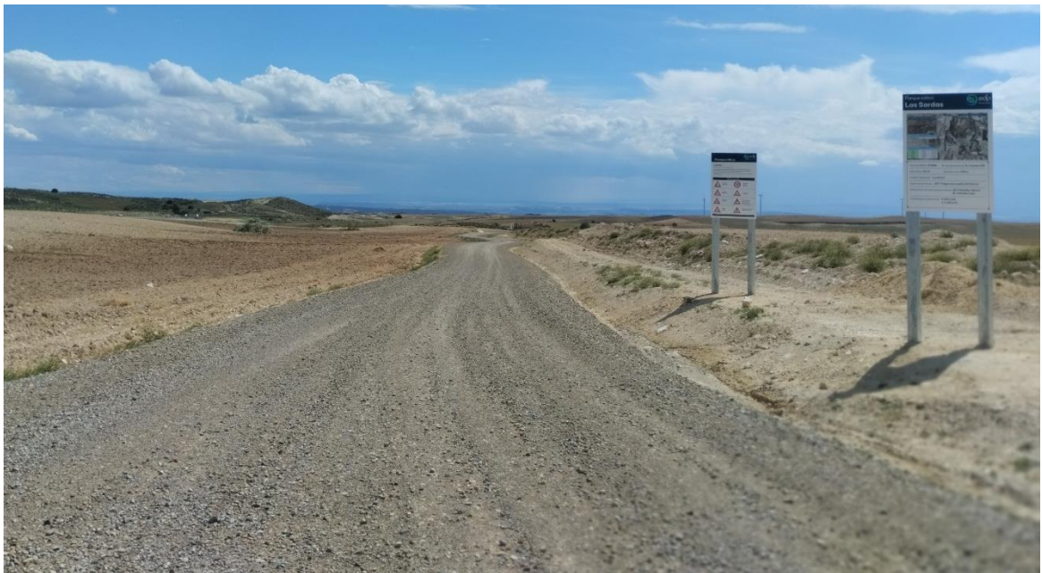
Situación a 21 de mayo de 202 tras el séptimo mes de obras
