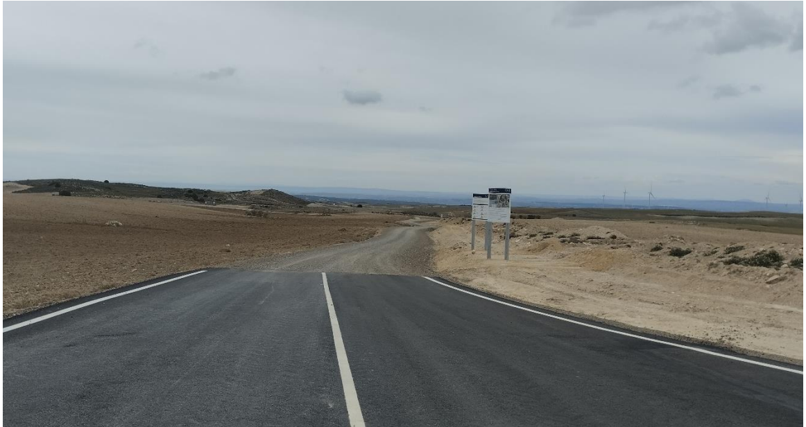
Situación a 25 de abril de 2024 tras el sexto mes de obras
