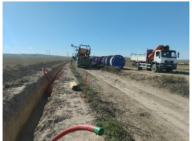
Tendiendo arena y cable en el sector intermedio de la zanja
