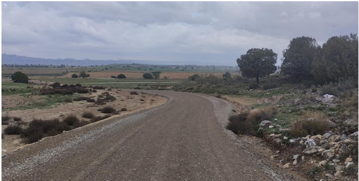
Situación a 31 de octubre de 2024 tras el duodécimo mes de obras
