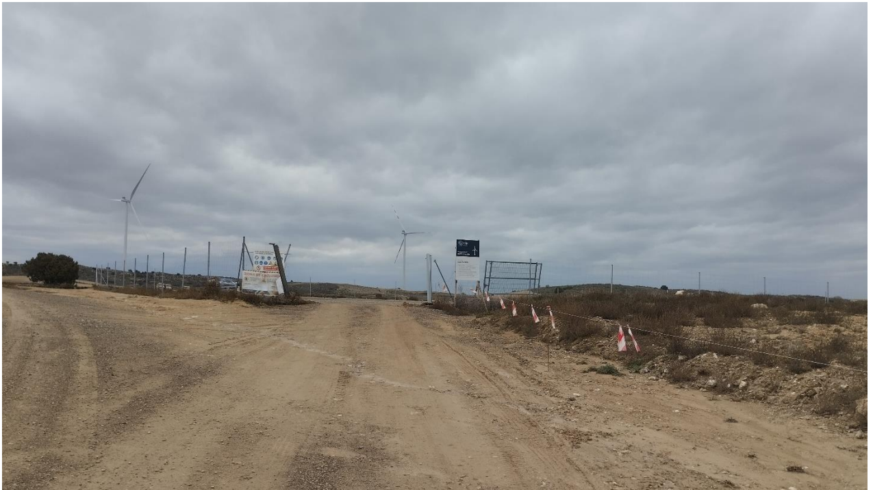
Situación a 31 de octubre de 2024 tras el duodécimo mes de obras
