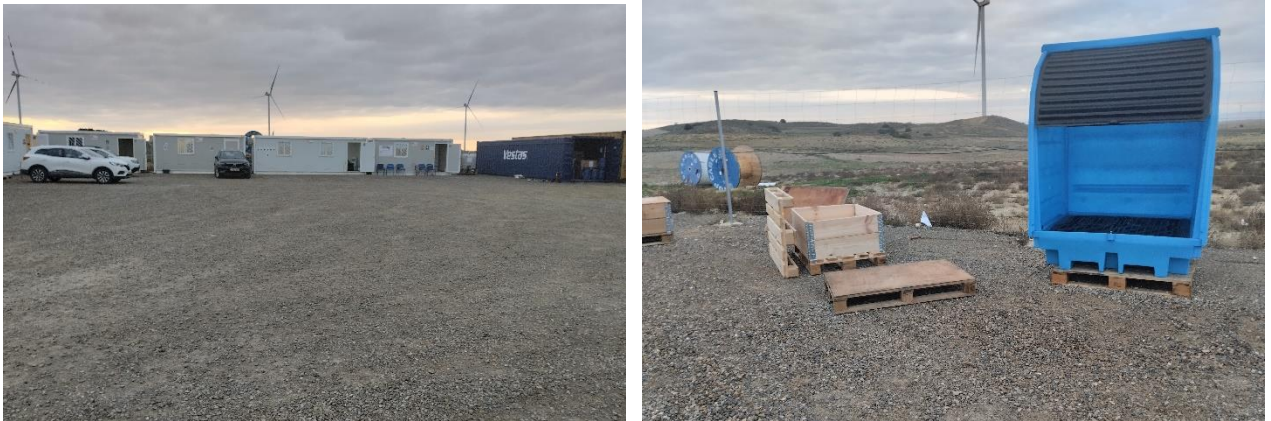
Estado general de la campa de obras, y punto limpio de RP de VESTAS, en fase de desmantelamiento
