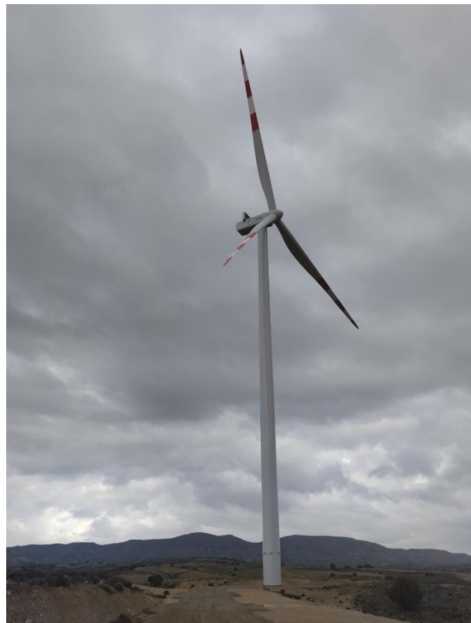
Situación a 31 de octubre de 2024 tras el duodécimo mes de obras
