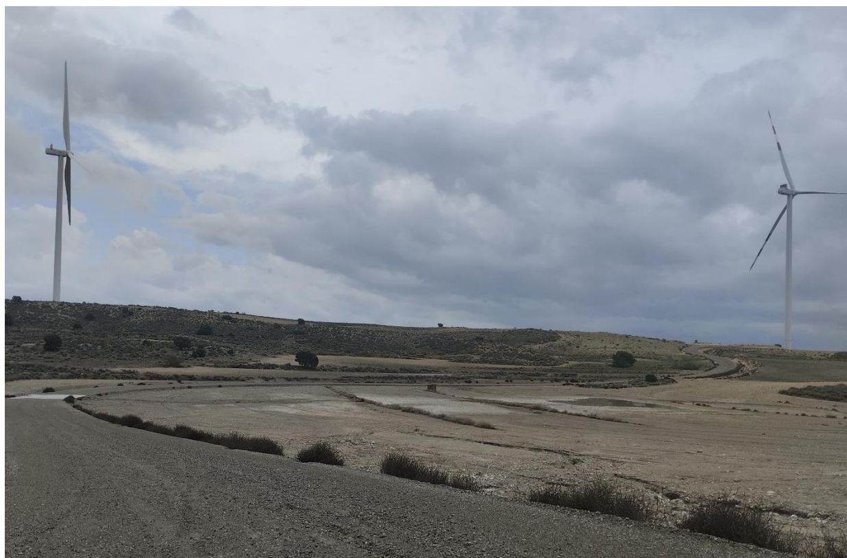
Situación a 31 de octubre de 2024 tras el duodécimo mes de obras
