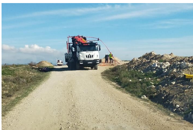
Colocando cables y arena en el sector central de la zanja, y estado de la SET, a la espera del nuevo trafo
