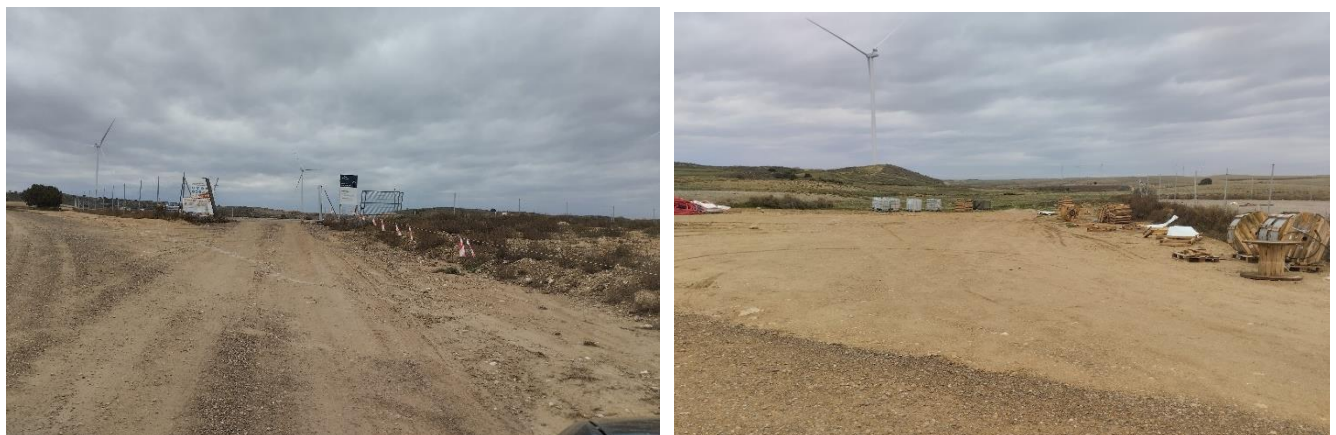
Campa de obras -izda.- y zona de ampliación adyacente -dcha.-, en fase de desmantelamiento
