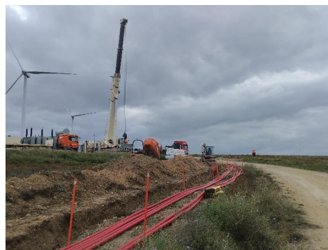
Colocación del nuevo trafo y tendido de cables en el sector de la zanja de conexión con la SET
