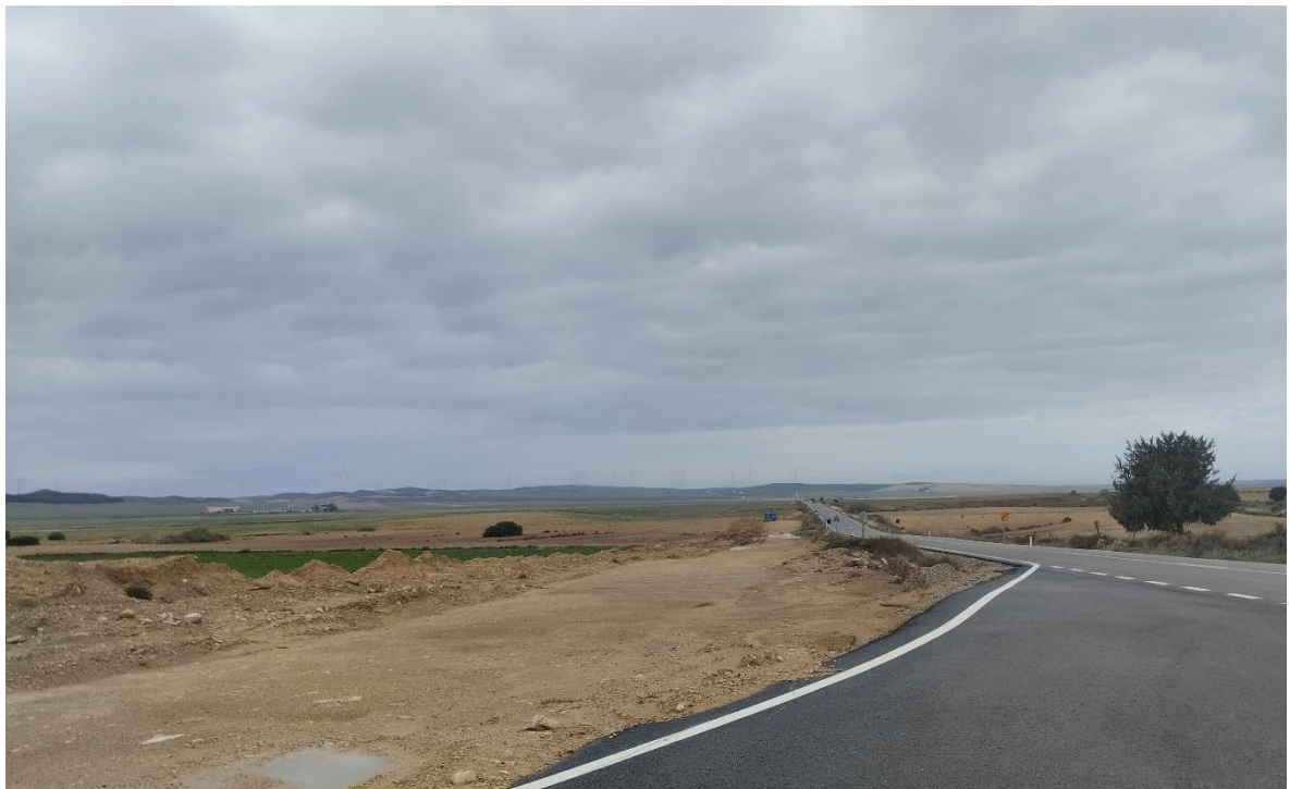
Situación a 31 de octubre de 2024 tras el duodécimo mes de obras
