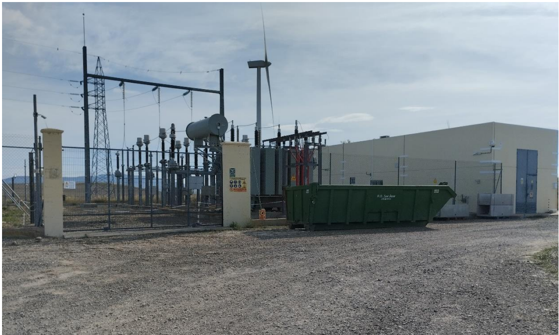
Situación a 25 de septiembre de 2024 tras el undécimo mes de obras
