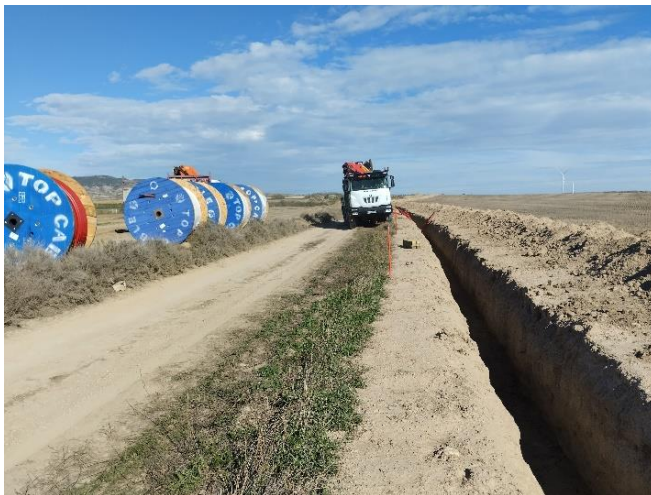
Tendiendo arena y cable en el sector intermedio de la zanja
