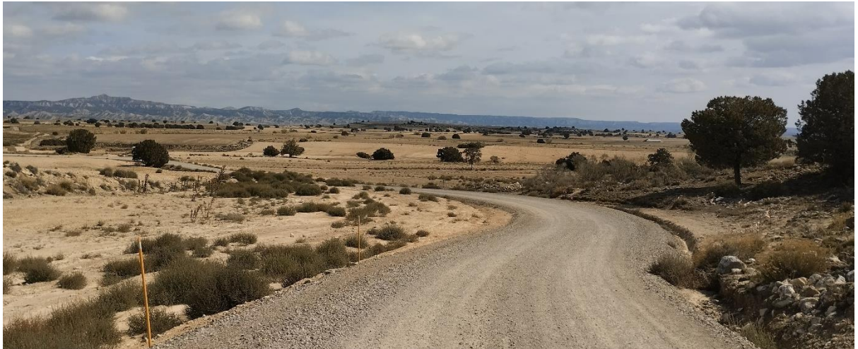
Situación a 25 de septiembre de 2024 tras el undécimo mes de obras
