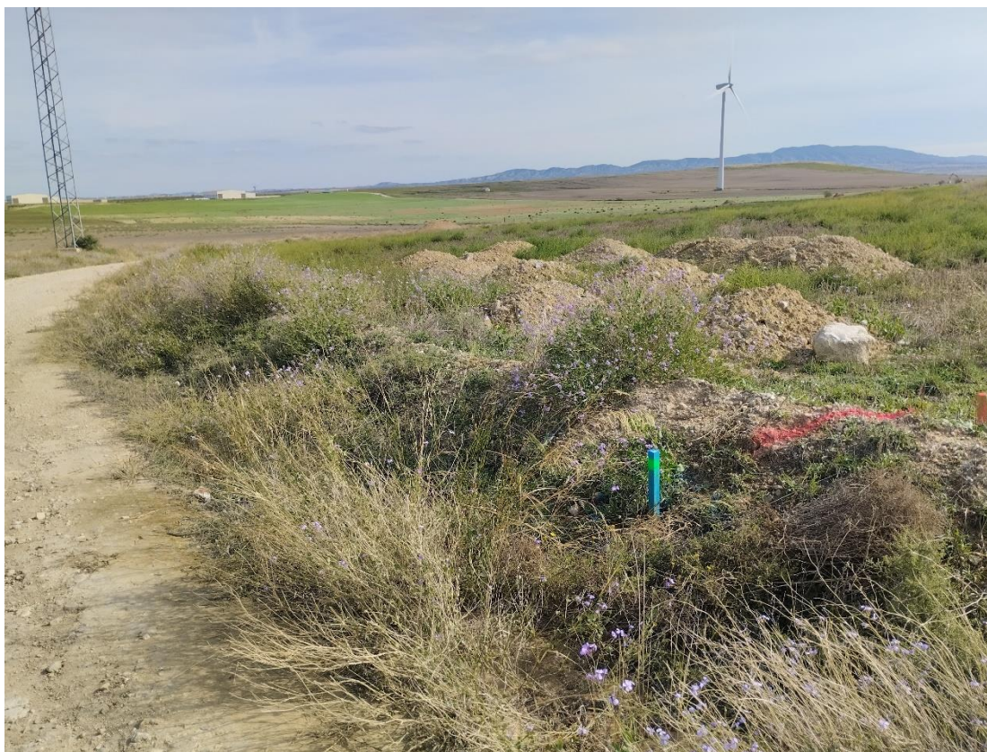
Situación a 25 de septiembre de 2024 tras el undécimo mes de obras
