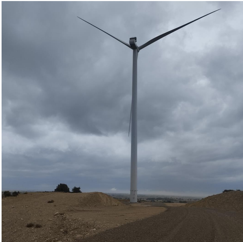
Situación a 31 de octubre de 2024 tras el duodécimo mes de obras
