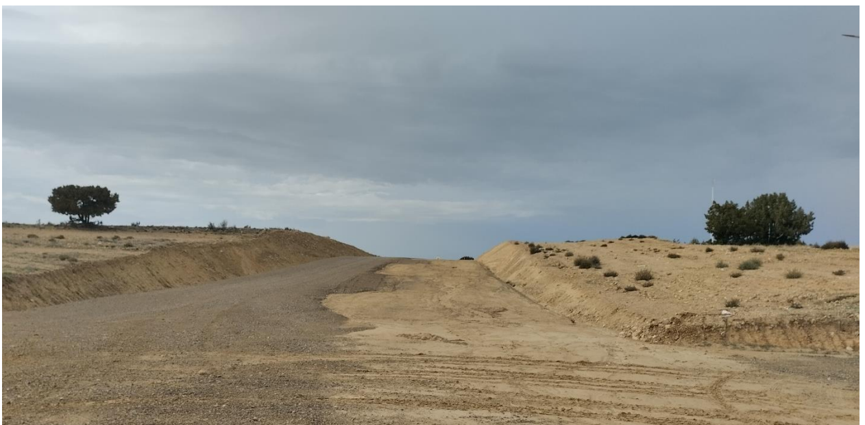
Plataforma auxiliar ejecutada para armar la grúa principal que participó en el izado del aerogenerador SAR 03: la idea es rellenar por completo el desmonte realizado que se aprecia a la derecha de la fotografía, desde el borde del vial hasta el terreno natural.
