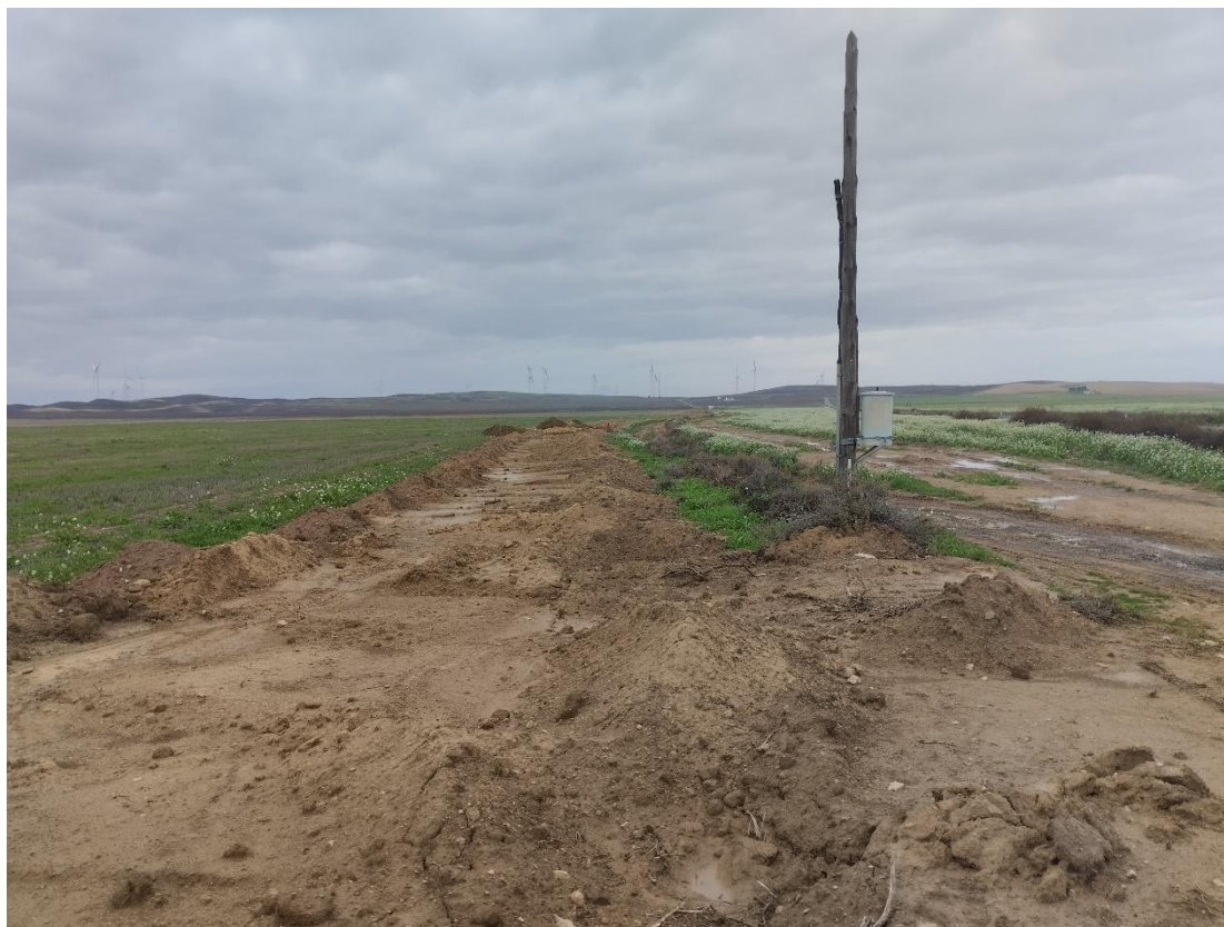
Situación a 31 de octubre de 2024 tras el duodécimo mes de obras
