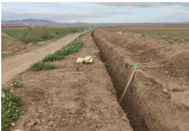
Zanja de conexión PE - SET Virgen de la Peña, tramo intermedio: colocando cables y arena, y comenzando tapado parcial.
