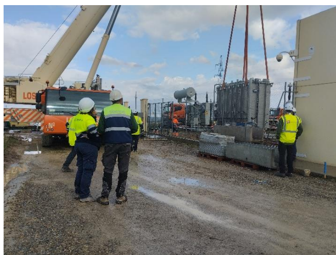
Colocación del nuevo trafo y tendido de cables en el sector de la zanja de conexión con la SET
