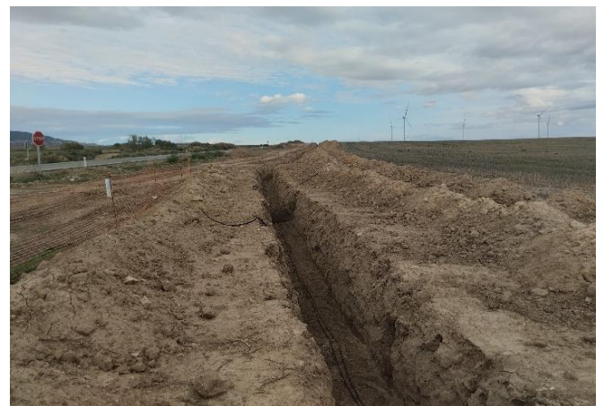
Zanja de conexión PE - SET Virgen de la Peña, tramo intermedio: colocando cables y arena, y comenzando tapado parcial.
