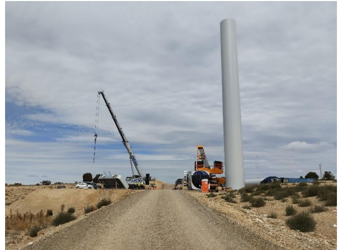
Izda., plataforma del SAR 01, con los elementos del aerogenerador acopiados. Dcha. SAR 03, con el primer tramo del fuste ya izado
