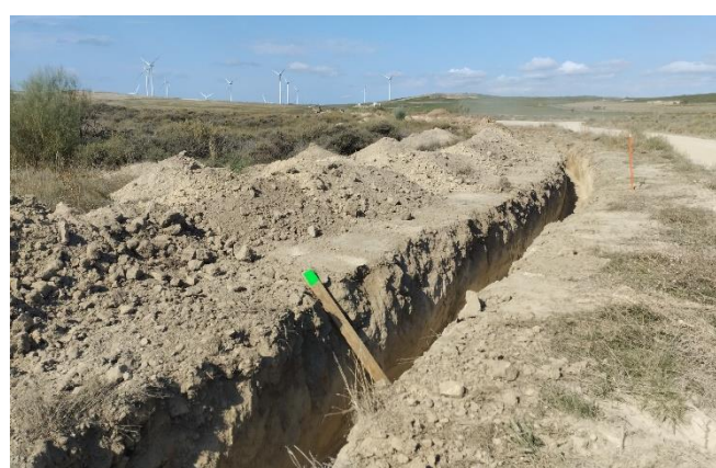
Avance de los trabajos de la zanja de conexión PE - SET Virgen de la Peña
