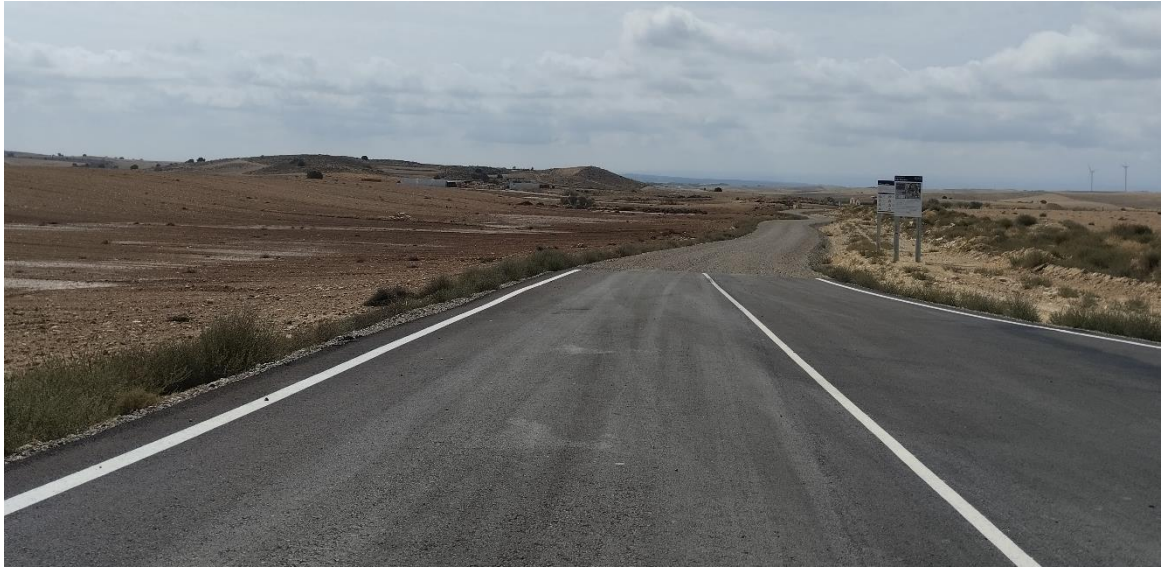
Situación a 30 de agosto de 2024 tras el décimo mes de obras
