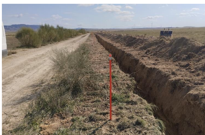
Avance de los trabajos de la zanja de conexión PE - SET Virgen de la Peña
