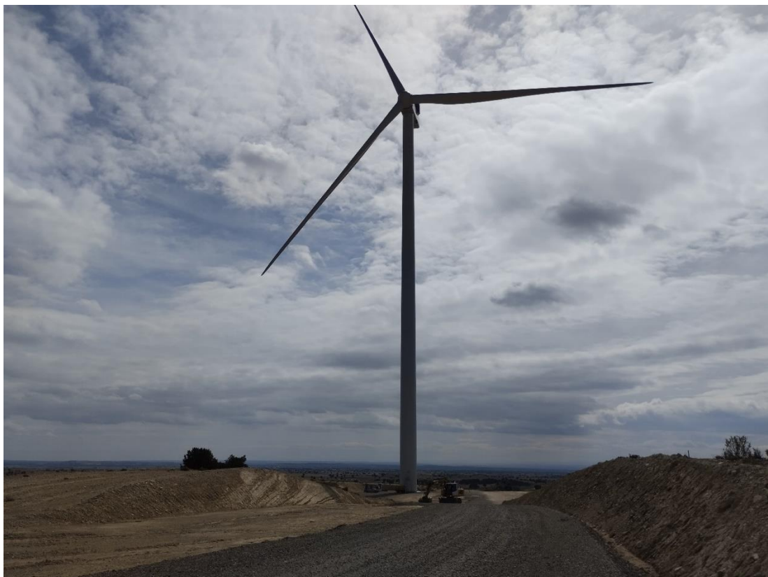
Situación a 25 de septiembre de 2024 tras el undécimo mes de obras
