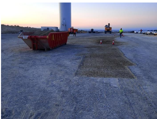
Estado de los terrenos tras retirar las zahoras contaminadas, y contenedor en donde se depositaron
