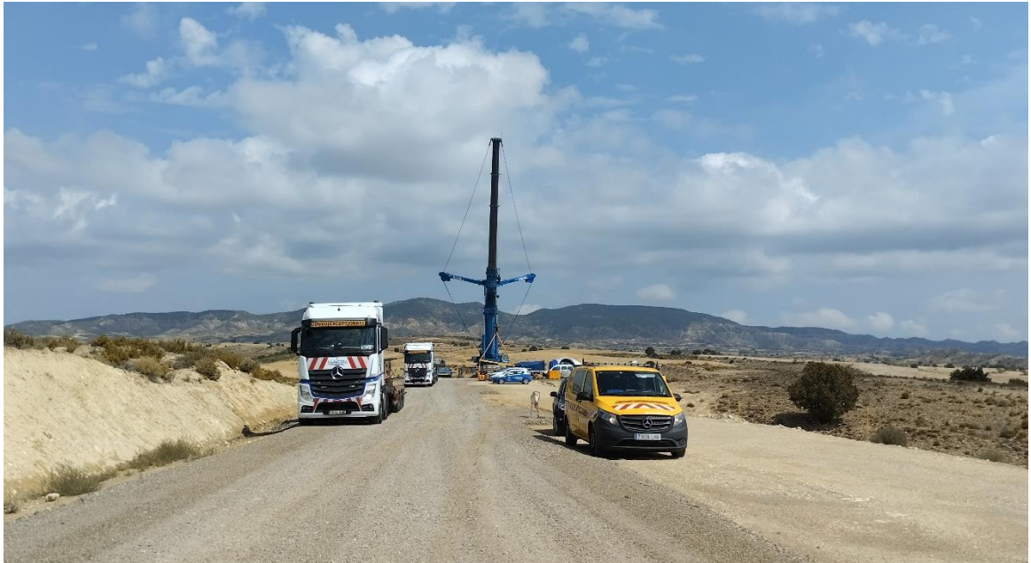
Situación a 30 de agosto de 2024 tras el décimo mes de obras
