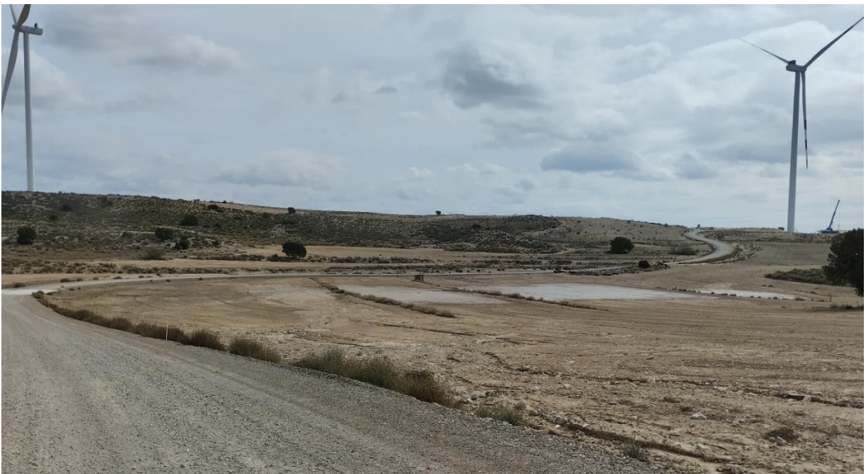
Situación a 25 de septiembre de 2024 tras el undécimo mes de obras
