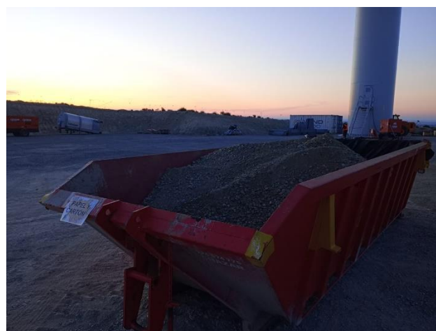
Estado de los terrenos tras retirar las zahoras contaminadas, y contenedor en donde se depositaron
