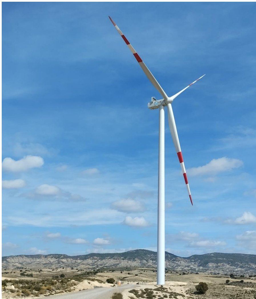
Situación a 25 de septiembre de 2024 tras el undécimo mes de obras
