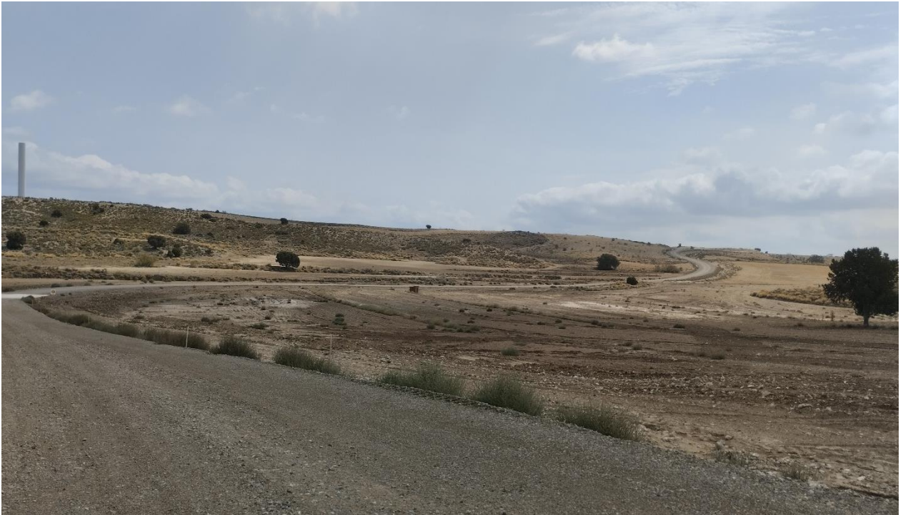
Situación a 30 de agosto de 2024 tras el décimo mes de obras
