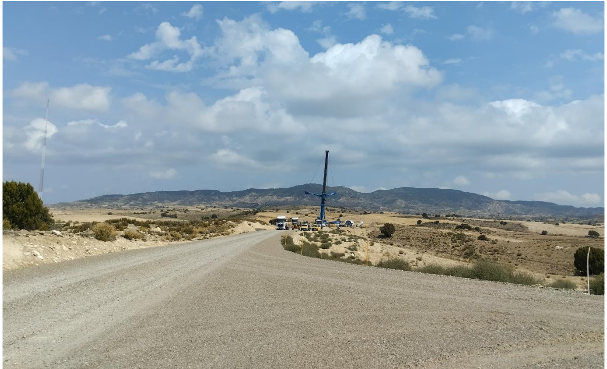
Situación a 30 de agosto de 2024 tras el décimo mes de obras
