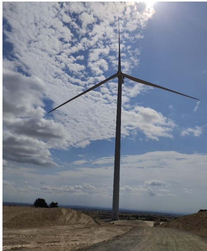
Aerogenerador SAR 03, completamente izado el 19-09-24
