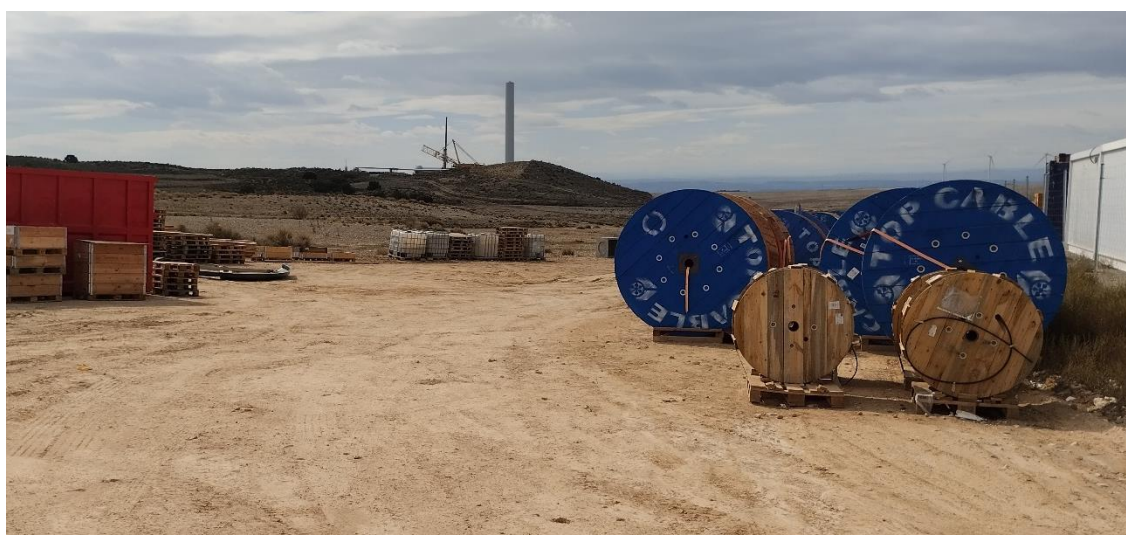
Situación a 25 de septiembre de 2024 tras el undécimo mes de obras
