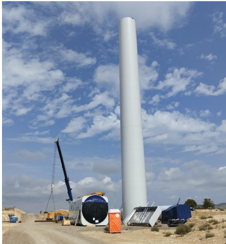
Situación a 30 de agosto de 2024 tras el décimo mes de obras
