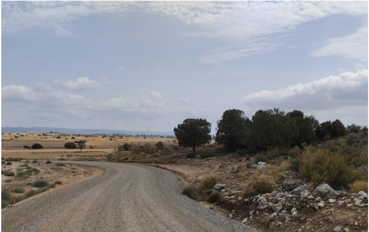
Situación a 30 de agosto de 2024 tras el décimo mes de obras
