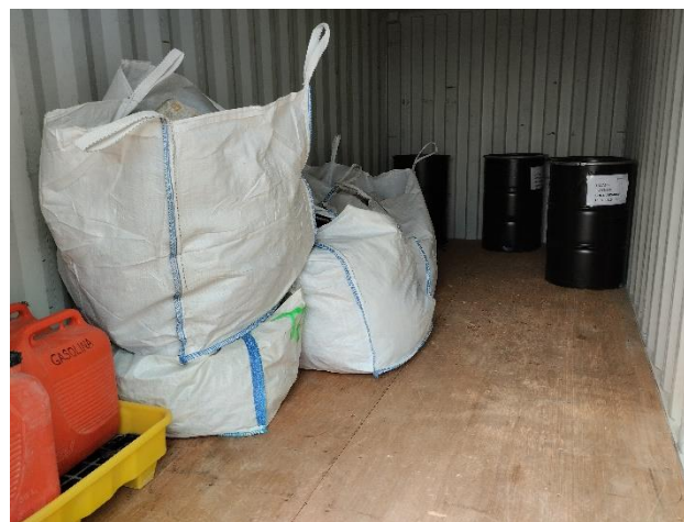
Punto limpio de RP de SIEMSA, en orden y empleado tanto por la contrata de obra civil como por la de montaje de aerogeneradores (las sacas contienen sacos de cemento -residuo que incluye papel, plástico y cemento- empleados en el grouting de la base de los aerogeneradores)
