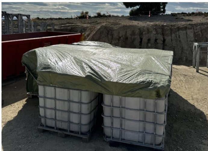
GRG con las zahoras contaminadas en la plataforma del SAR 03, debidamente tapados, a la espera de su retirada por el gestor
