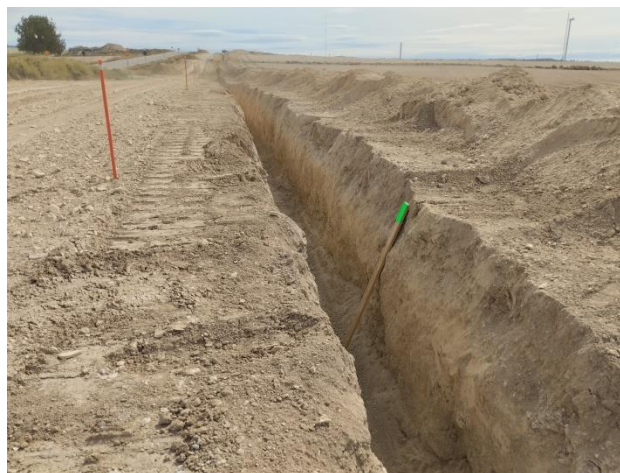
Zanja de conexión PE - SET Virgen de la Peña: detalle de la colocación de tablones de escape
