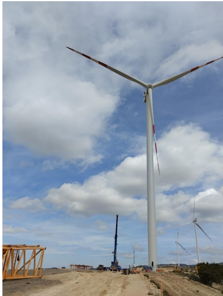
Situación a 25 de septiembre de 2024 tras el undécimo mes de obras
