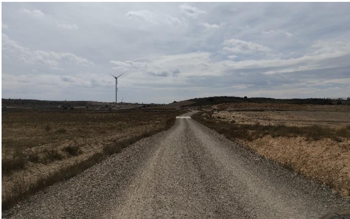
Situación a 25 de septiembre de 2024 tras el undécimo mes de obras
