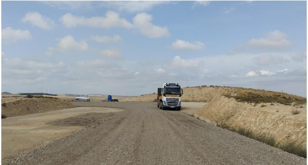
Situación a 30 de agosto de 2024 tras el décimo mes de obras
