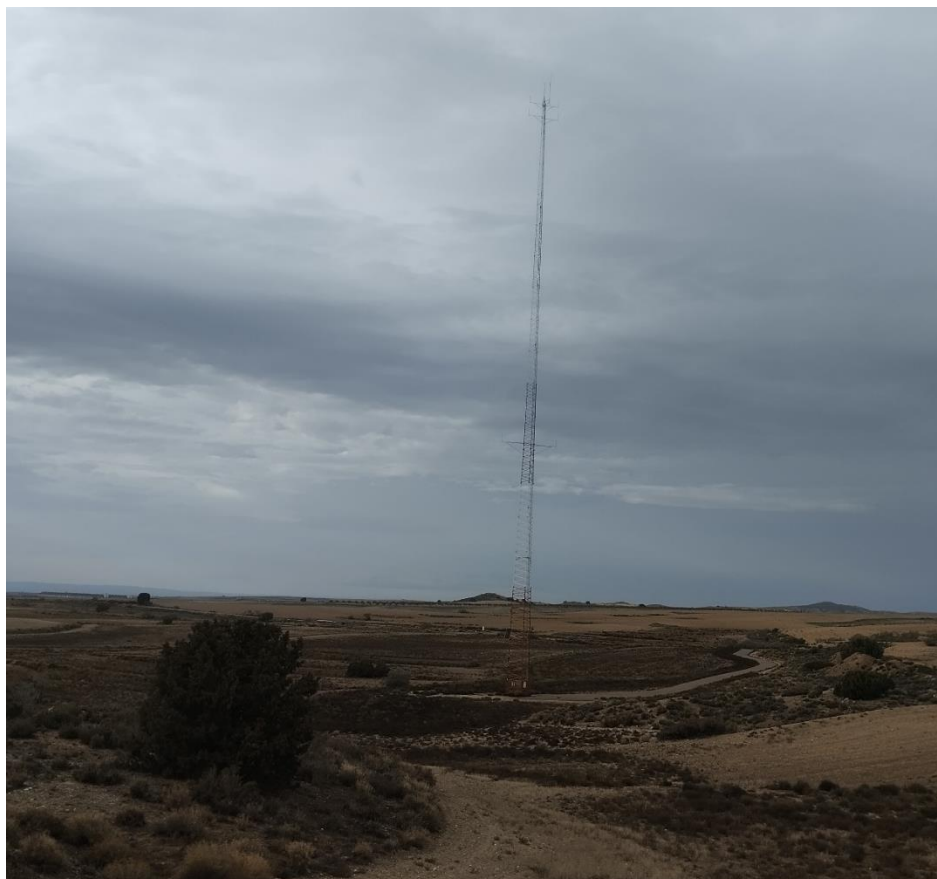
Situación a 25 de septiembre de 2024 tras el undécimo mes de obras
