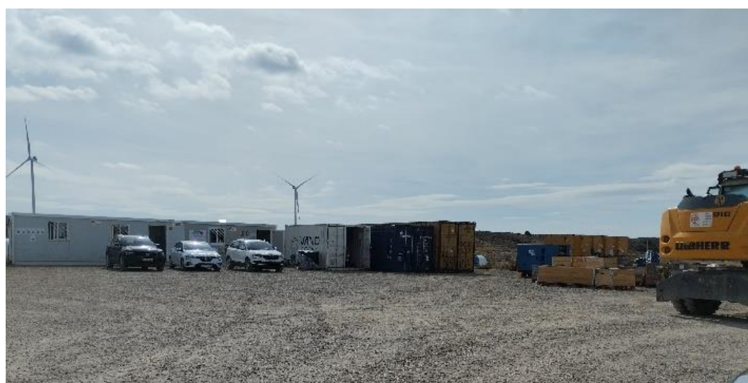
Situación a 25 de septiembre de 2024 tras el undécimo mes de obras
