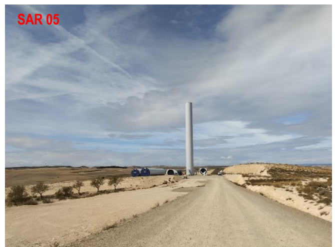
Montaje de los aerogeneradores, el 12-09-24
