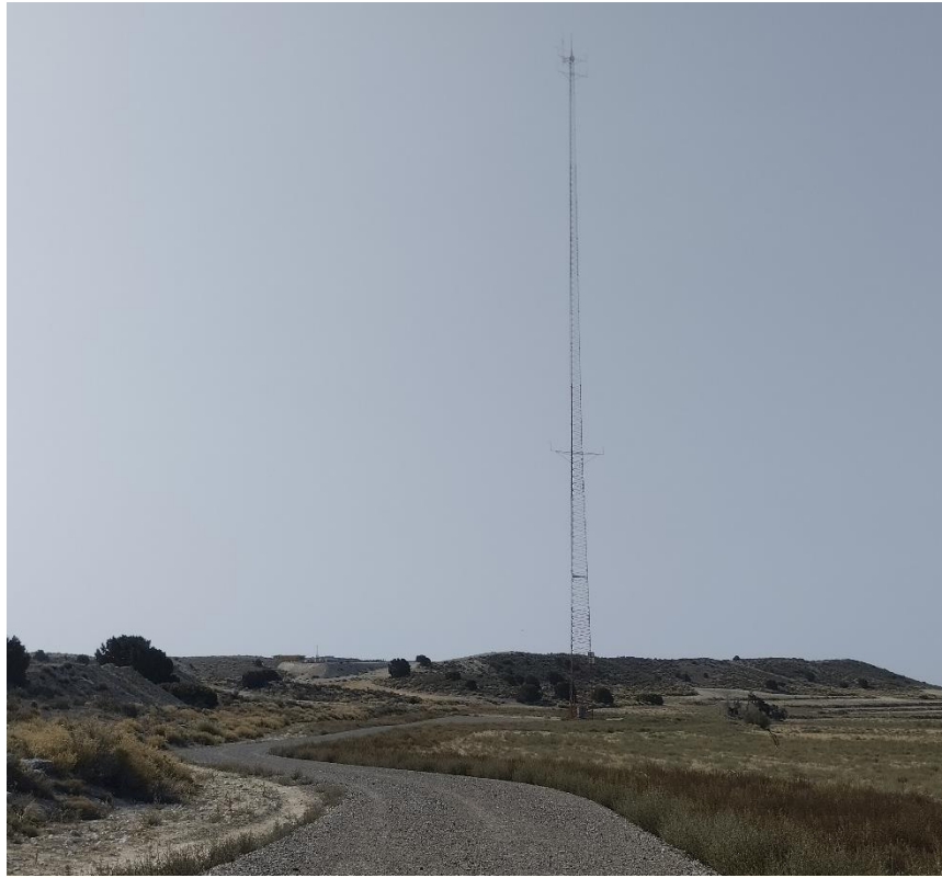
Situación a 30 de agosto de 2024 tras el décimo mes de obras
