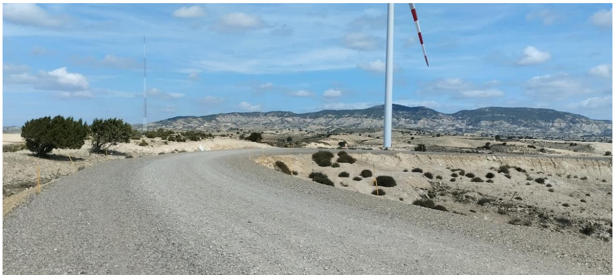
Situación a 25 de septiembre de 2024 tras el undécimo mes de obras
