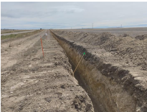
Zanja de conexión PE - SET Virgen de la Peña: detalle de la colocación de tablones de escape
