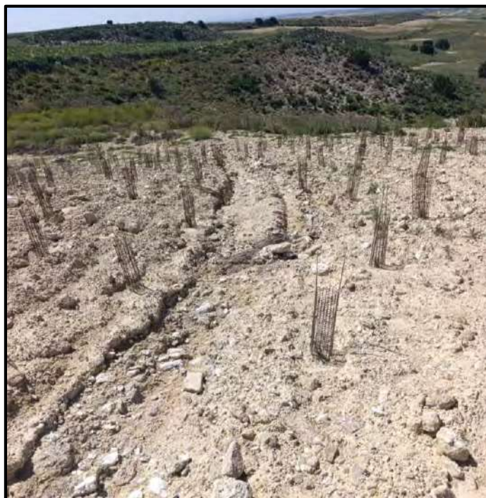
Fotografía 4. Ejemplo de los procesos erosivos de pequeña magnitud en la turbina SAR05
