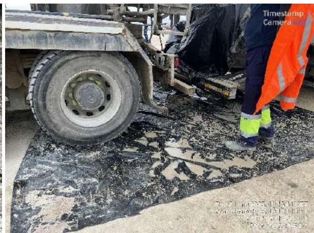
Restos de basuras en plataforma MR2-8. Impermeabilización del suelo durante hormigonados.
