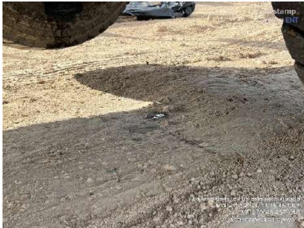
Goteo de aceite en grúa - pluma. Limpieza del entorno MR2-1.
