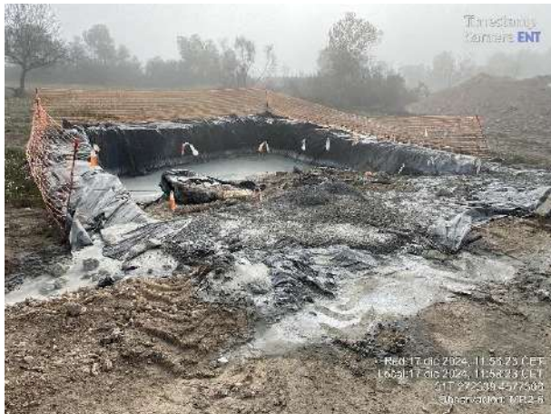
Derrame y vertido de hormigón fuera de balsa en MR2-6. Residuo peligroso en contenedor de chatarra.
