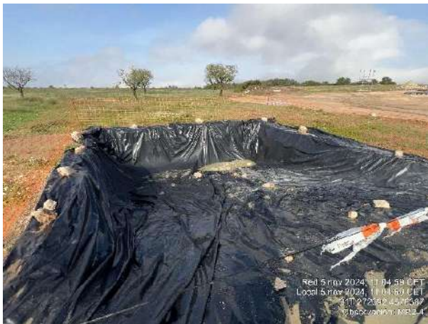
Balsa de lavado de cubas en MR2-4. Trabajos de hormigonado en MR2-5.
