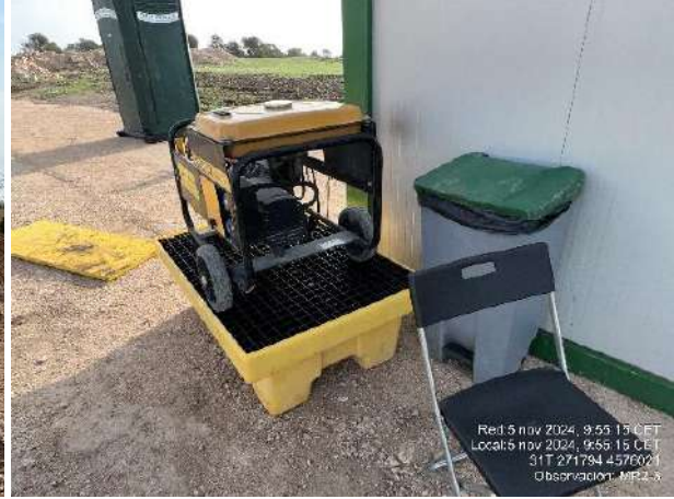
Revisión de acopios de T.V. Grupo electrógeno sobre bandeja antiderrame.
