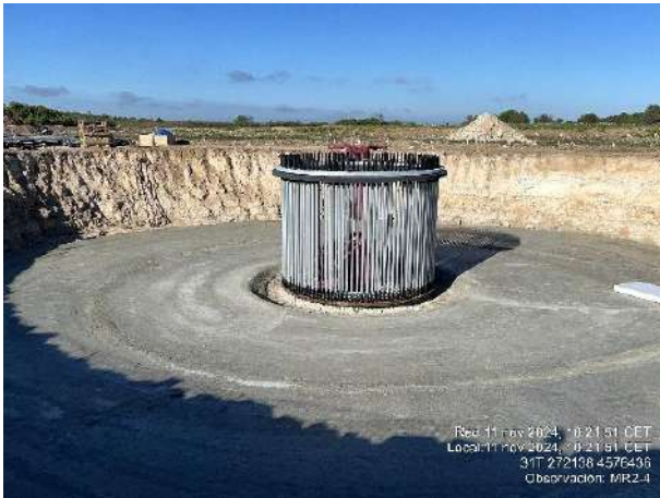
Hormigonado de limpieza en MR2-4. Martillo sin manta absorbente en MR2-7.
