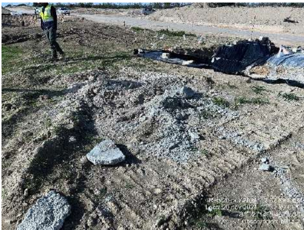
Vertido de hormigón fuera de balsa en MR2-2. Trabajos de ferrallado en MR2-2.
