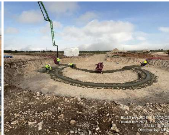
Balsa de lavado de cubas en MR2-4. Trabajos de hormigonado en MR2-5.
