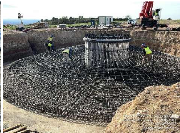
Vertido de hormigón fuera de balsa en MR2-2. Trabajos de ferrallado en MR2-2.
