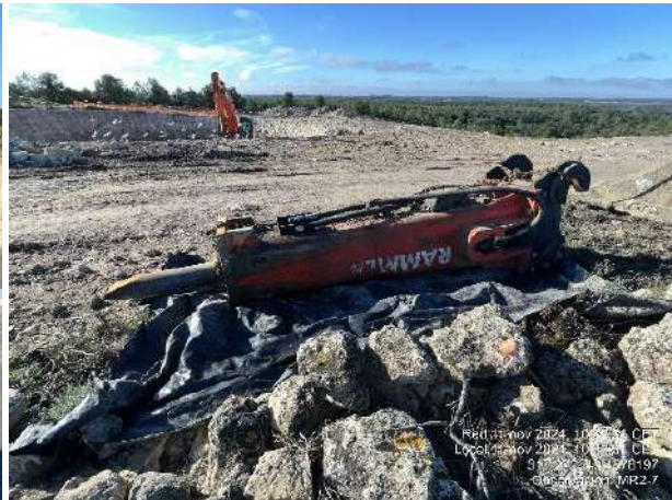
Hormigonado de limpieza en MR2-4. Martillo sin manta absorbente en MR2-7.
