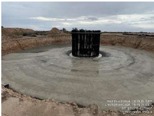
Jaula de pernos y hormigonado en MR2-2. Basuras pendientes de retirada en plataforma MR2-2.
