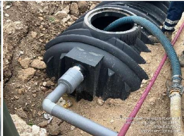
Estado de vial agrícola tras lluvias. Vaciado de depósito de aguas negras.
