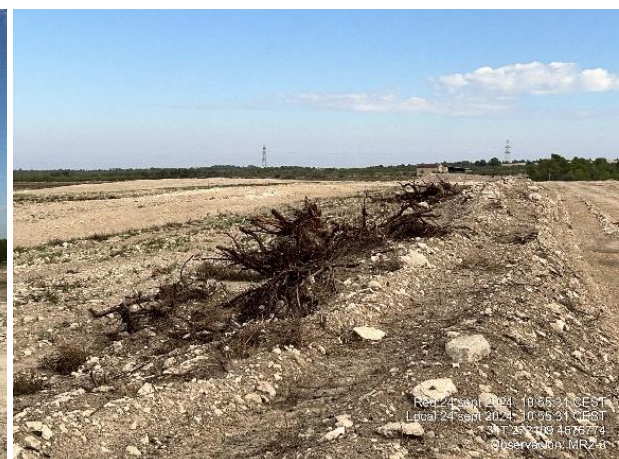
Trabajos de excavación en MR2-4. Tocones sobre T.V. en MR2-5.
