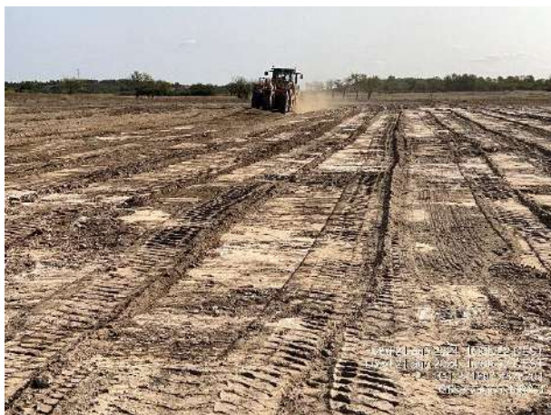
Retirada de tierra vegetal. Punto final de movimientos de tierra (vial entre MR2-6 y MR2-7).
