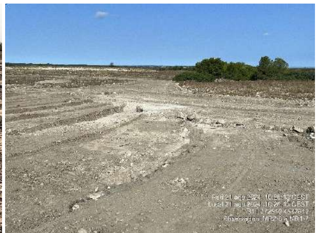
Retirada de tierra vegetal. Punto final de movimientos de tierra (vial entre MR2-6 y MR2-7).
