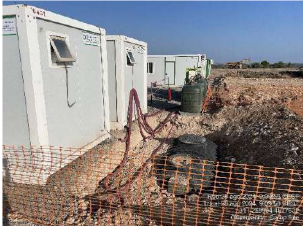
Instalación del depósito de aguas negras. Estado del bidón de tierras contaminadas.
