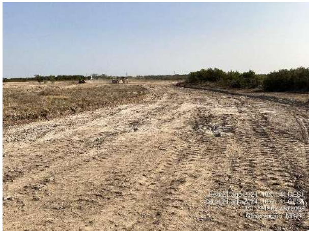
Retirada correcta de tierra vegetal en vial entre MR2-3 y MR2-4. Nueva señalización HIC.
