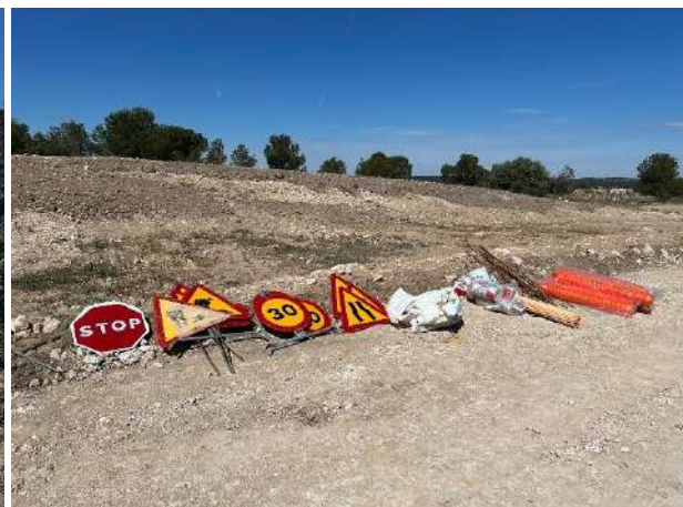
Ausencia de señalización de acceso a obra/salida de camiones y señales en camp site para ser ubicadas.
