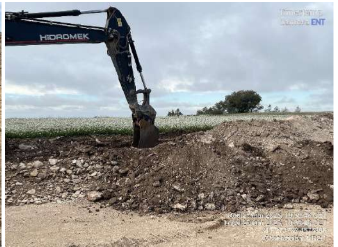
Imagen 1. Retoques en vial MR2-6 a MR2-7 e inicio de excavación de zanja para línea soterrada en MR2-1.
