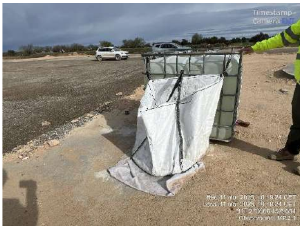
Manta geotextil absorbente bajo balsa utilizada en aplicación de grout, MR2-1.
