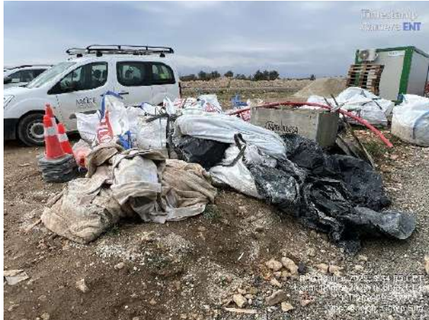
Residuos derivados de aplicación de grout fuera de campa habilitada. Plásticos y protecciones pendientes de limpieza.
