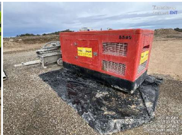
Manta geotextil absorbente bajo balsa utilizada en aplicación de grout, MR2-1.
