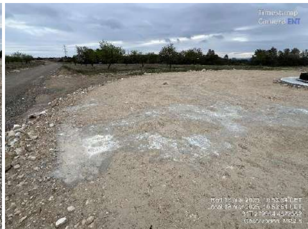
Relleno parcial en plataforma fingers, MR2-3. Aplicación de grout, restos endurecidos en superficie, MR2-6.
