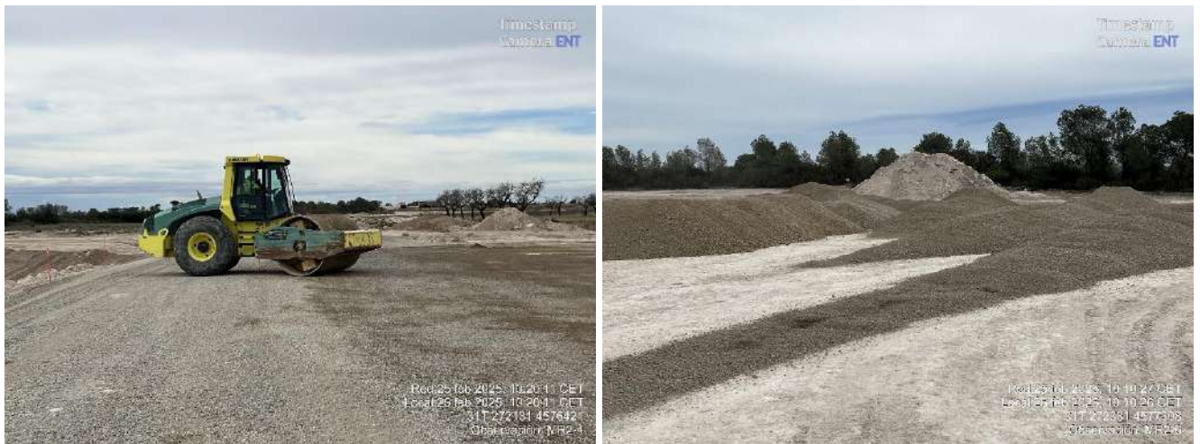
Imagen 1. Compactación y nivelación a cota en plataformas 4 y 6.
