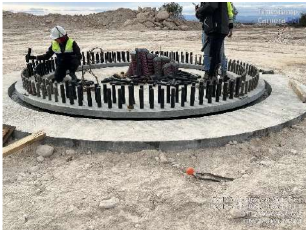
Nivelación de brida en MR2-1. Limpieza de derrame en MR2-8.
