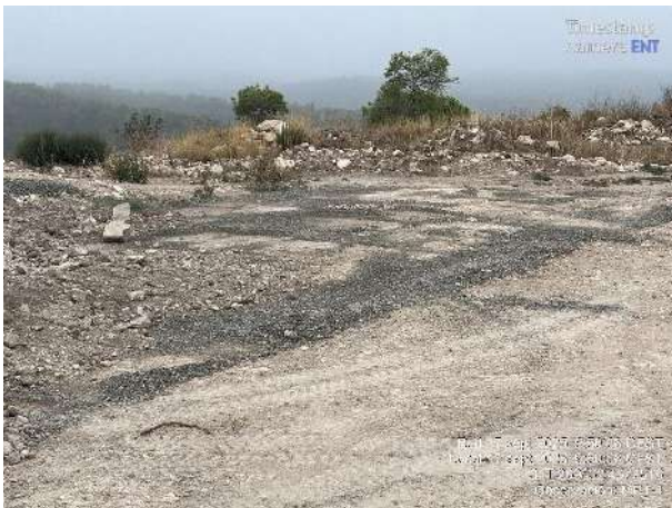
MR1-4, Exceso de zahorra no retirada. Sistema Bioseco instalado en MR1-1.
