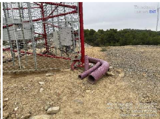
Compactación de material grueso en base de talud. Restos de tubo no retirados en Torre Meteorológica.
