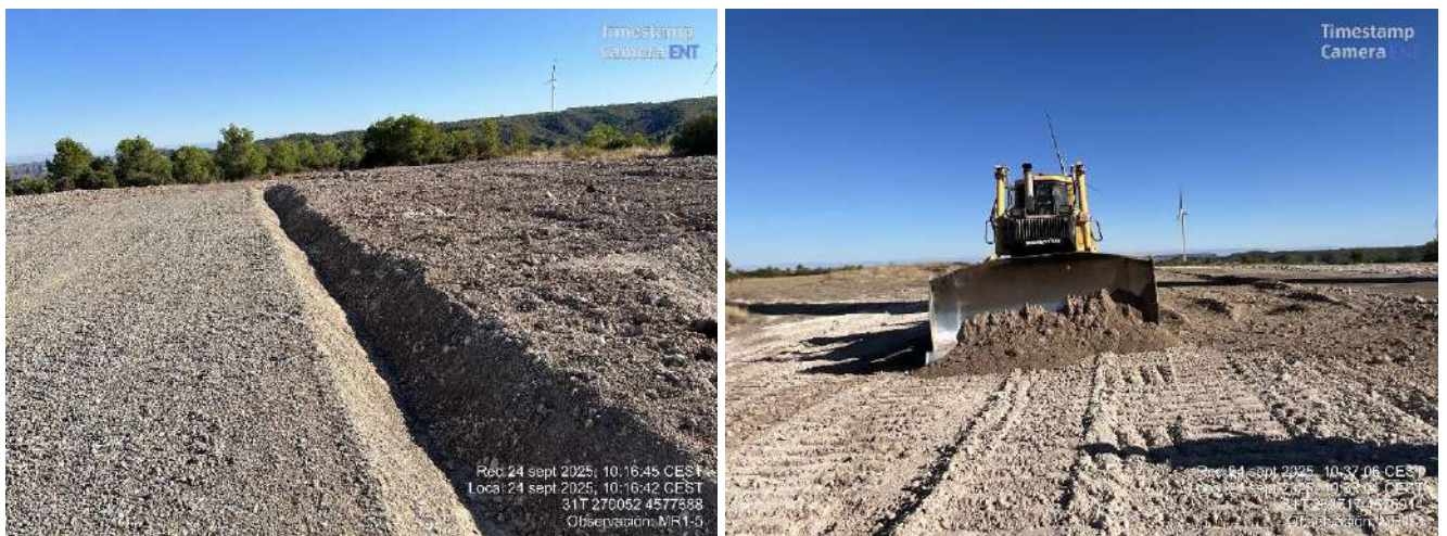
Imagen 1. Excavación de cunetas y extendido de tierra vegetal en plataformas temporales.
