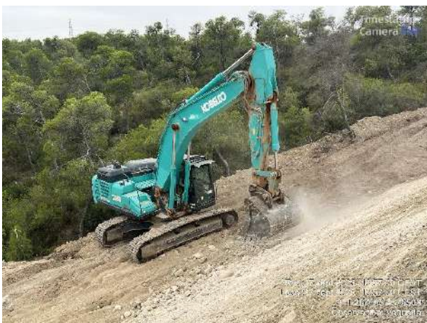
Compactación de material grueso en base de talud. Restos de tubo no retirados en Torre Meteorológica.
