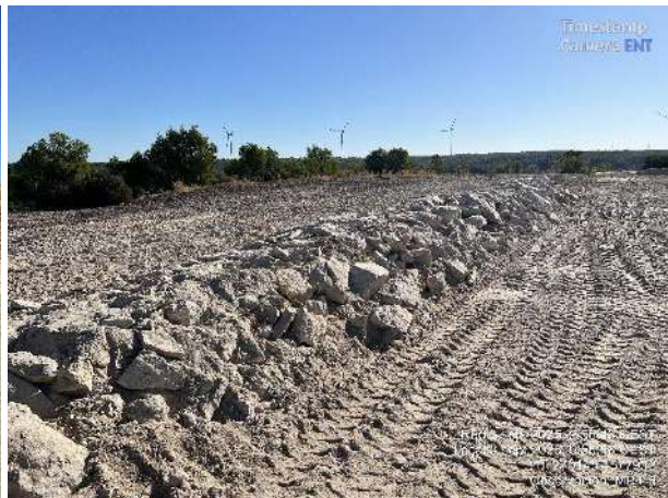
Retirada de zahora en plataforma temporal. Restitución de lindero mediante bloques.
