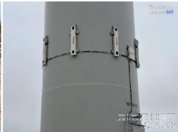
MR1-4, Exceso de zahorra no retirada. Sistema Bioseco instalado en MR1-1.
