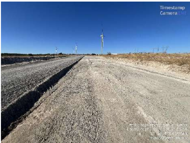
Retirada de zahora en plataforma temporal. Restitución de lindero mediante bloques.
