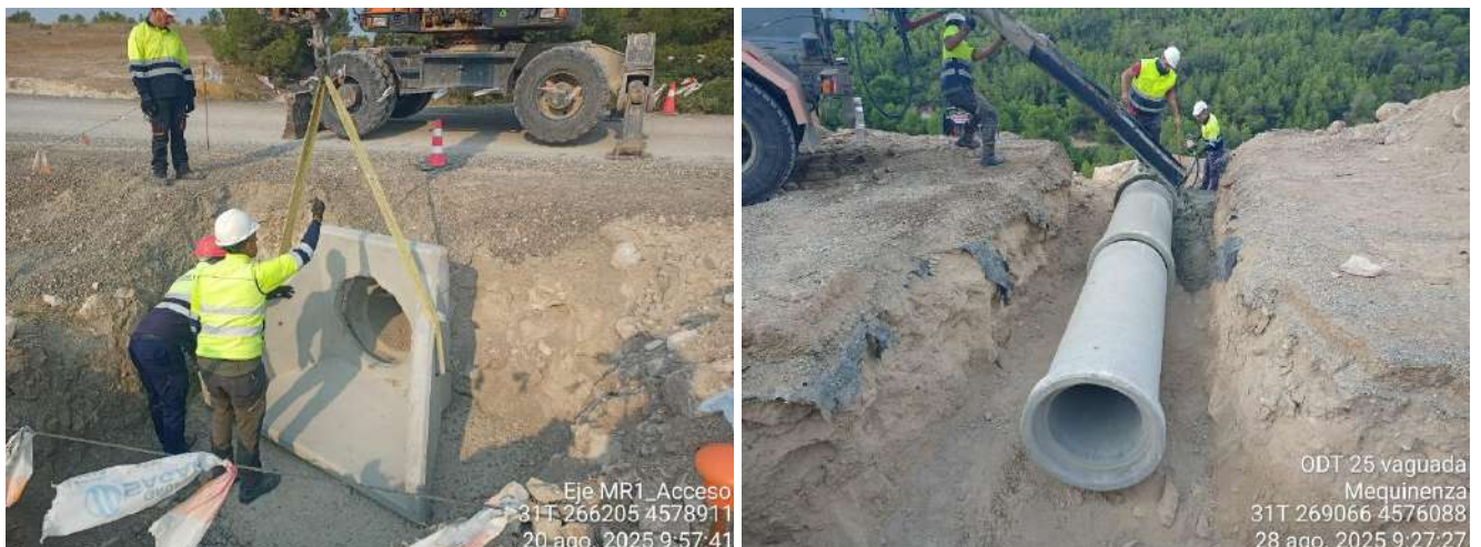
Imagen 1. Instalación de ODTs en vial principal próximo al acceso a parque-1 y en vaguada.
