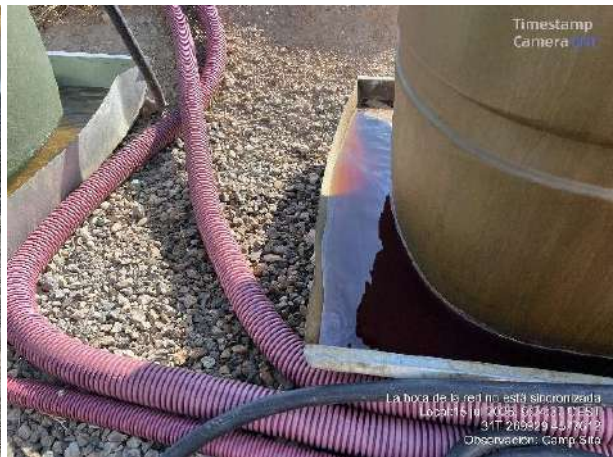
Derrame de líquido contaminado. Bandeja antiderrame al límite de desbordamiento.
