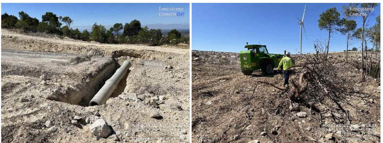
Imagen 1. Instalación de ODT en vial principal próximo a ME1-6. Retirada de material vegetal seco en MR1-7.
