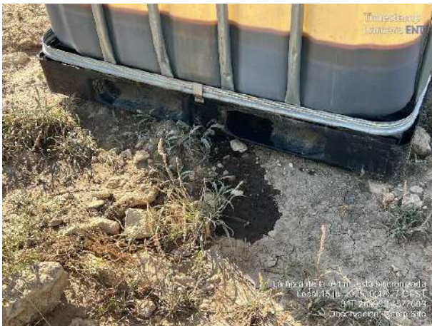
Derrame de líquido contaminado. Bandeja antiderrame al límite de desbordamiento.
