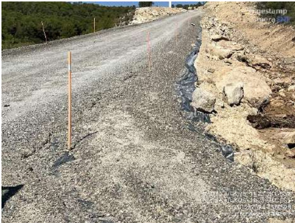
escorrentía y arrastre de material en vial de vaguada. Acopios de madera pendientes de retirada.
