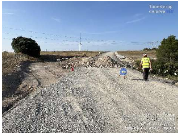
Retirado derrame en entronque. Ejecución de ODTs y bypass alternativo.
