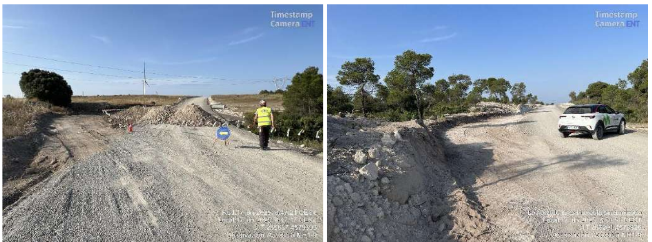
Imagen 1. Bypass ejecutados por corte en vial para instalación de ODTs.
